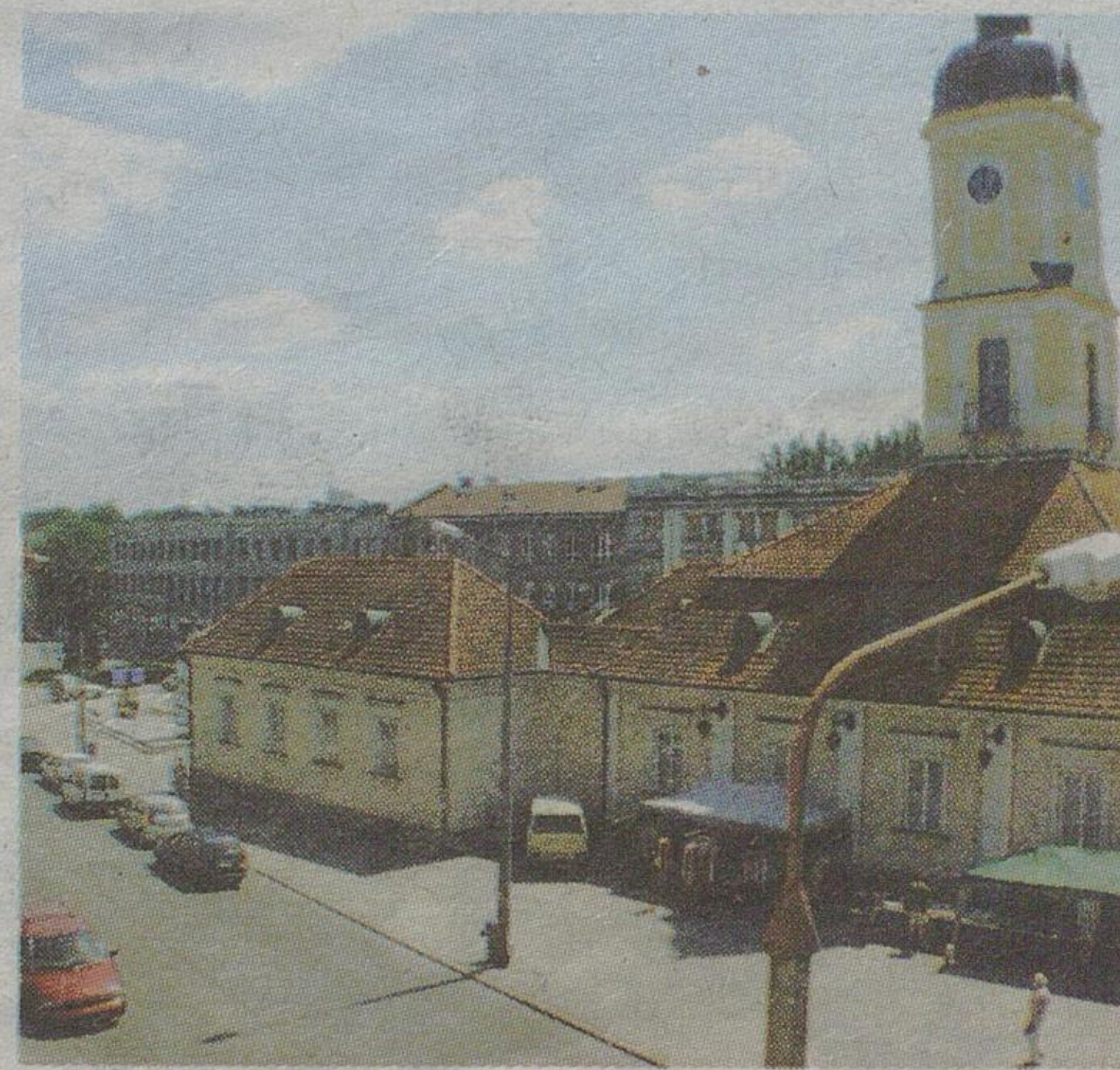
W okolicy ratusza remont będzie później
