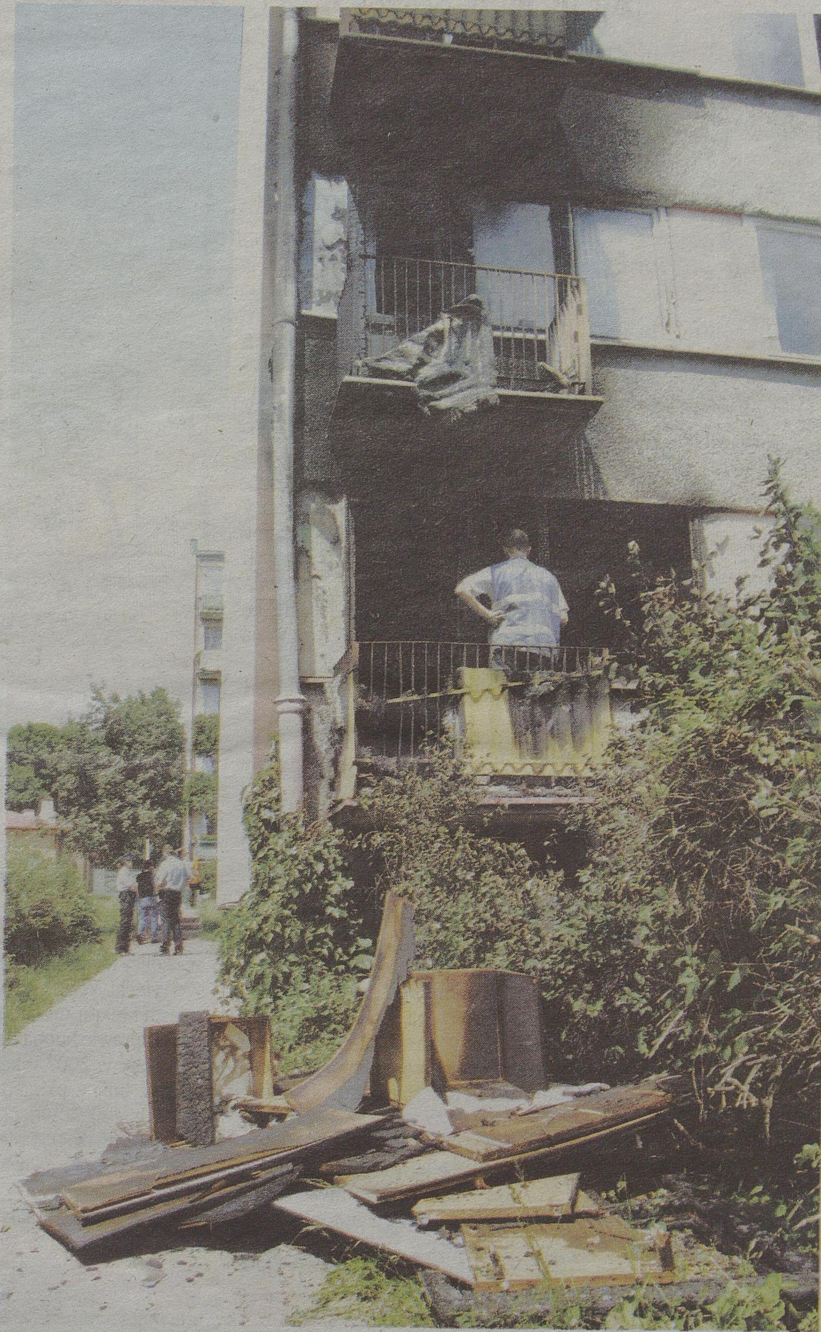
Mężczyzna, u którego na parterze wybuchł pożar, uratował się wyskakując przez okno. Nie żyją zaś dwie osoby, które były na trzecim piętrze.
