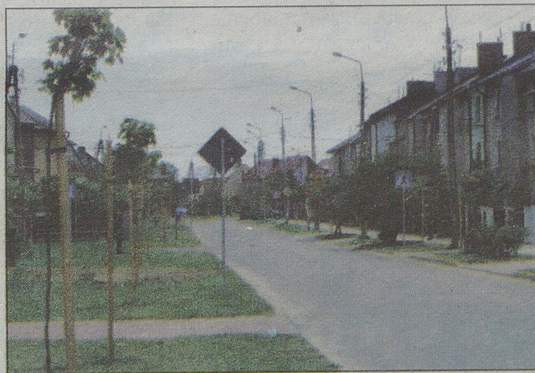
Budowa nawierzchni w ulicy Słowackiego
