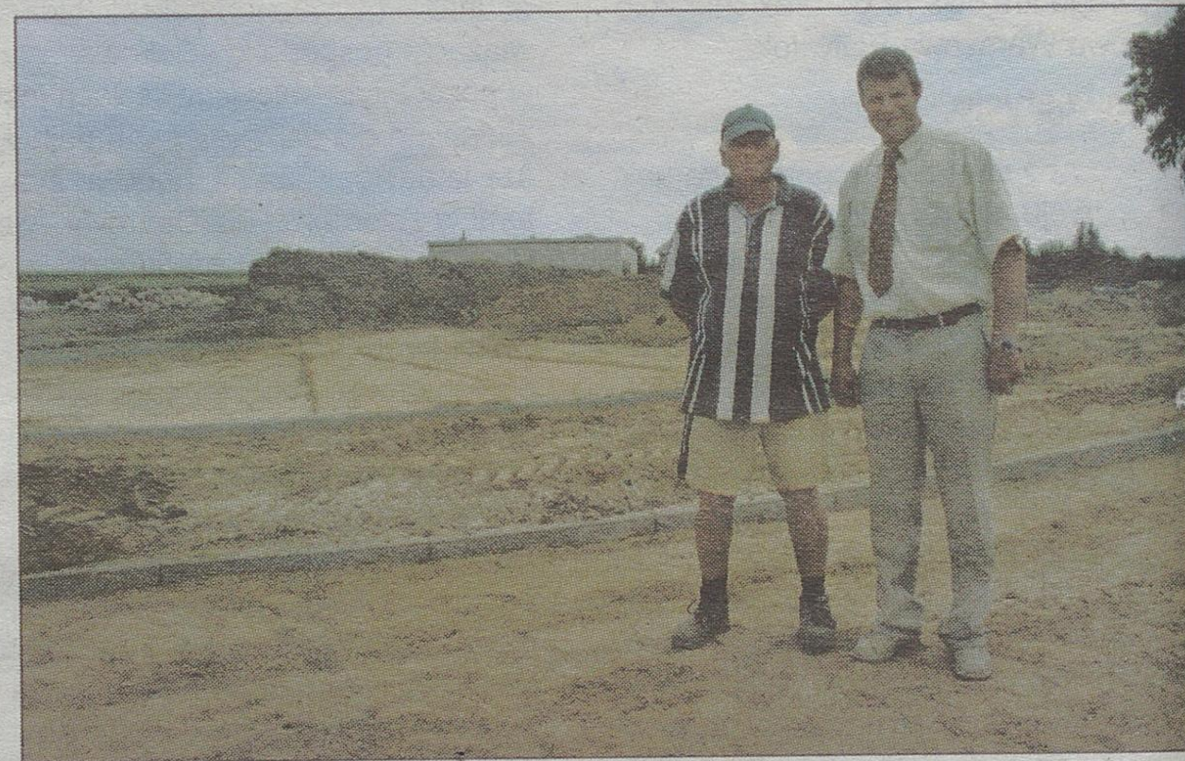
Wójt gminy Ryszard Pogorzelski (z prawej) na placu budowy nowego boiska przy szkole w Kobylinie - Borzymach
