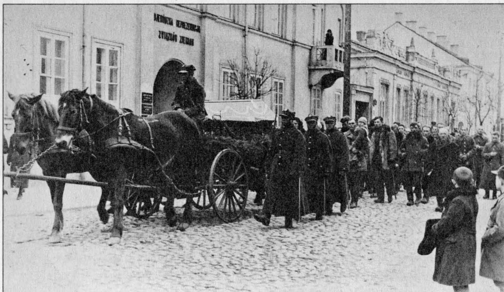
Na pierwszym planie budynek nr 9. Za nim w głębi widoczny budynek nr 11. Około 1930 roku.
