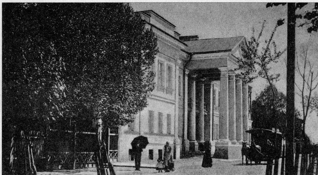
Pałac Commichau przed dobudową drugiego piętra. Przed 1897 rokiem.
