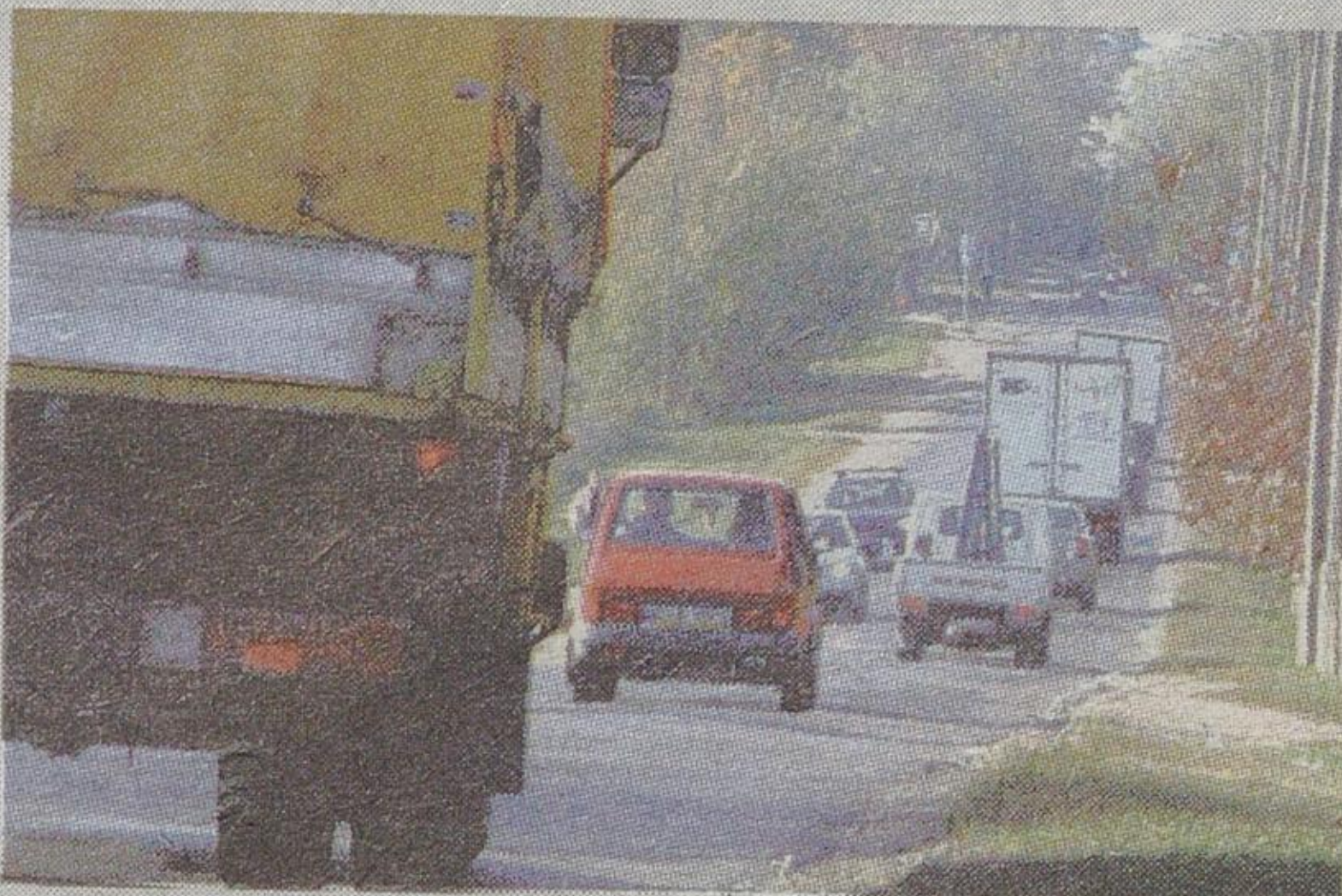
Ulica Popietuski – rozbudowa kolejnego odcinka drogi. Tym razem od ul. Sikorskiego do Boboli. Powstaną tu dwie oddzielne jezdnie, chodniki i ścieżka rowerowa.
