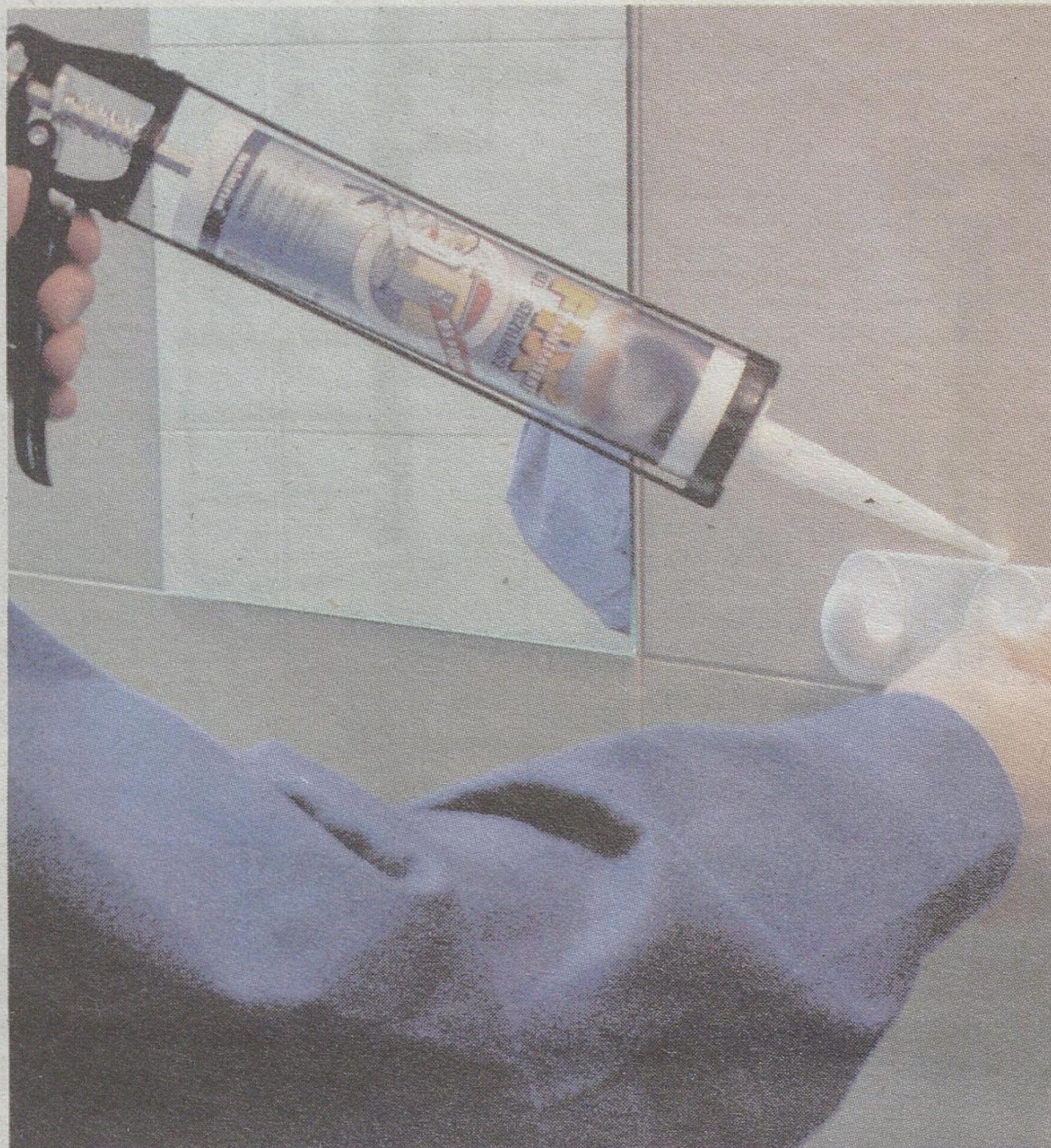
Klejenie w łazienkach wymaga zastosowania kleju odpornego na działanie wilgoci
