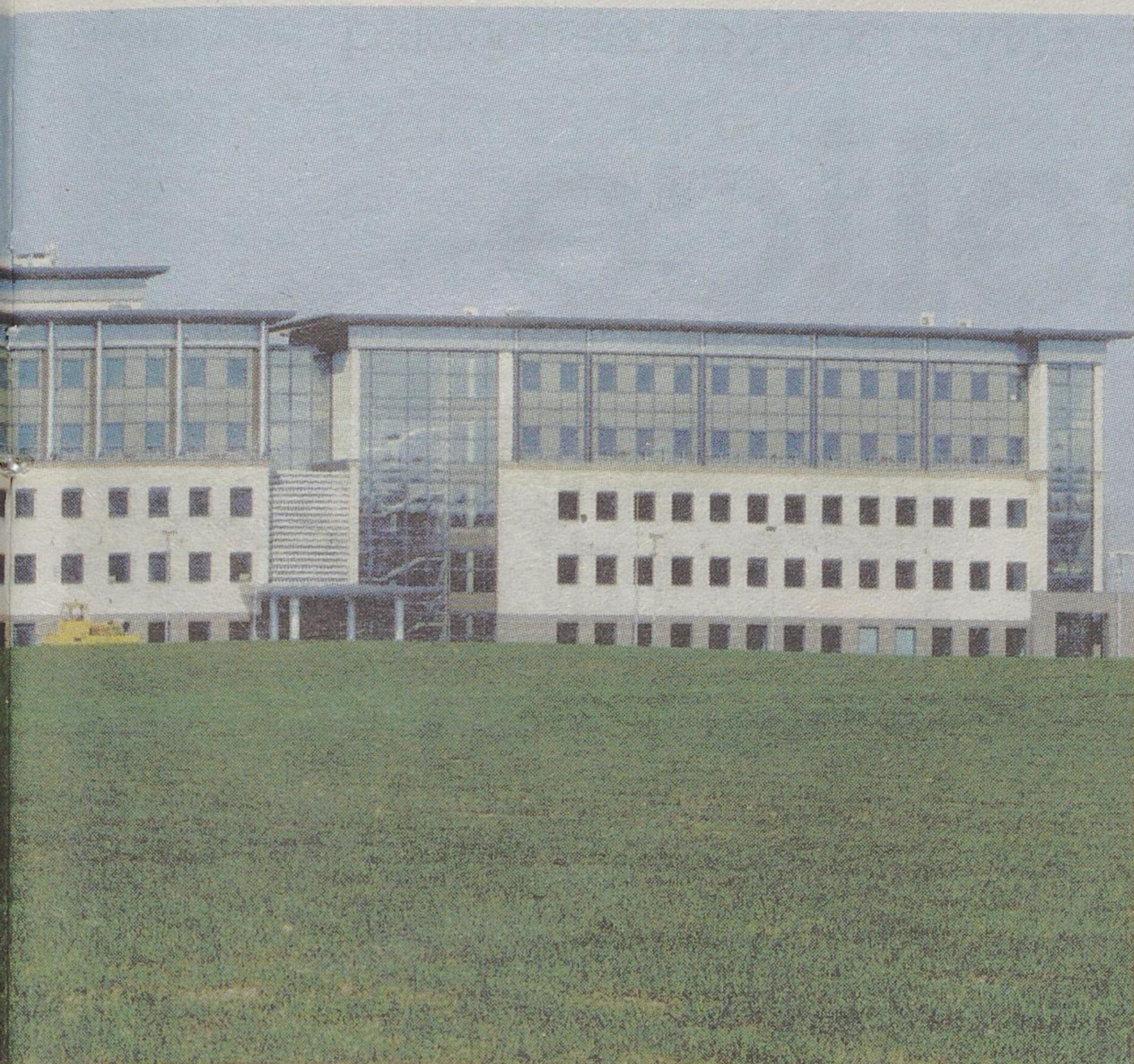
Nowy budynek sądu wygląda imponująco. Już niedługo jego budowa zostanie zakończona.
