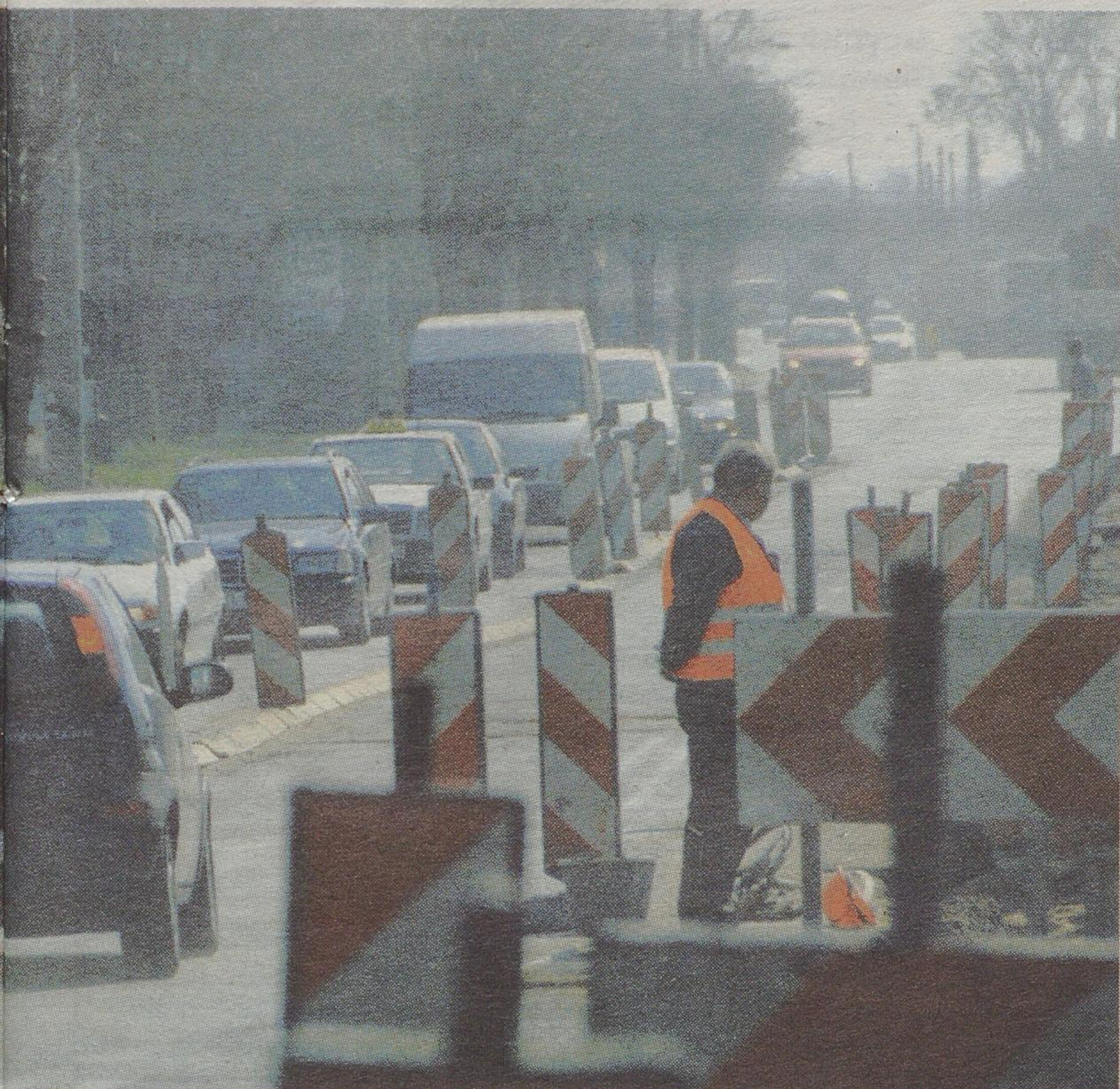
Problemem może być dojazd ulicą Mickiewicza. Właśnie trwa jej niewielka rozbudowa związana z budową galerii handlowej.
