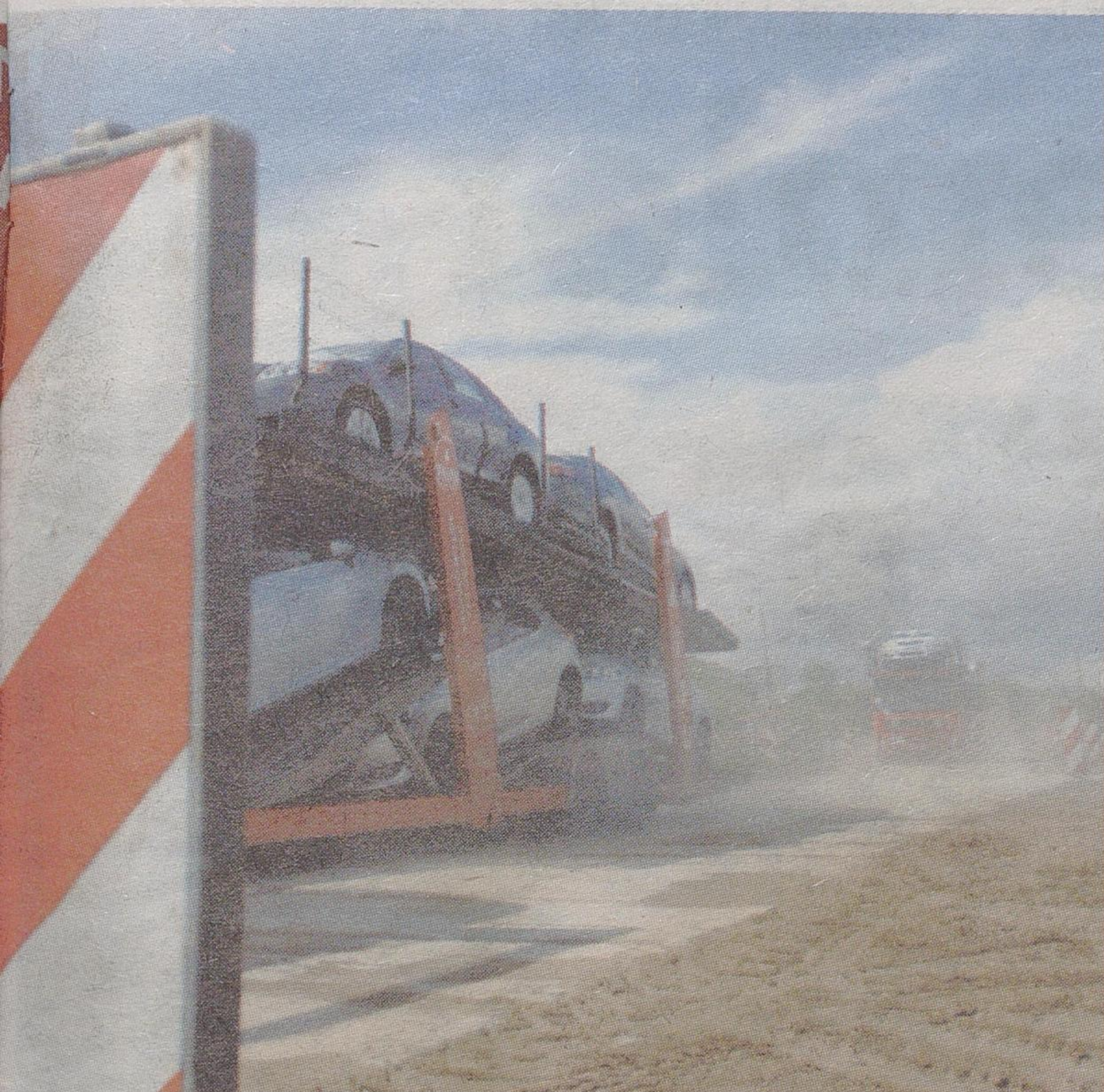
Ruch samochodów odbywa się teraz przez skrzyżowanie po tym- czasowej jezdni ułożonej z betonowych płyt
