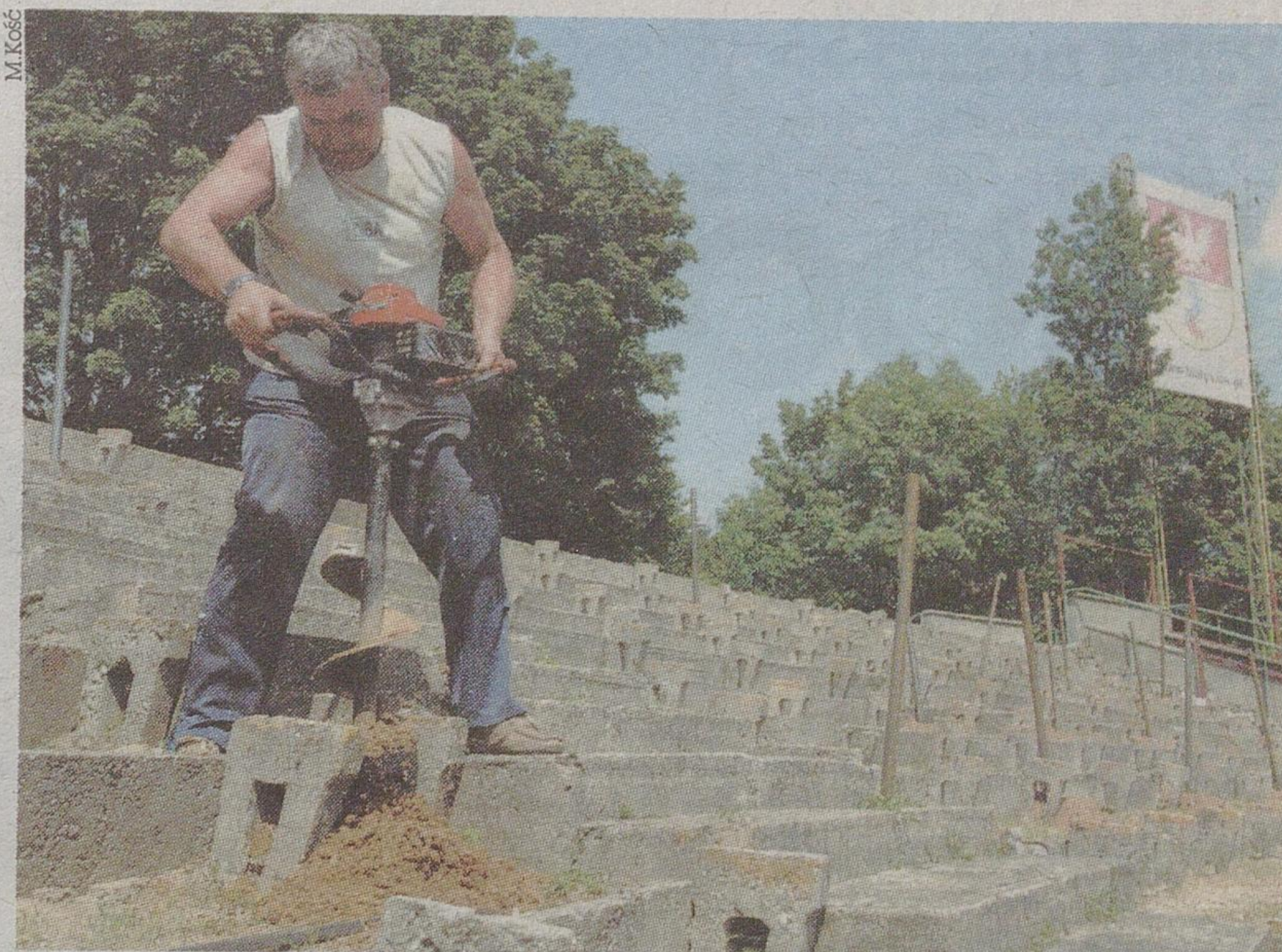
Na stadionie miejskim przygotowuje się już trybunę z miejscami stojącymi. Pojemność obiektu ma wynieść 10 000 widzów.
