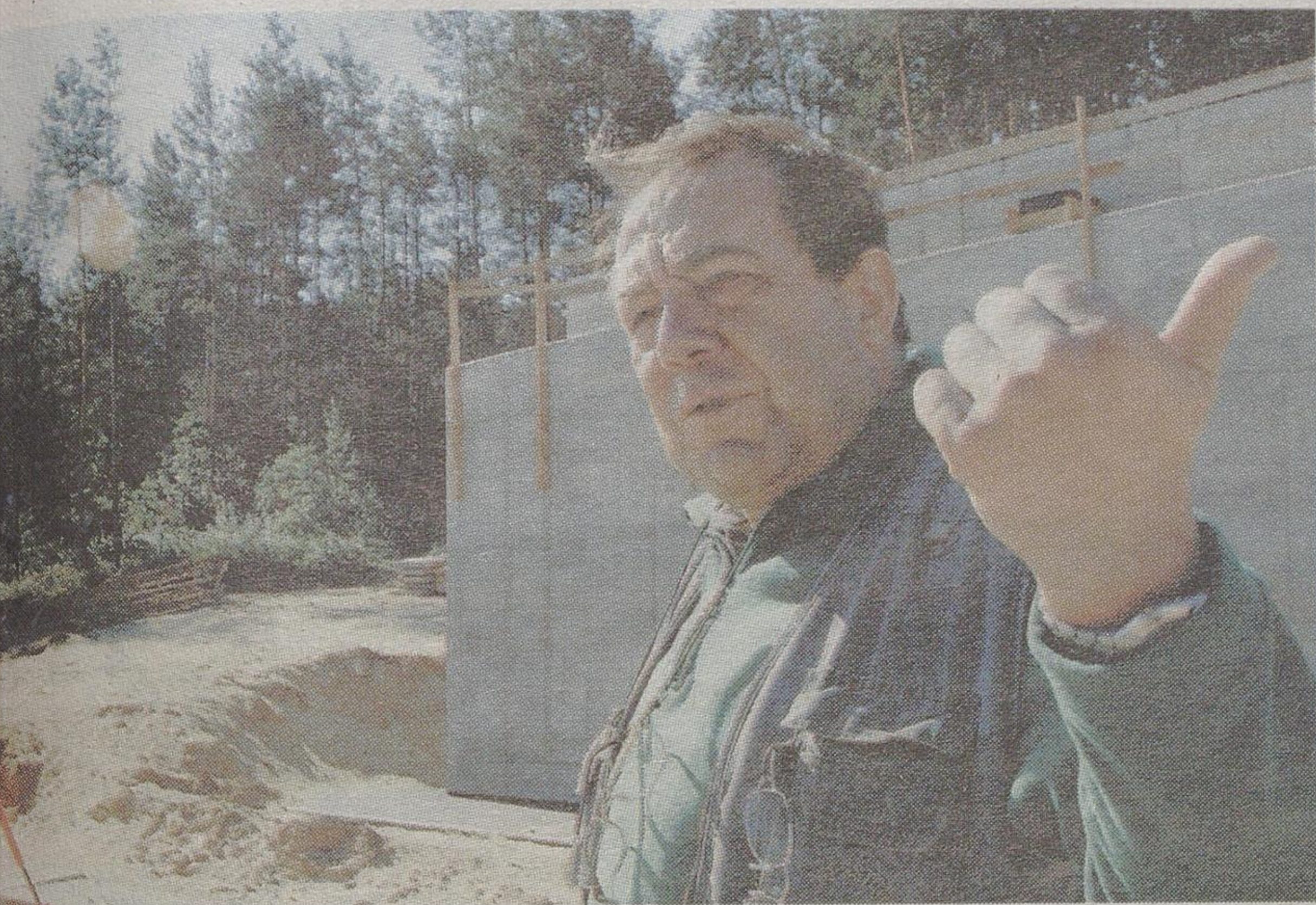
Majster Krzysztof Wyredek czeka na decyzję w sprawie dalszych prac na budowie w okolicach Woroszy i Sochoń. Tam stoi już jedna betonowa konstrukcja pod wiadukt.
