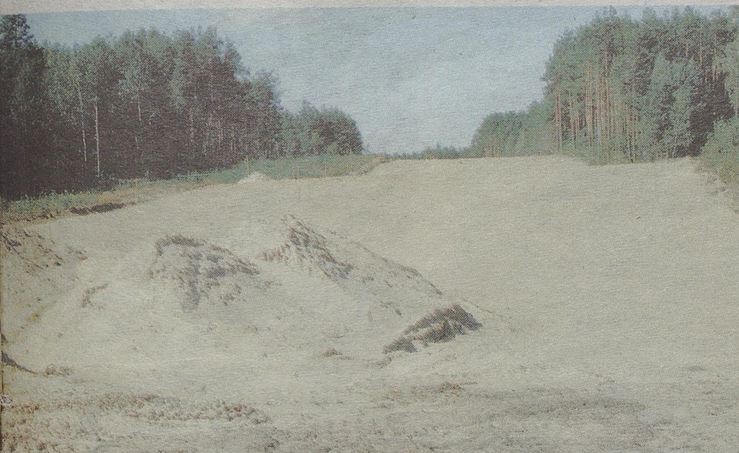
Między Sochoniami i Wasilkowem i dalej aż do Świętej Wody wi- dać już zarys trasy, którą ma przebiegać obwodnica
