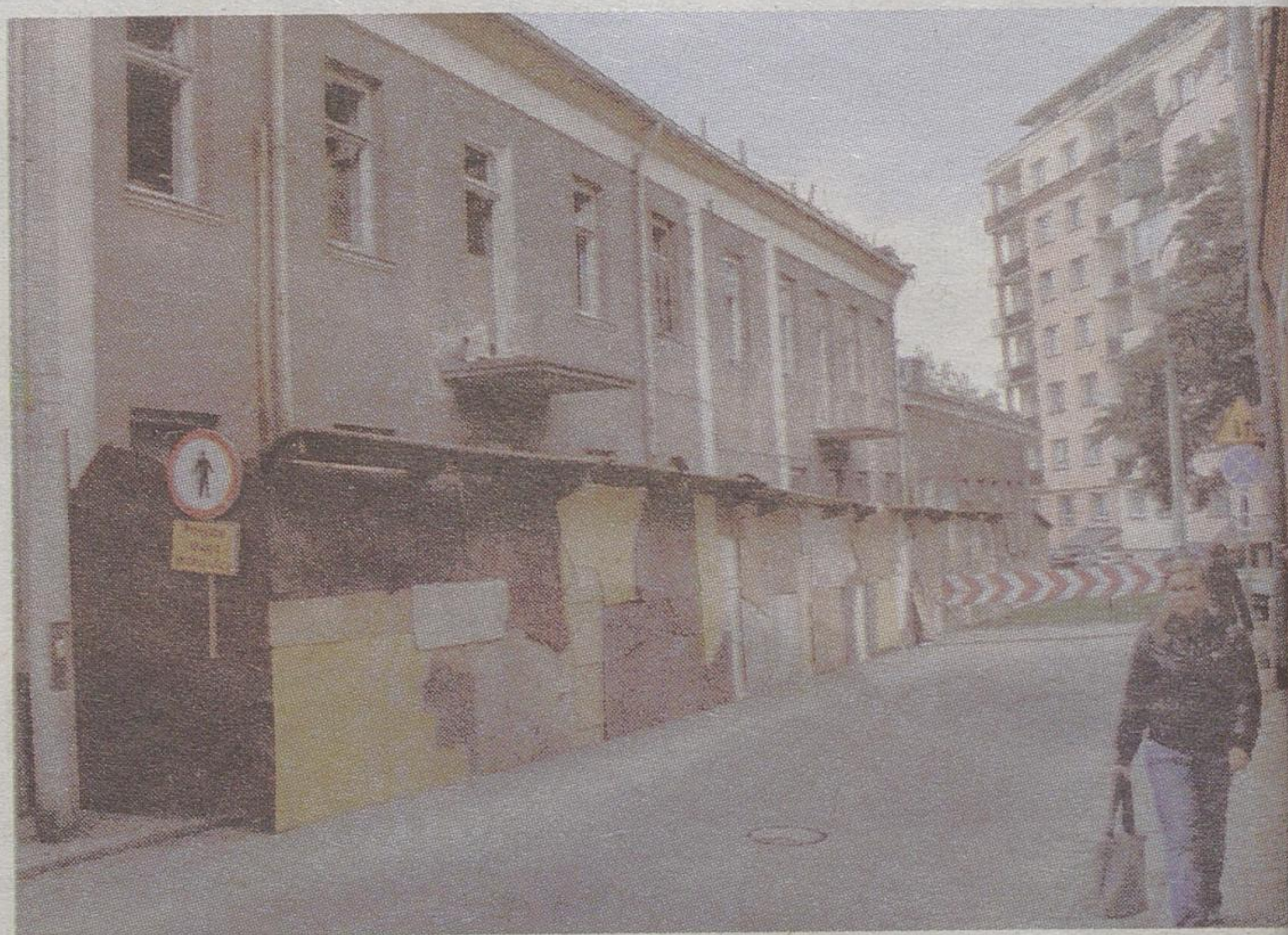
Kamienica przy ul. Waryńskiego 9 już wkrótce zostanie rozebrana. Niemal pewne jest, że nie będzie odbudowana.
