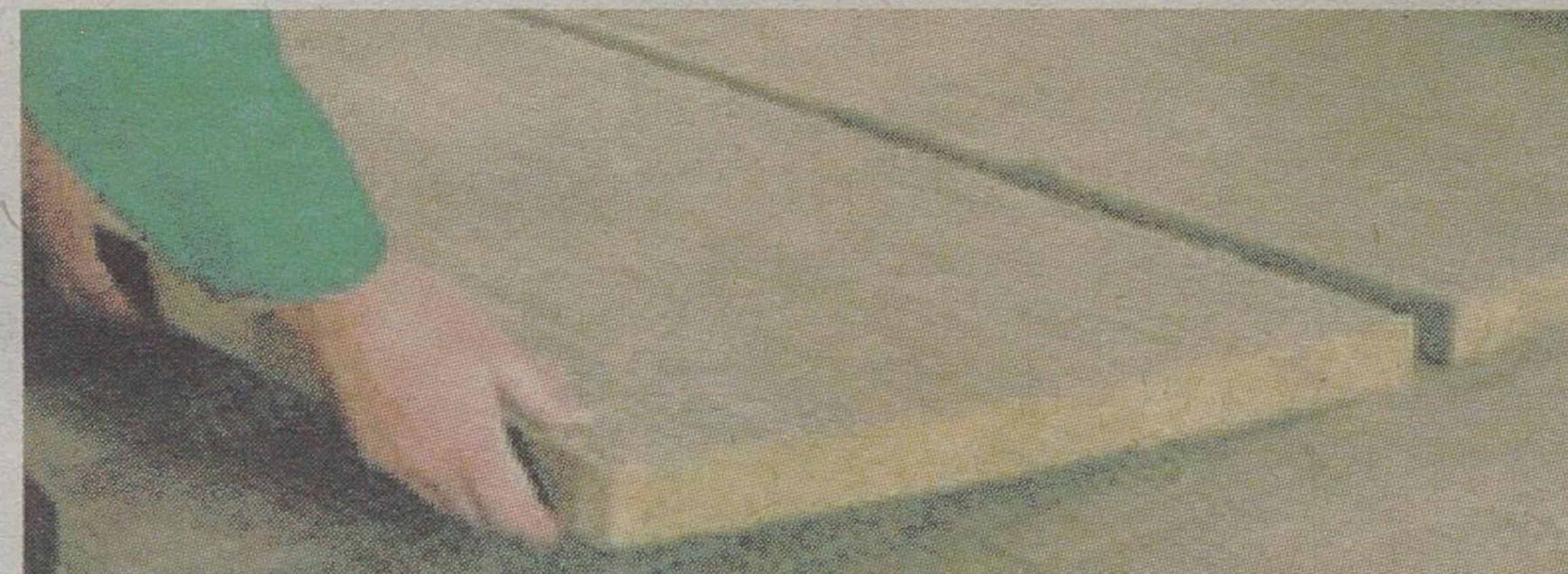
Układanie kolejnej warstwy konstrukcyjnej na podłożu, o której mówimy „pływająca”
