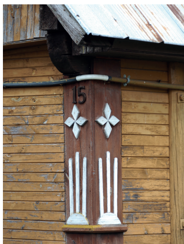
24. Siderka. Przykład zdobienia węgła domu. Fot. J. Kotyńska-Stetkiewicz, 2022 (w zbiorach NID OTB) Siderka. Example of corner decoration of a house. Photo by J. Kotyńska-Stetkiewicz, 2022 (in the collections of NID OTB)
