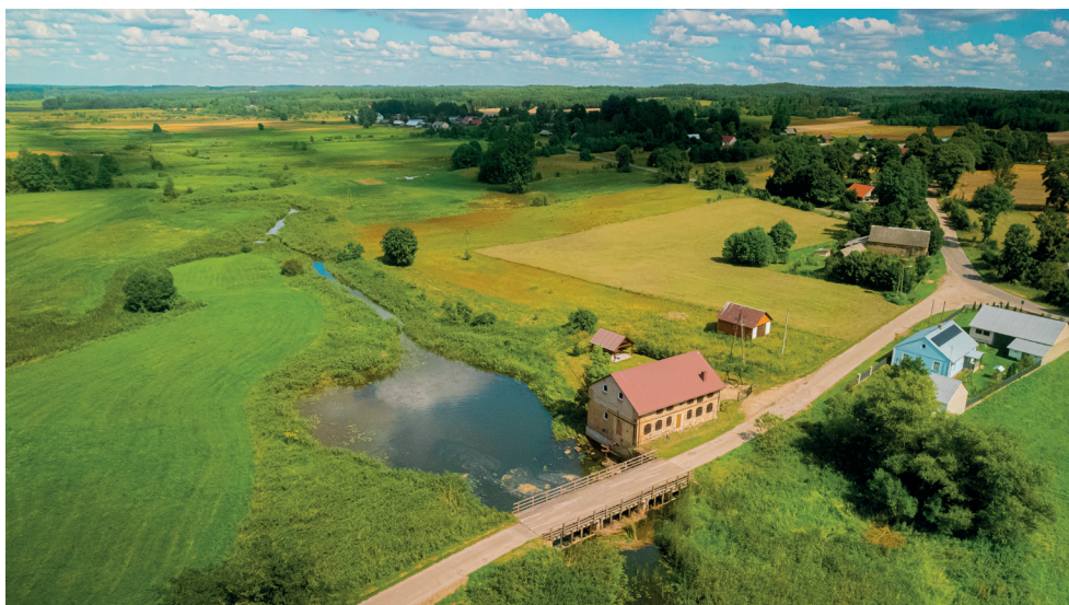
10. Siderka. Zdjęcie lotnicze, widok od pld.-zach. na młyn. Fot. J. Dziemidowicz Blaze Sound & Media, 2022 (w zbiorach NID OTB)
