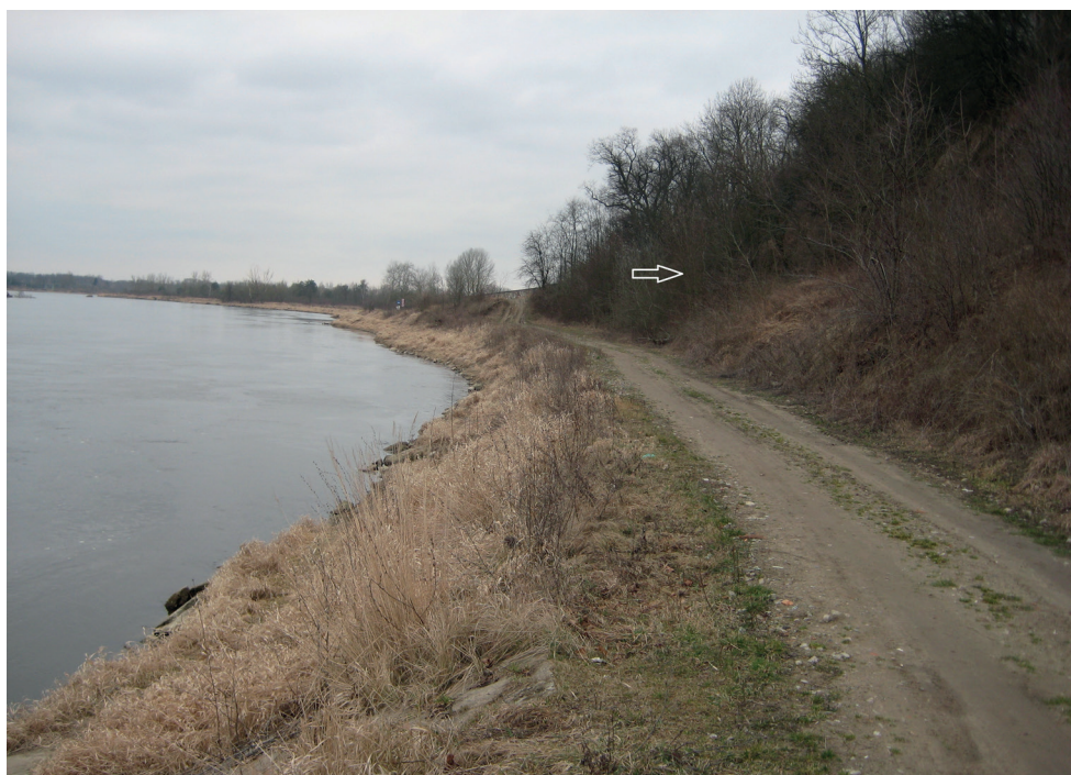
12. Drohiczyzn. Skarpa przy zniszczonym narożniku muru zespołu katedralnego z zasypanym wejściem do siedemnastowiecznego tunelu ewakuacyjnego (oznaczone strzałką). Stan z 2015 r.
