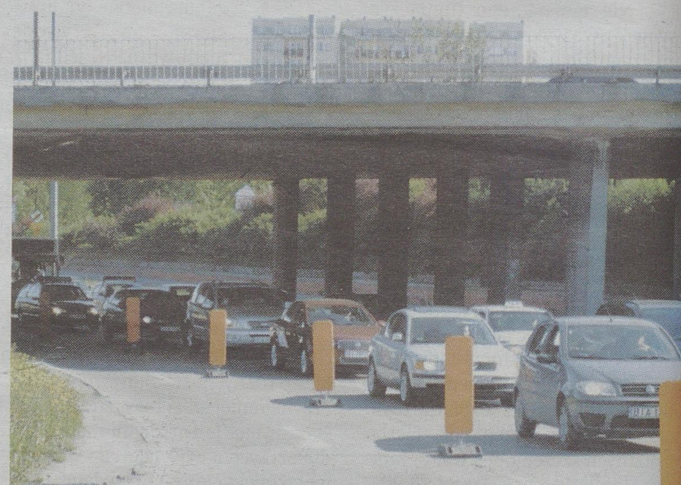
Z powodu remontu i kolizji, samochody jadące z ul. Antoniukowskiej poruszały się z dużymi problemami
