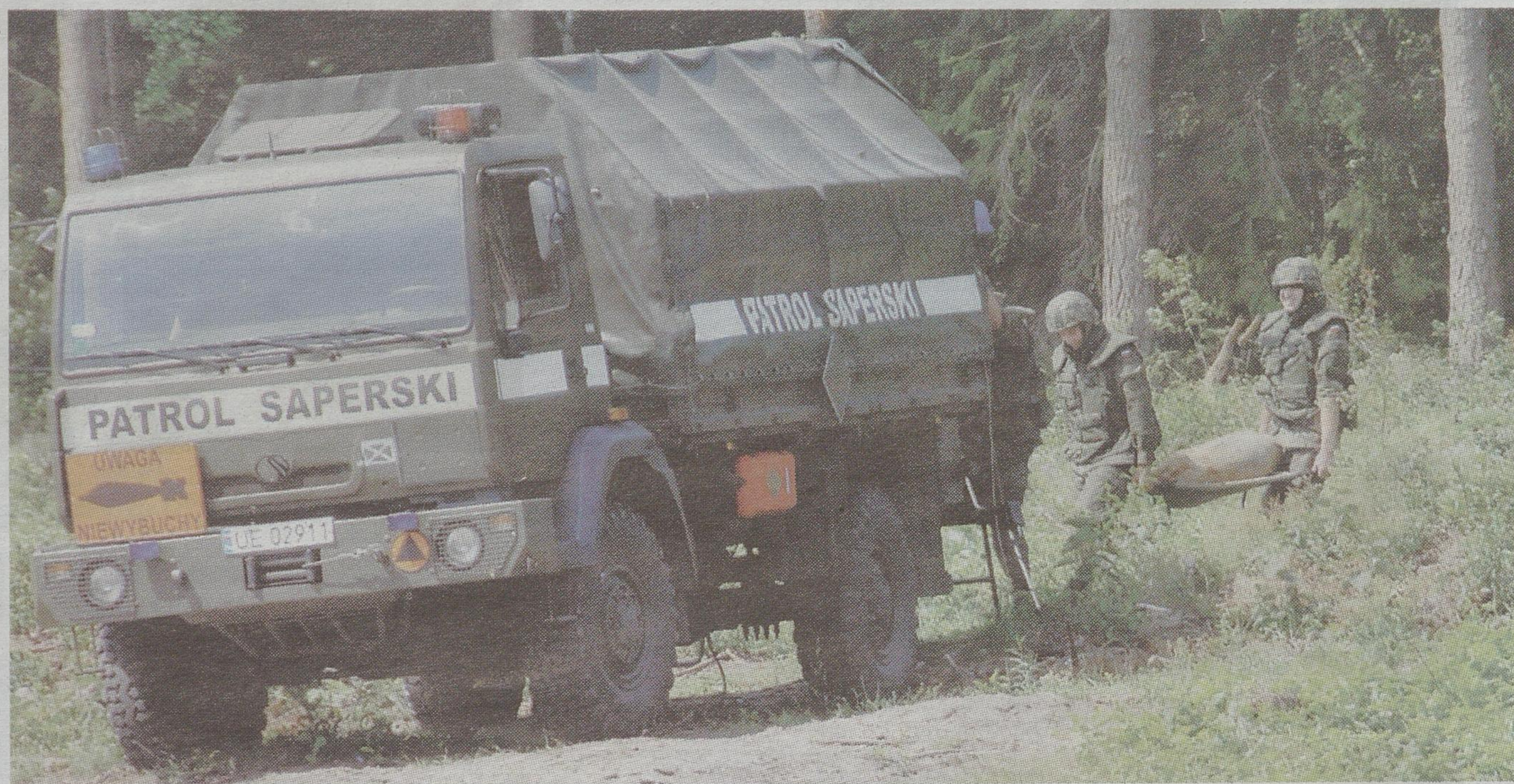
Patrol saperski wykopał bombę z ziemi, na której będzie rozbudowywana droga z Białegostoku do Augustowa. Żołnierze wywieźli ją na poligon, gdzie została zdetonowana.
