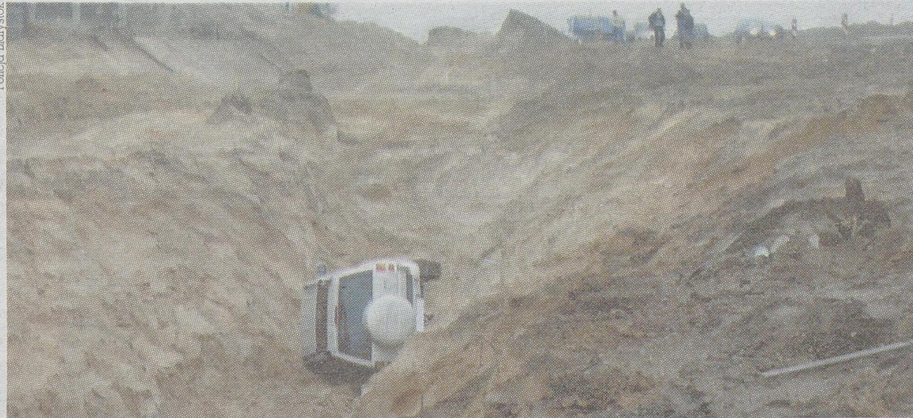
Terenowy samochód nie sprawdził się na takich wykopach – wpadł do 6-metrowej głębokości rowu. Według właściciela auto zostało ukradzione.
