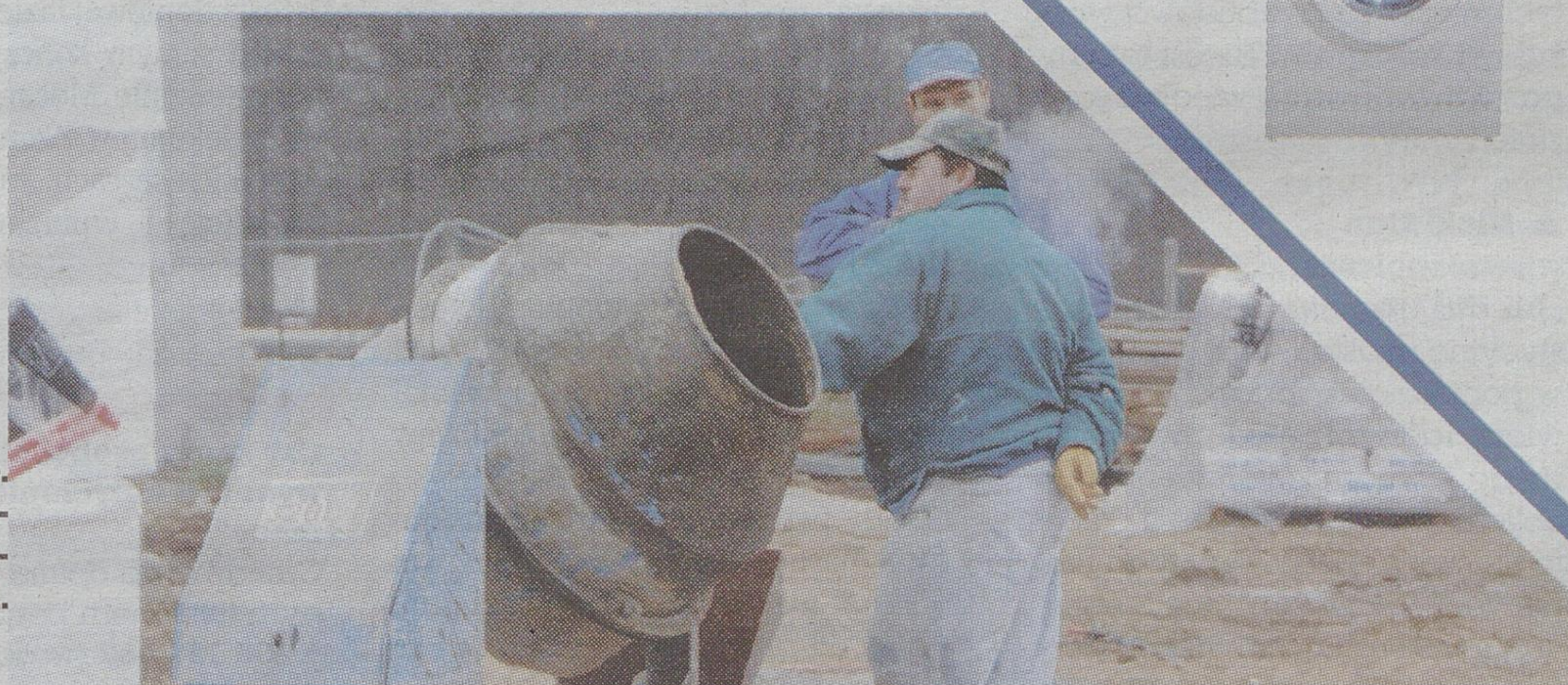
Kręci się. Wszystko wokół pracy i betoniarki.
