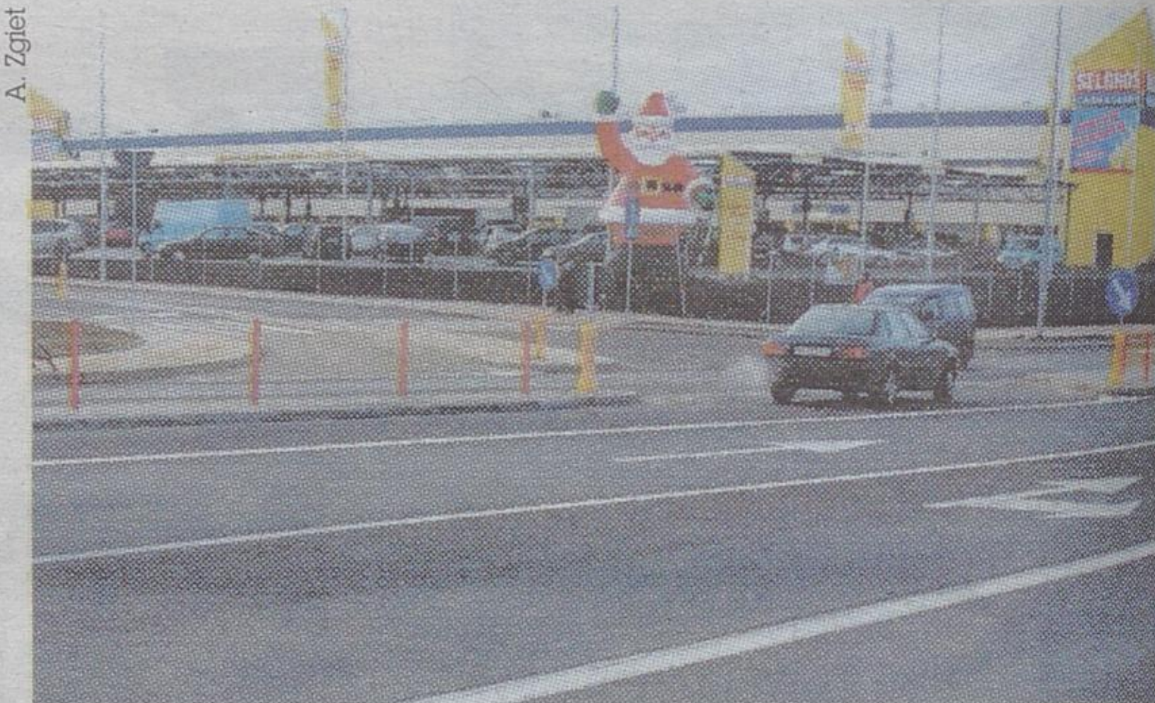
Selgros przebudowywał i modernizował ul. Produkcyjną
