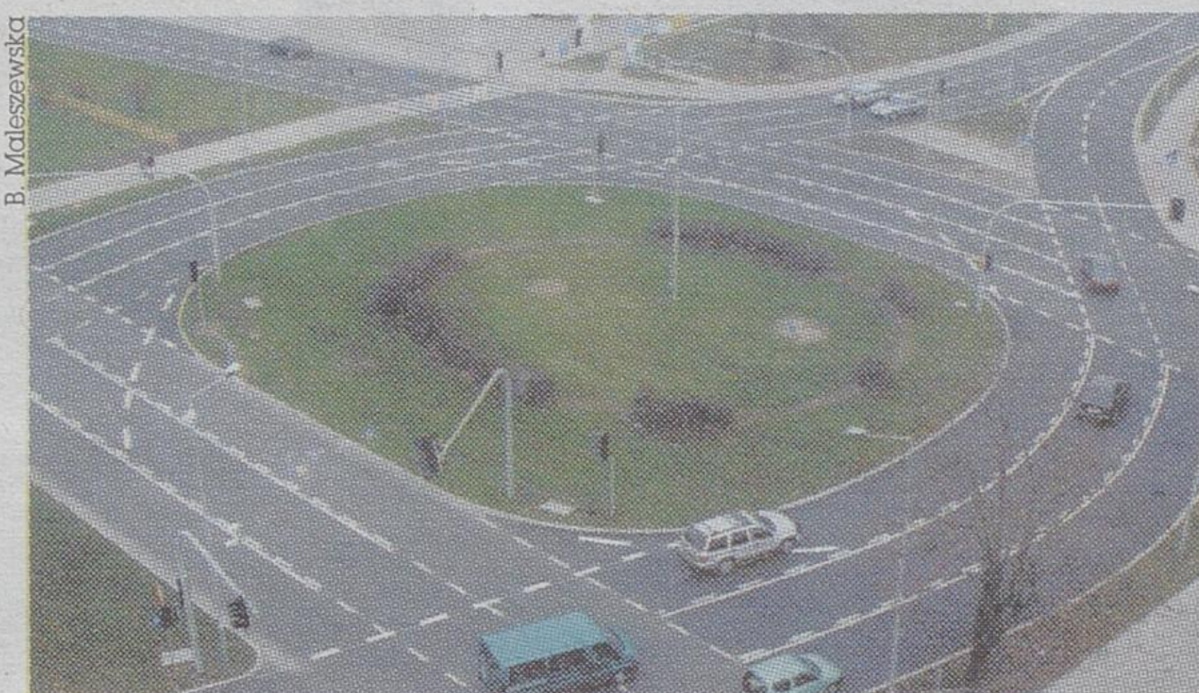
Skrzyżowanie ul. Hetmańskiej z Jana Pawła II przebudowano dzięki budowie nowego Auchan
