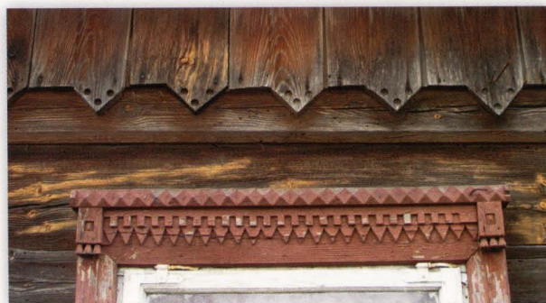
Szorce. Nadokiennik zdobiony motywami geometrycznymi w formie trzech ząbkowanych ornamentów pasowych. Widoczne dolne, zdobione zakończenie desek szalunku szczytu.
