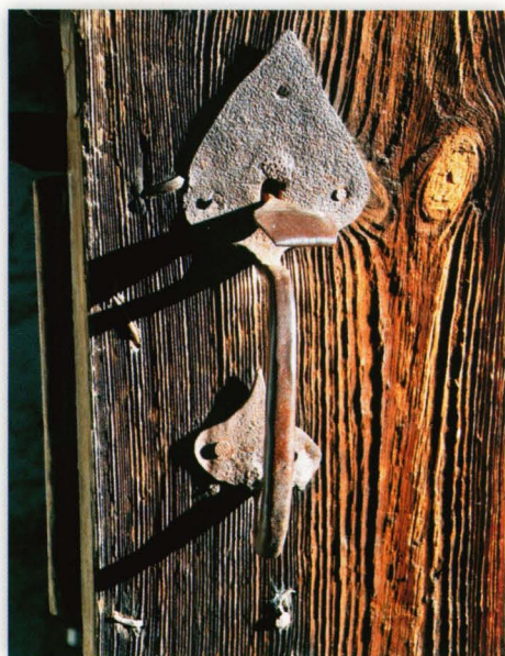
Goniądz, ul. Jagiellońska 2. Wykładka zamka zapadkowego w drzwiach zewnętrznych w młynie. Tego typu zamki były powszechnie stosowane na Podlasiu jeszcze w połowie XX wieku.
