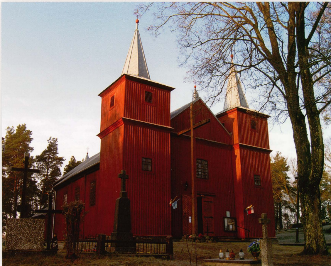
Jaminy. Kościół pod wezwaniem św. Mateusza zbudowany w latach osiemdziesiątych XVIII wieku w Augustowie, przeniesiony na obecne miejsce w połowie XIX wieku. Konstrukcja ścian wieńcowa, posadowiona na fundamencie z kamieni polnych łączonych zaprawą cementowo-wapienną. Wnętrze kościoła trójnawowe, z kruchtą przy ścianie frontowej. Z obu stron fasady trójkondygnacyjne wieże.
