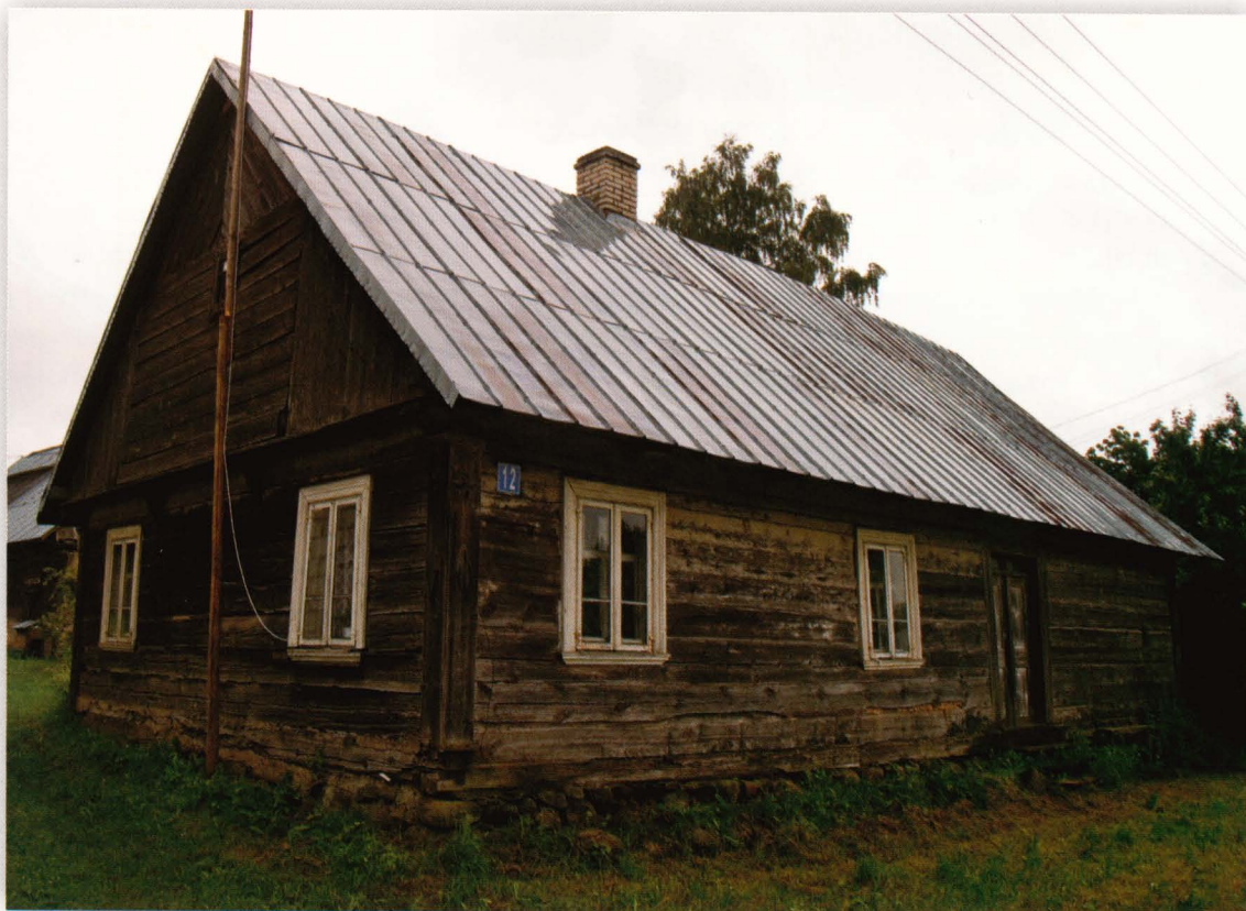
Lipszczany 12. Dom z przełomu XIX i XX wieku, usytuowany frontem do drogi. Wymiary: 8x15 m. Fundament z kamieni polnych łączonych cementową zaprawą. Naroża szalowane deskami z elementami zdobniczymi. Okna ościeżnicowe, czterokwaterowe. Drzwi zewnętrzne dwuskrzydłowe. Dach dwuspadowy, kryty blachą.
