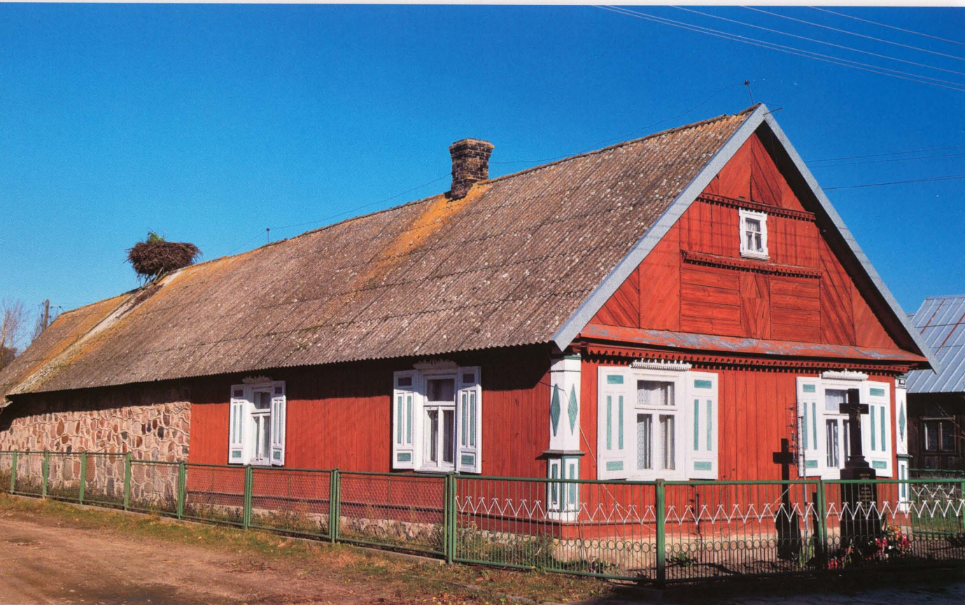
Zabiele 95. Budynek łączący pod jednym dachem drewnianą część mieszkalną i murowaną gospodarczą. Jest to jedna z charakterystycznych cech budynków mieszkalnych znajdujących się w miejscowościach położonych na obszarze gmin nadbiebrzańskich.
