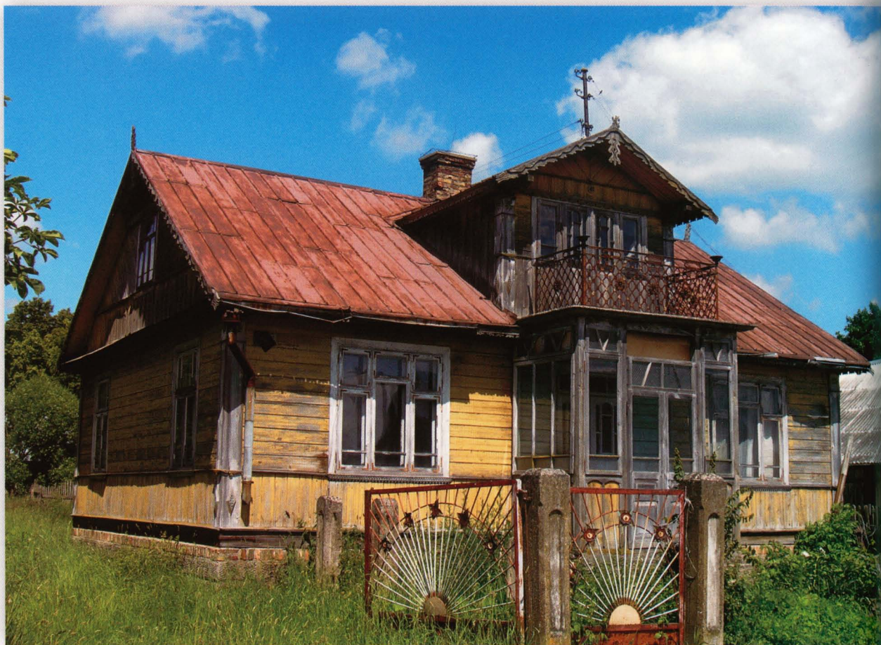
Wyłudki 5. Dom z końca lat dwudziestych XX wieku, z werandą i facjatą w ścianie frontowej. Dach werandy tworzy taras z metalową, zdobioną balustradą.
