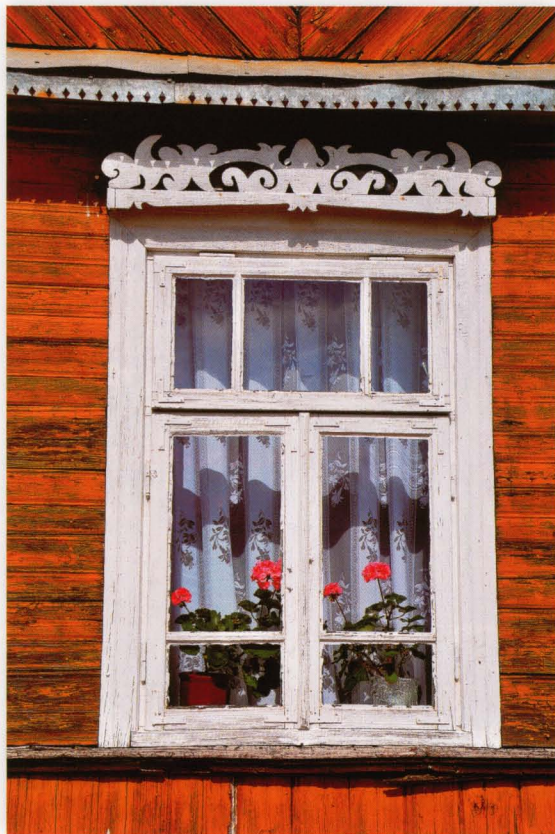
Domuraty 13. Okno domu z połowy lat dwudziestych XX wieku z wysuniętym nadokiennikiem typu nalicznik. Okno ościeżnicowe, dwuskrzydłowe, ze skrzydłami otwieranymi u dołu w osi pionowej,
