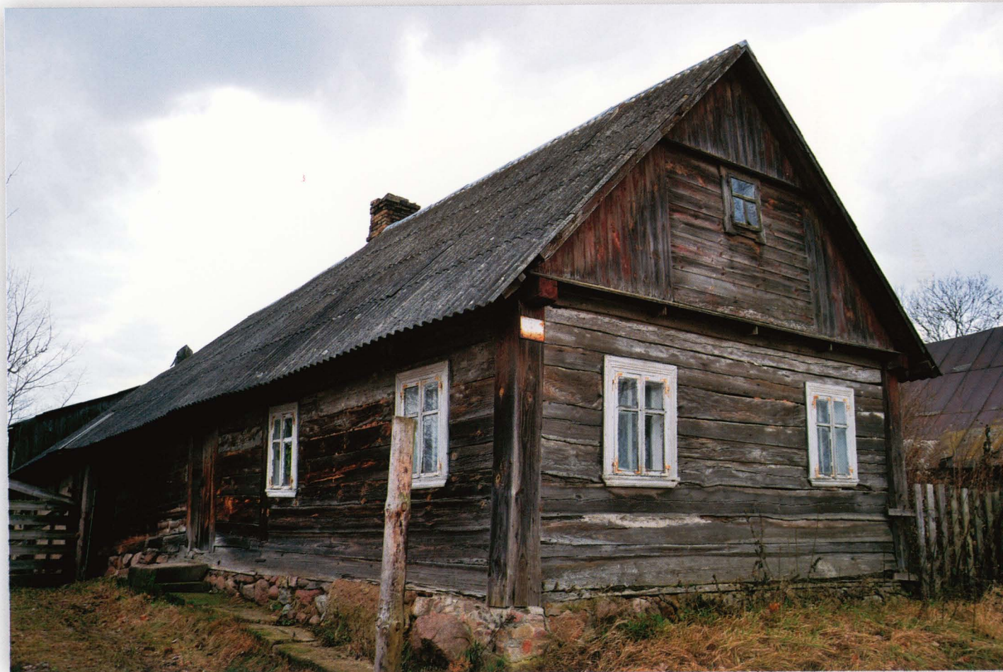
Nowy Dwór, ul. Dąbrowska. Dom z początku XX wieku posadowiony na fundamencie z kamieni polnych. Ściany o konstrukcji wieńcowej i sumikowo-łatkowej. Dach dwuspadowy, kryty eternitem.
