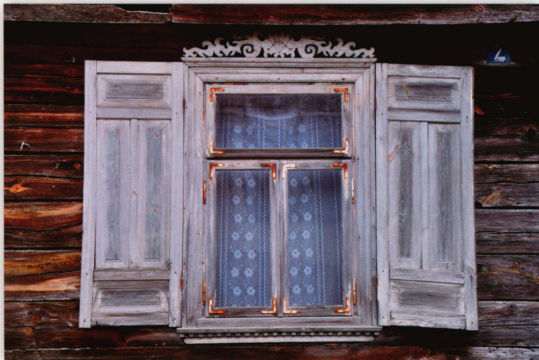
Rutkowszczyzna 2. Okno domu z 1924 roku, ościeżnicowe typu polskiego, z okiennicami o typowym układzie płycin. Nadokiennik z motywami geometryczno-fitomorficznymi.
