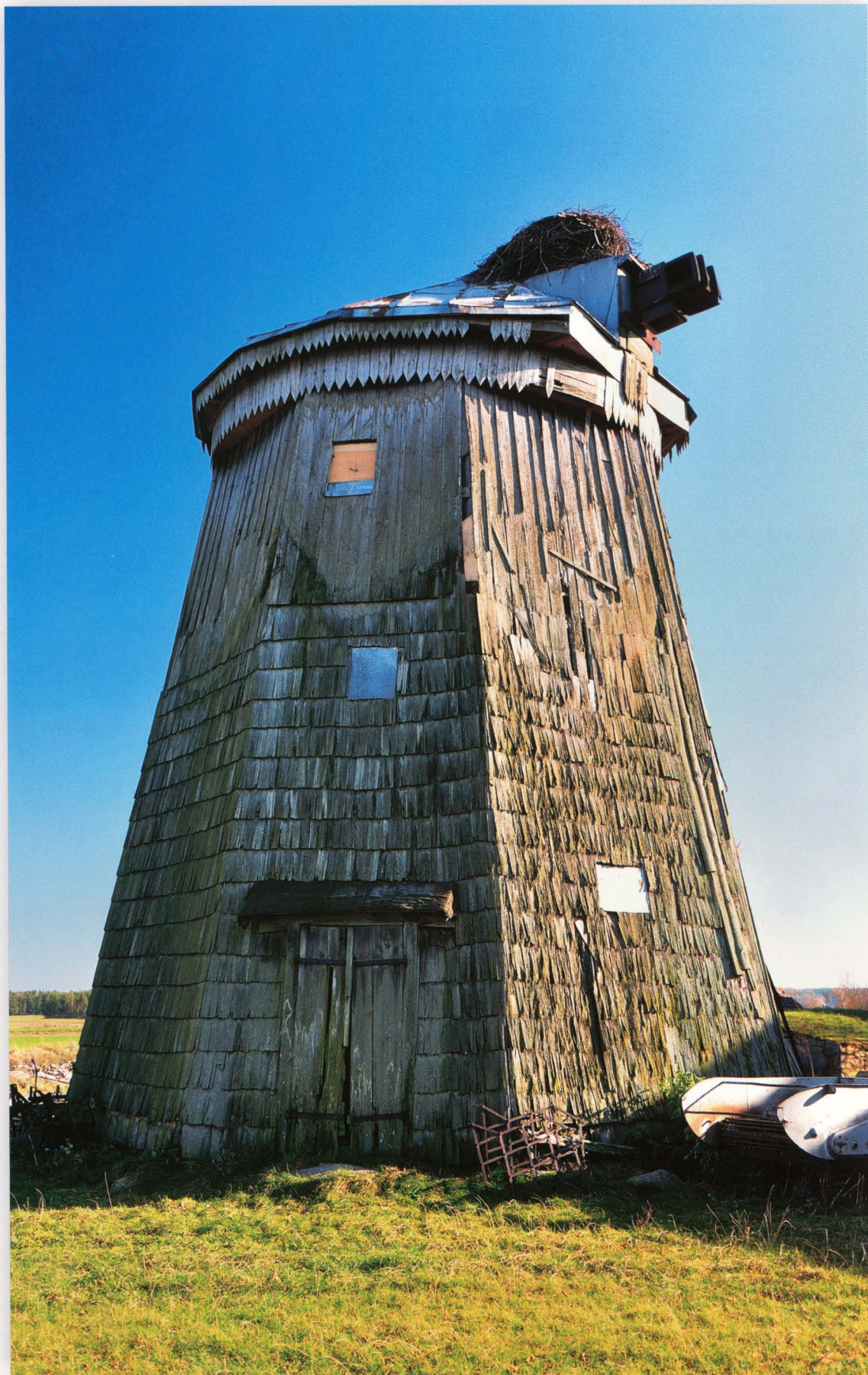
Zabiele. Wiatrak typu holenderskiego, zbudowany w 1928 roku. Konstrukcja ścian słupowo-ramowa, dach wielopiętrowy z blachy. Brak śmigieł.
