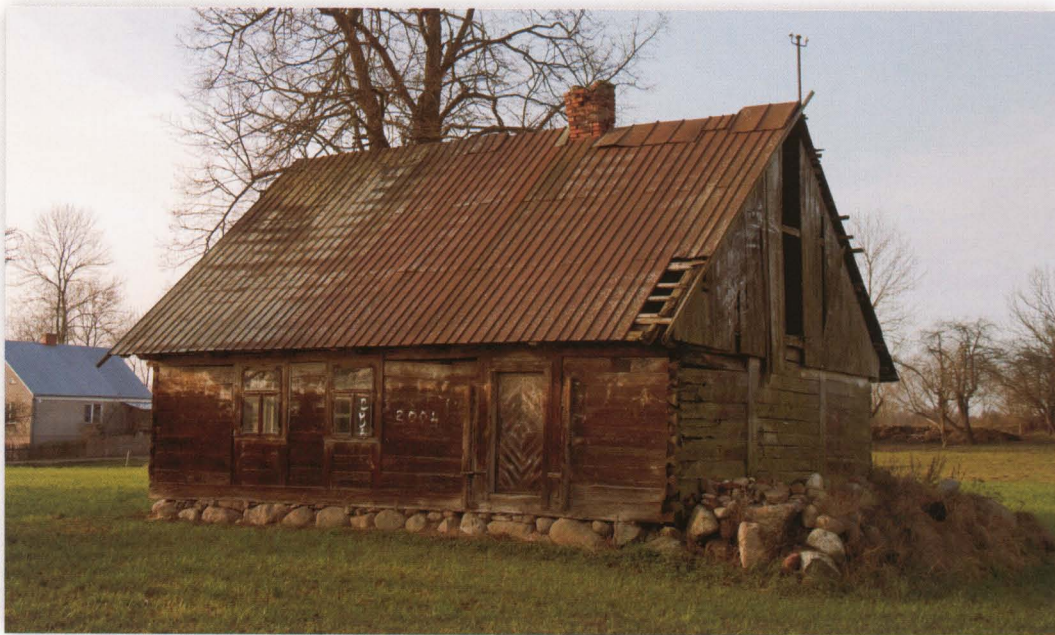
Stara Kamionka. Dom z przełomu XIX i XX wieku, jeden z nielicznych przykładów dawnego drewnianego budownictwa z terenu gminy Bargłów Kościelny. Budynek posadowiony na fundamencie z kamieni, ze ścianami o konstrukcji sumikowo-łątkowej. Uwagę zwracają zdobione drzwi.
