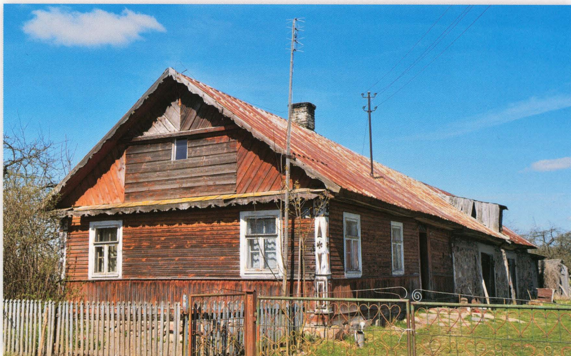
Suchodolina. Budynek łączący pod jednym dachem część mieszkalną i gospodarczą, przy czym część gospodarcza ma ściany murowane. W szczycie wiatrownice i listwa podokapowa.
