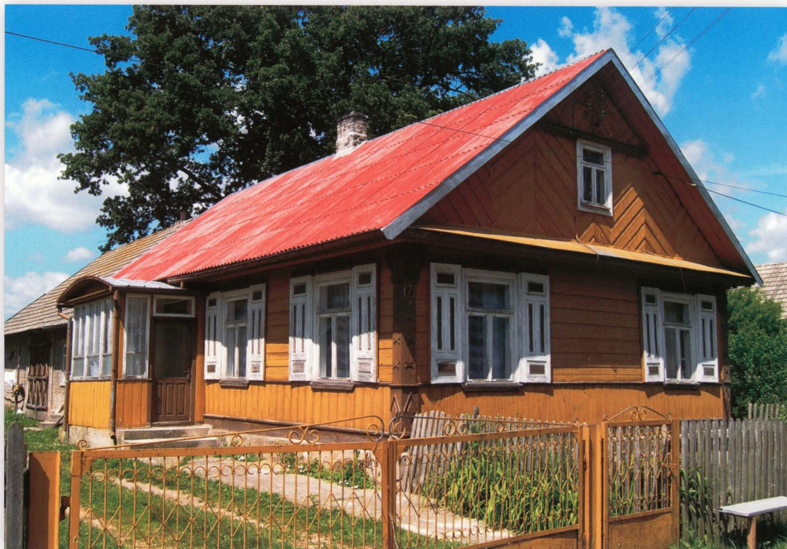
Laskowszczyzna 7. Dom z lat trzydziestych XX wieku, posadowiony na fundamencie z kamieni polnych łączonych zaprawą cementową. Ściany o konstrukcji zrębowej, szalowane deskami w typowym układzie – do dolnej krawędzi okna pionowym, powyżej poziomym. Weranda z łukowatym daszkiem.
