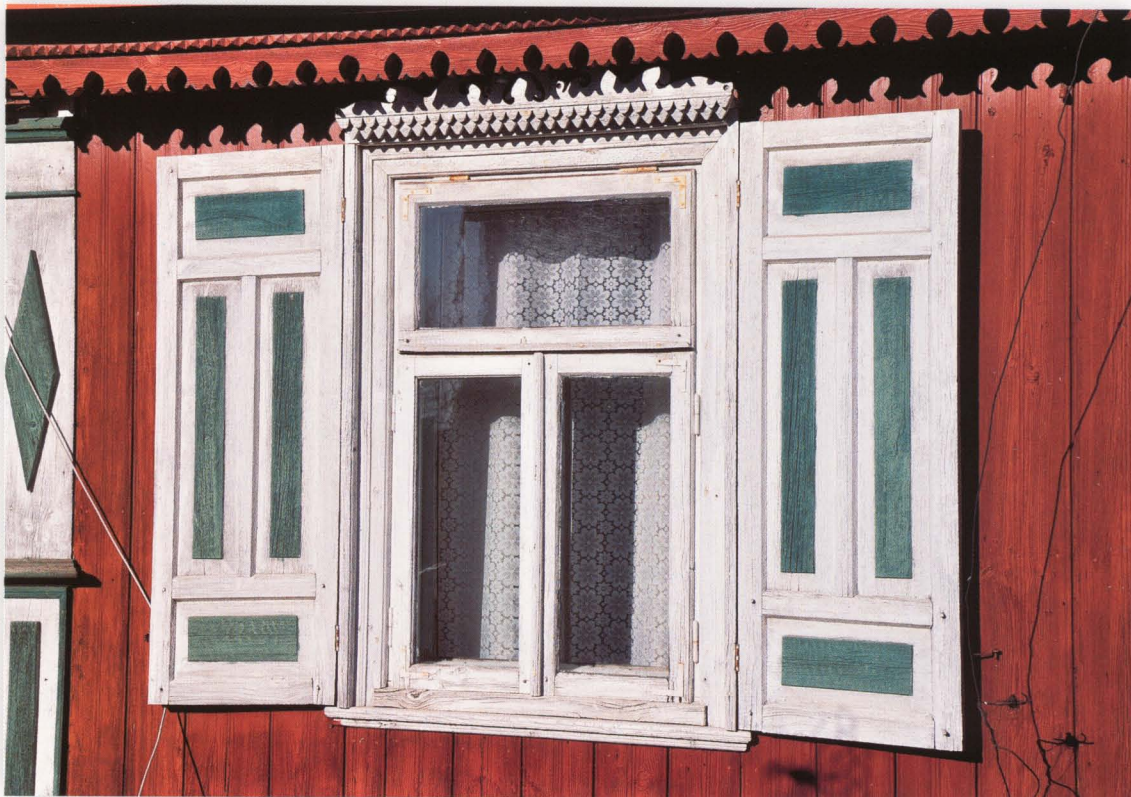
Zabiele 95. Okno ościeżnicowe, ze zdobionym nadokiennikiem typu nalicznik oraz płycinowo-ramowymi okiennicami. Naliczniki to wysunięte poza płaszczyznę okna okapniki chroniące okno od deszczu.
