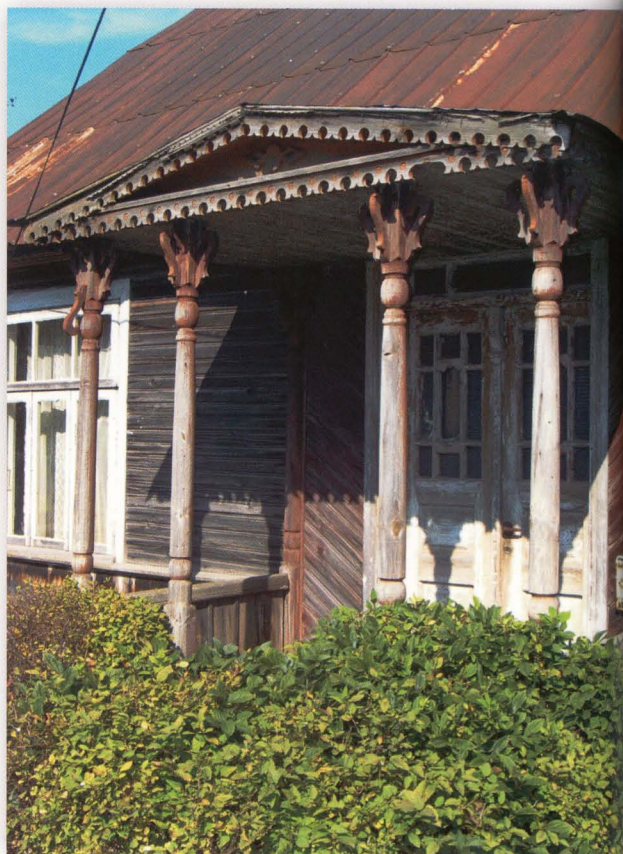
Jaświły. Ganek z sześcioma słupkami, ze zdobieniem tworzącym formę kapitelu. Dwuspadowy daszek zdobiony wiatrownicami i listwą podokapową.
