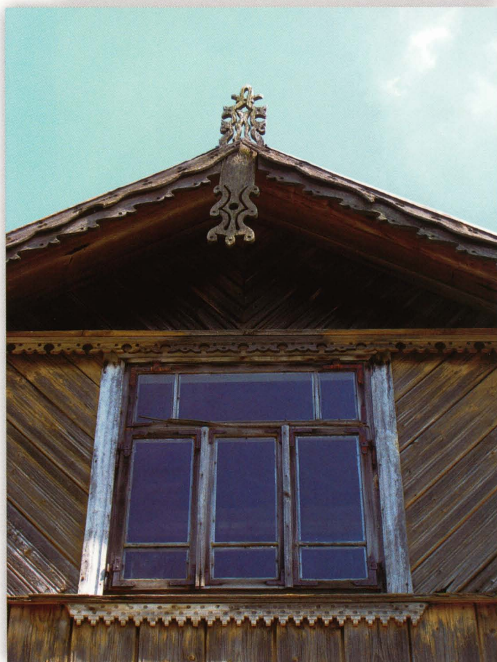
Wyłudki 5. W miejscu krzyżowania się wiatrownic przybite są pazdury o profilowanie wyciętych krawędziach.
