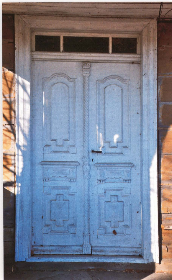
Stare Dolistowo 14. Drzwi zewnętrzne, dwuskrzydłowe, płycinowe, zdobione geometrycznymi motywami. Przy górnej krawędzi drzwi przeszklone nadświetle.
