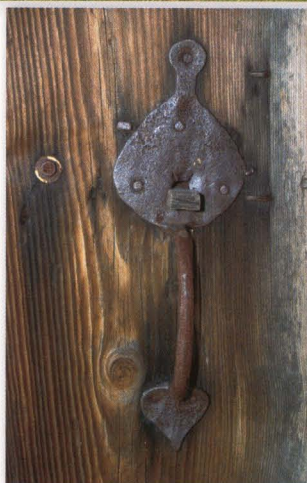
Jaświły 77. Wykładka zamka zapadkowego o typowym kształcie, kowalskiej roboty. Tego typu zamki były powszechnie stosowane do połowy ubiegłego wieku na całym Podlasiu.
