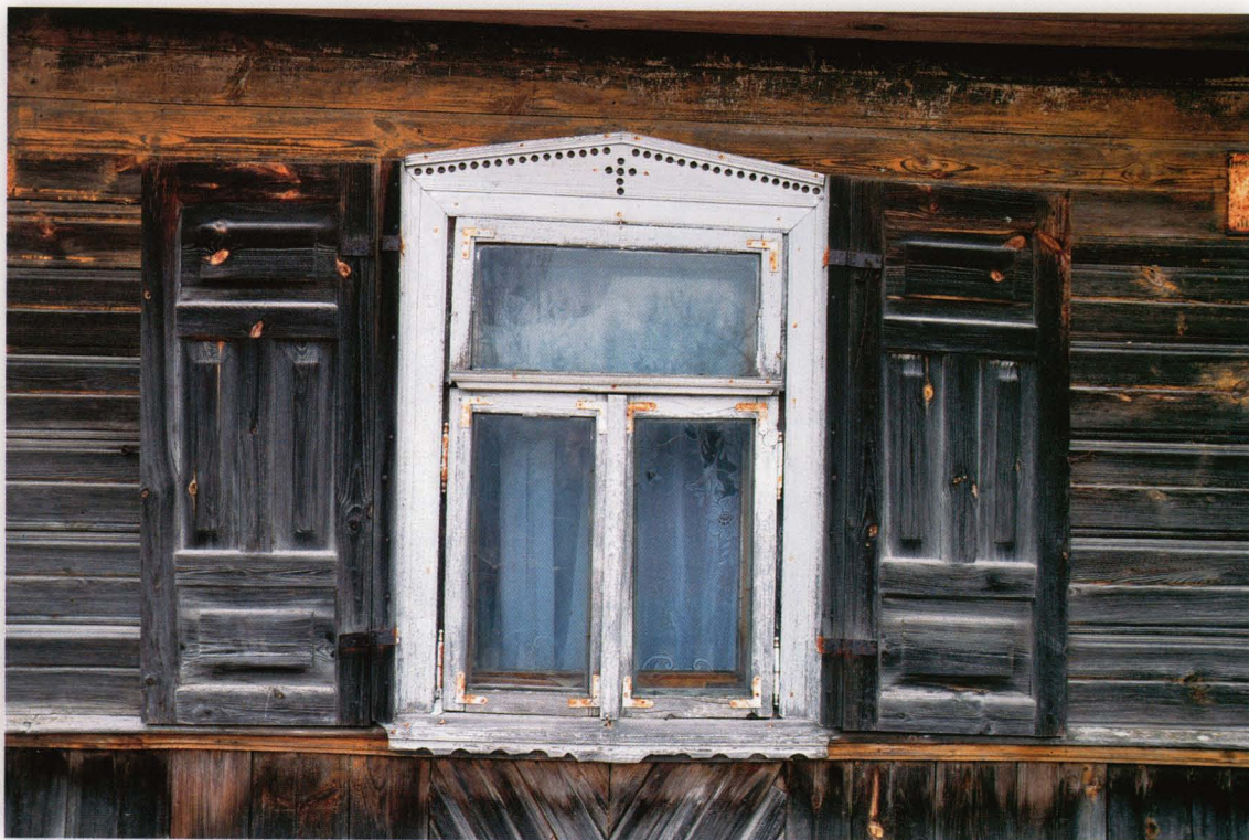
Nowy Dwór, ul. Kuźnicka 2. Okno tzw. polskie – ościeżnicowe, dwuskrzydłowe, z prostokątną, uchylną górną częścią zwaną oberluftem. Okiennice ramowo-płycinowe.
