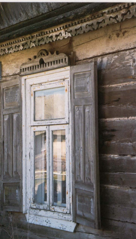
Jałówka. Okno ościeżnicowe z ramowo-płycinowymi okiennicami, zdobione nadokiennikiem typu nalicznik. Powyżej okna widoczna profilowana wycięta listwa podokapowa.
