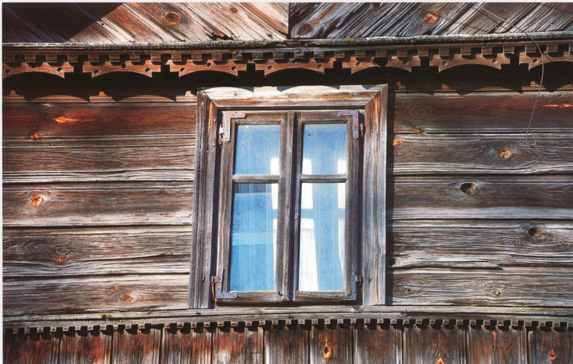
Stare Dolistowo 44. Okienko w szczycie domu o konstrukcji ościeżnicowej, dwuskrzydłowe, czterokwaterowe. Do końca XIX wieku w celu oświetlenia poddaszy wycinano tylko niewielkie otwory oświetleniowe, zazwyczaj o okrągłym kształcie.
