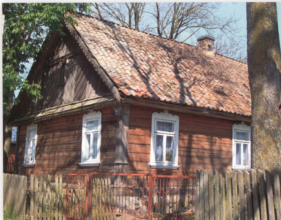
Stare Dolistowo 38. Dom z lat dwudziestych XX wieku, posadowiony na murowanym kamienno-ceglanym fundamencie, ze ścianami o konstrukcji sumikowo-łatkowej. Okna ościeżnicowe, z ramowo-płycinową konstrukcją, zdobione nadokiennikami. Naroża szalowane deskami w układzie pionowym, ze skromnym ornamentem geometrycznym.
