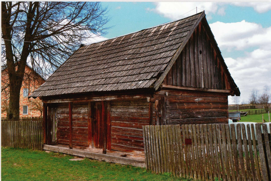
Chmielówka. Spichlerz szerokofrontowy wybudowany na przełomie XIX i XX wieku, z podcieniem na czterech słupach. Ściany o konstrukcji zrębowej, dwuspadowy dach kryty dachówką cementową. Jest to forma spichlerza dość często spotykana na terenie gminy Suchowola.
