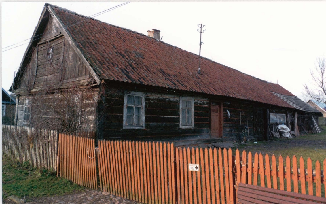
Cieśnisk Wielki. Budynek z końca XIX wieku, łączący pod jednym dachem część mieszkalną i gospodarczą. Budynek te niejednokrotnie przekraczały 40 m długości. Ich usytuowanie szczytem w kierunku drogi wiązało się ściśle z rozplanowaniem działek siedliskowych we wsiach typu szeregowka.
