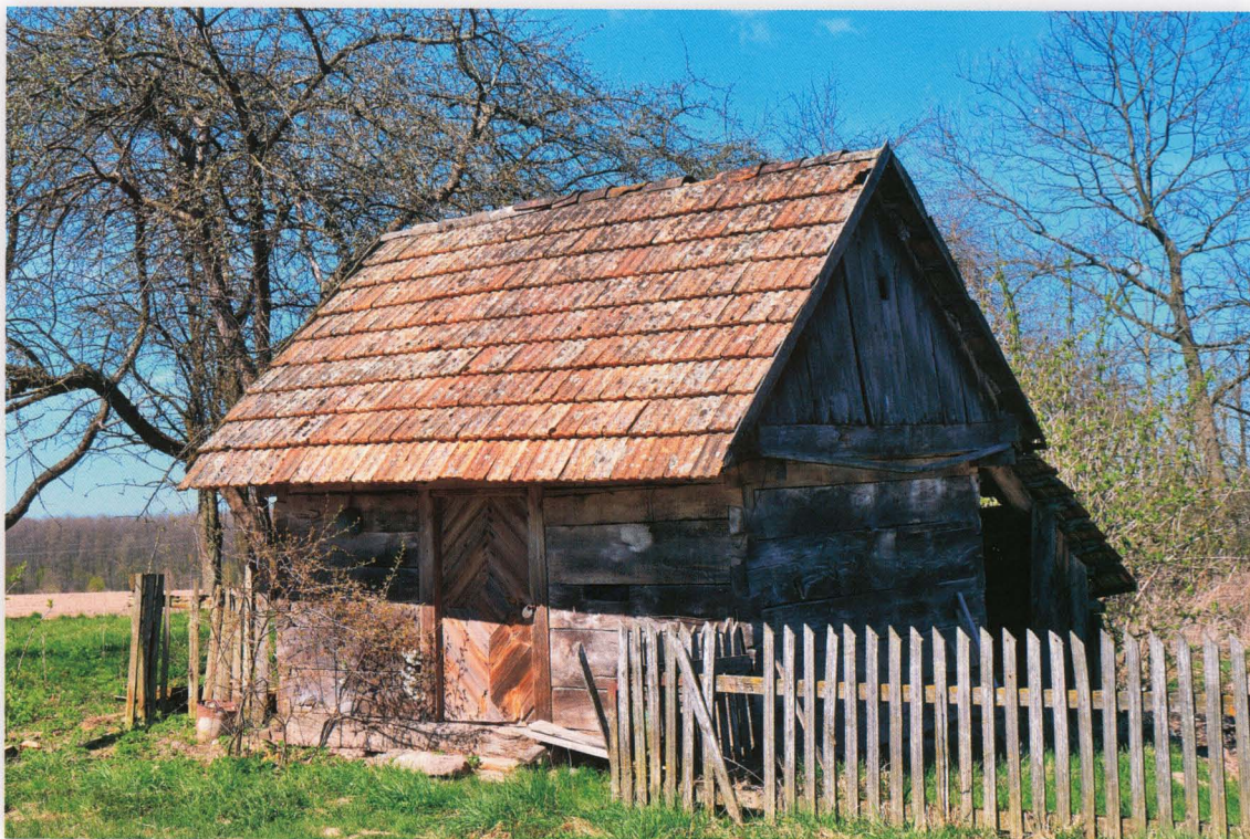
Jałówka. Spichlerz z końca XIX wieku o konstrukcji zrębowej, posadowiony na fundamencie z kamieni, kryty dwuspadowym dachem z ceramiczną dachówką. Drzwi ozdobione szalunkiem z motywem rombu. Obok drzwi niewielki otwór okienny.
