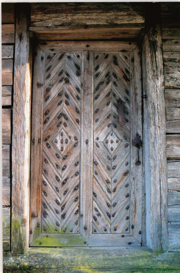
Długie. Drzwi zewnętrzne zdobione szalunkiem w formie dwóch symetrycznych rombów. Widoczne główki gwoździ kowalskich, którymi został przybity szalunek.
