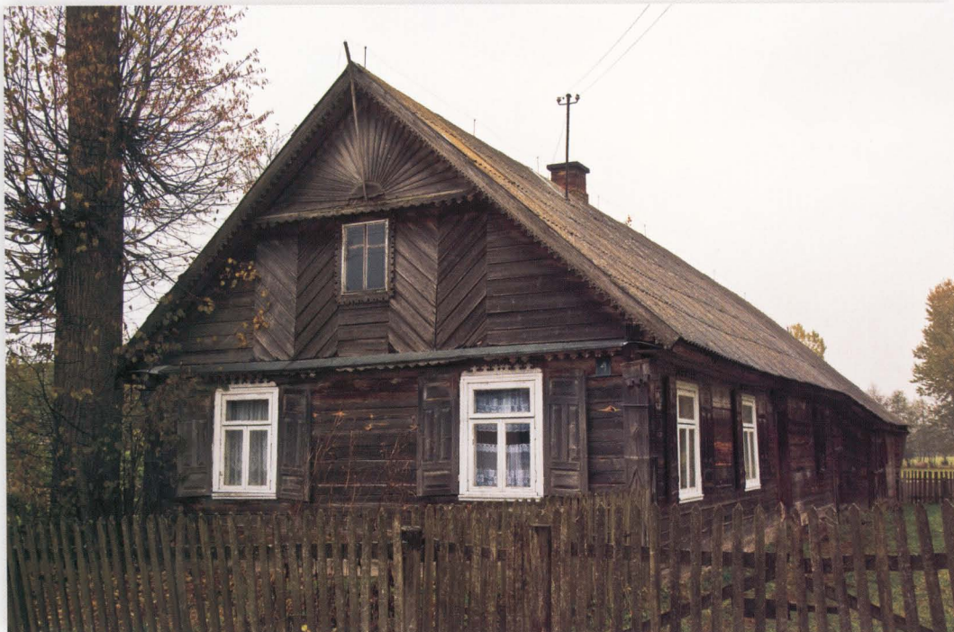
Hamulka. Typowy w regionie budynek mieszkalny, łączący pod jednym dachem część mieszkalną i gospodarczą. Szalunek szczytu z motywem wschodzącego słońca.
