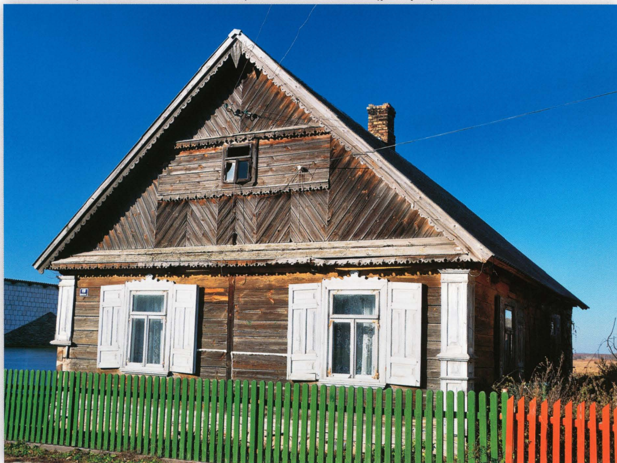
Stare Dolistowo 19. Dom z początku XX wieku o konstrukcji ścian wieńcowej i sumikowo-łatkowej, posadowiony na fundamencie z kamieni polnych łączonych zaprawą cementową. Okna z nadokiennikami i ramowo-płycinowymi okiennicami. Uwagę zwraca szczyt z ozdobnym szalunkiem z różnokierunkowo ułożonych desek, wiatrownicami i listwą podokapową.
