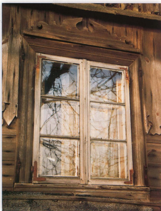
Łabętnik. Sześciokwaterowe okno zdobione nadokiennikiem z motywem geometrycznym.
