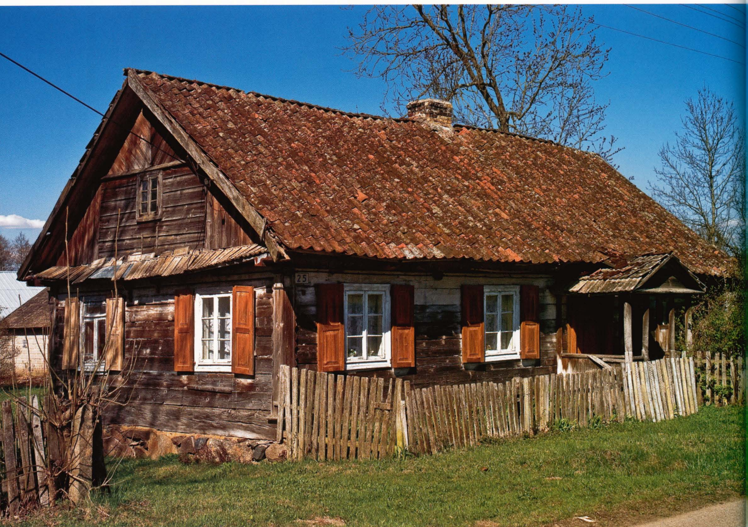
Czerwonka 25. Dom z końca XIX wieku, posadowiony na fundamencie z kamieni łączonych cementową zaprawą. Ściany o konstrukcji zrębowej, naroża z przybitymi pionowo deskami o wyciętych profilowanie krawędziach. Zachowana zdobiona listwa podokapowa. Ganek z sześcioma pionowymi słupkami, z dwuspadowym daszkiem. Dach dwuspadowy, kryty ceramiczną dachówką – „esówką”.
