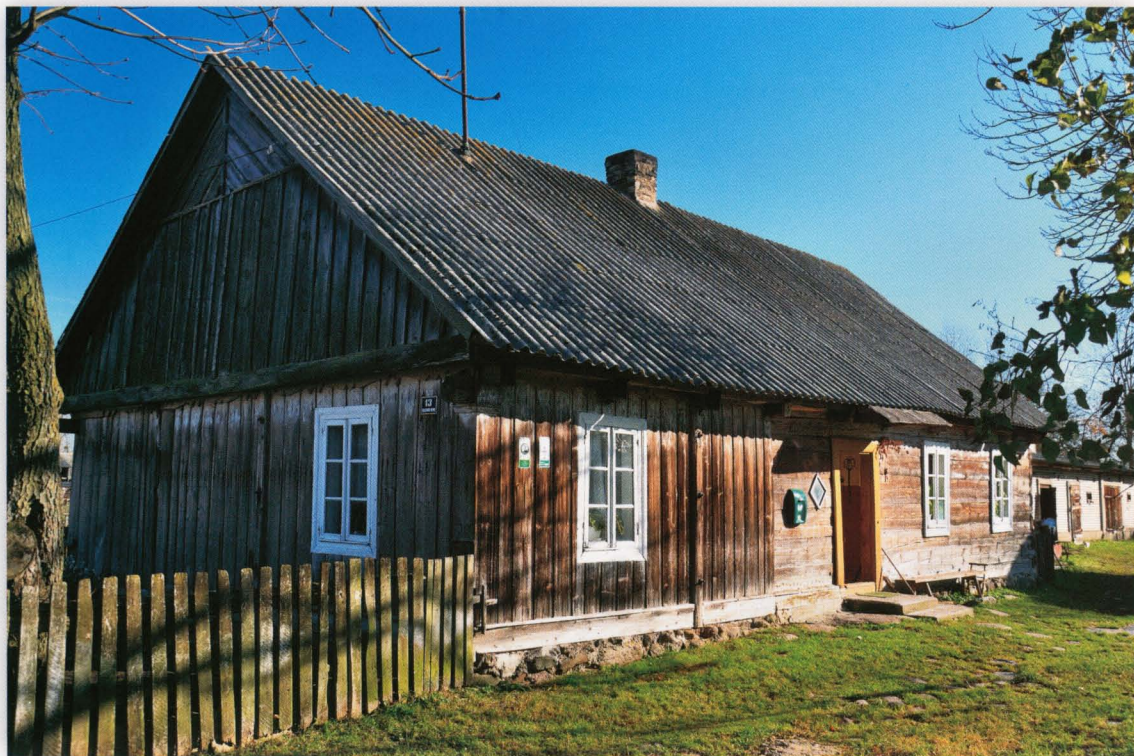
Nowe Dolistowo 13. Dom z końca XIX wieku, posadowiony na fundamencie z kamieni polnych łączonych zaprawą cementową. Ściany o konstrukcji zrębowej i sumikowo-łatkowej. Budynek częściowo szalowany deskami w układzie pionowym. Pod okapem profilowane wycięta deska z powtarzającym się motywem zdobniczym.
