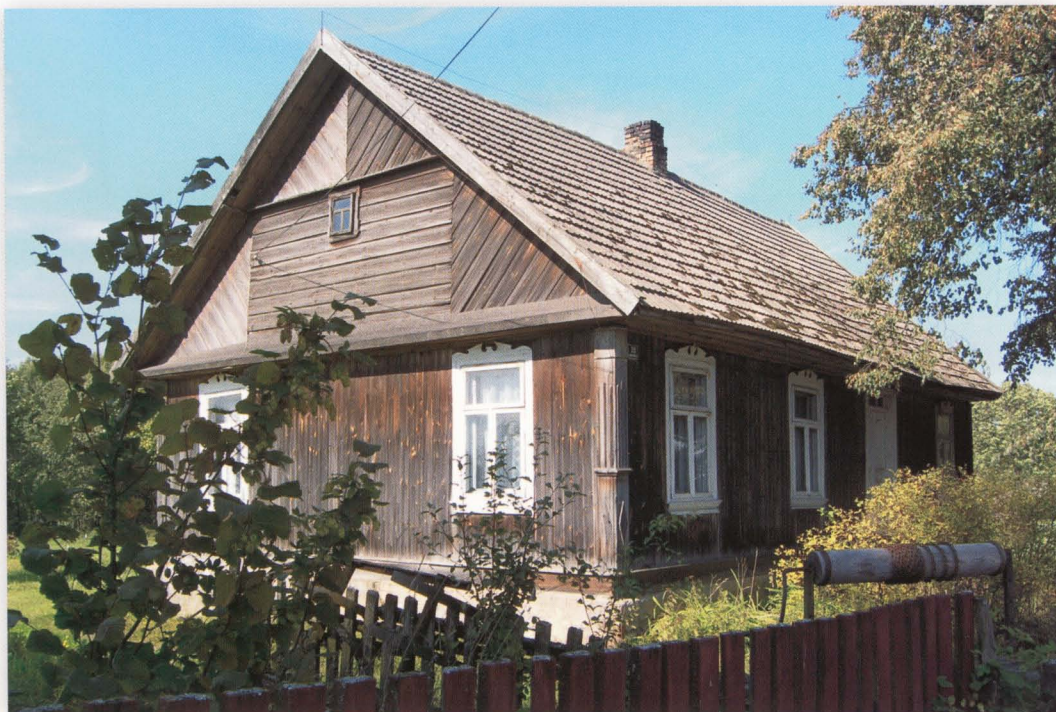
Bobrówka 28. Dom wybudowany w 1921 roku, posadowiony na fundamencie murowanym, kamienno-ceglanym. Dach obecnie kryty eternitem, pierwotnie gontem. Wnętrze budynku złożone z trzech izb, kuchni i sieni.
