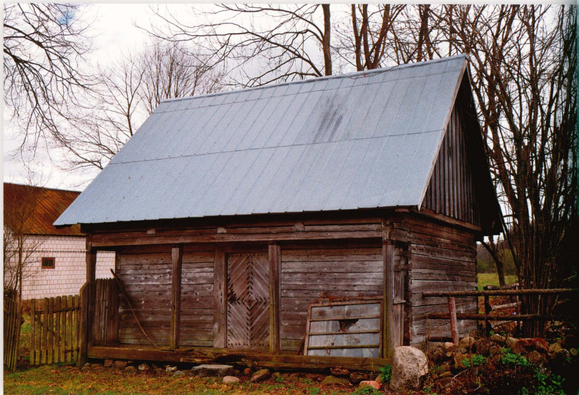
Chmielówka 10. Spichlerz szerokofrontowy wzniesiony na początku XX wieku, posadowiony na fundamencie z kamieni polnych. Konstrukcja ścian – zrębowa.
