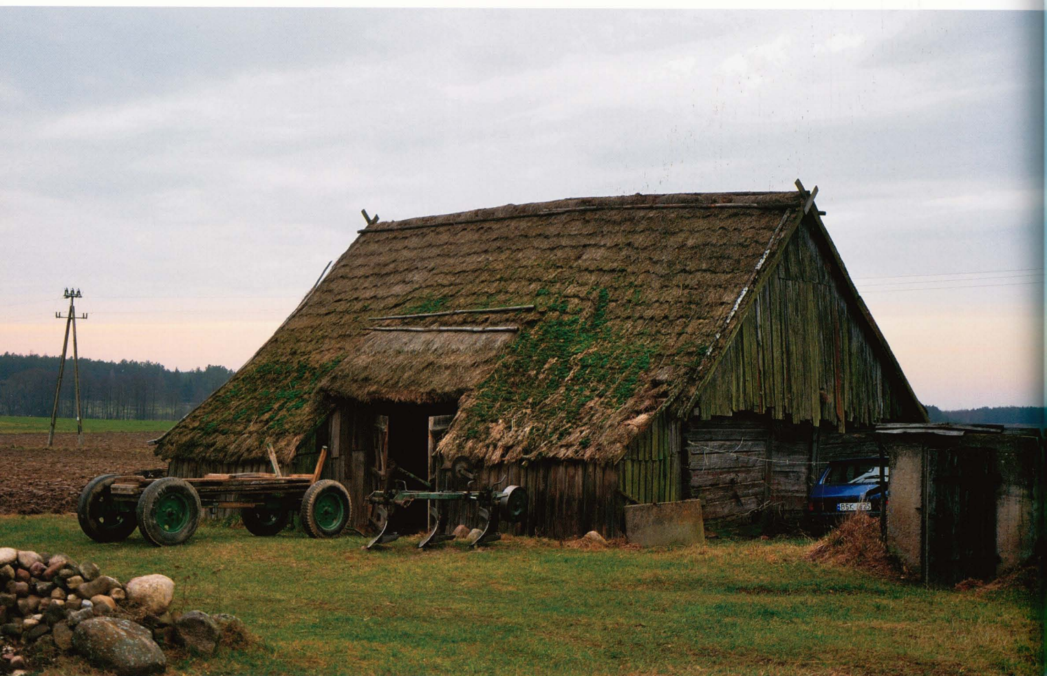
Chilmony. Stodoła z wysuniętym po obu stronach wrót dachem, tworzącym zadaszenie dla dwóch pomieszczeń spełniających zazwyczaj funkcję magazynową.
