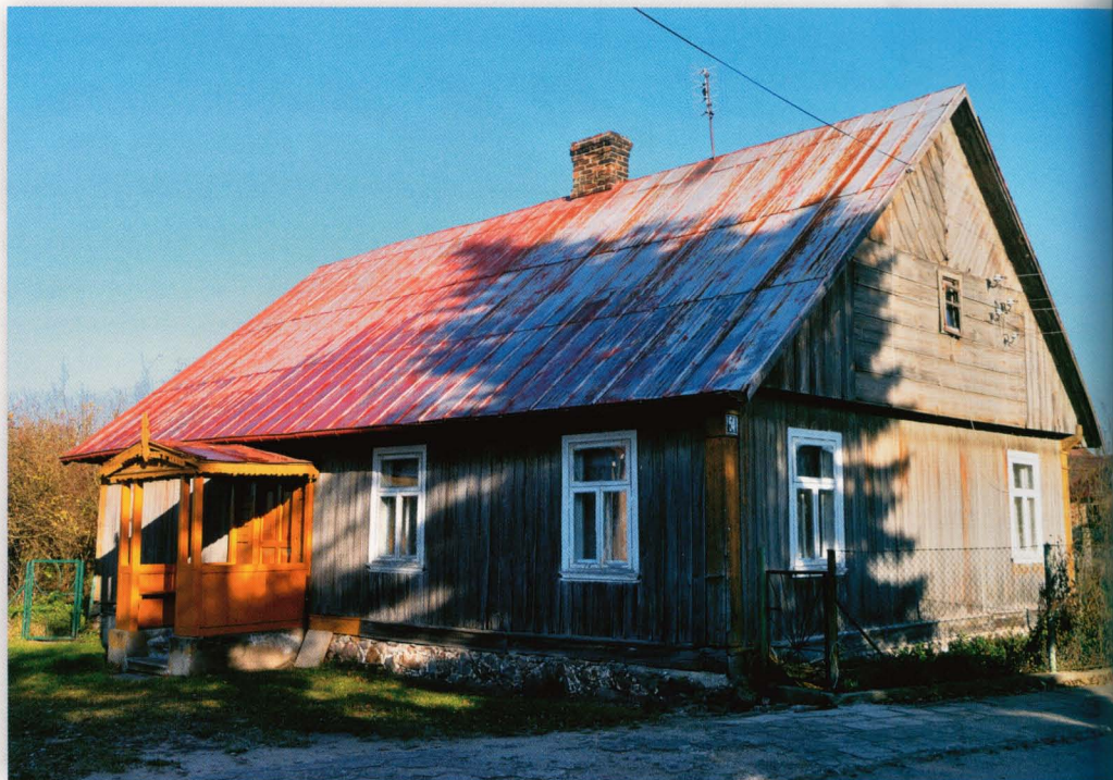
Goniądz. Dom przy ulicy Kościuszki 54. Budynek z lat dwudziestych XX wieku, posadowiony na fundamencie z kamieni polnych łączonych cementową zaprawą. Ściany zrębowe, szalowane deskami w układzie pionowym. Ganek z dwuspadowym daszkiem wspartym na sześciu słupkach. Dach dwuspadowy, kryty blachą.
