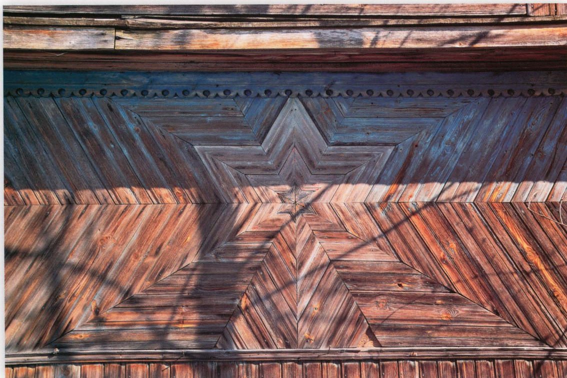
Stok 5. Zdobienie ściany szczytowej budynku mieszkalnego w formie ułożonych w kształcie sześcioramiennych gwiazd desek.
