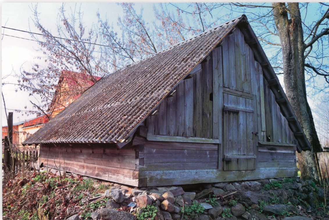
Stok 5. Piwnica nakryta dwuspadowym daszkiem, krytym eternitem.
