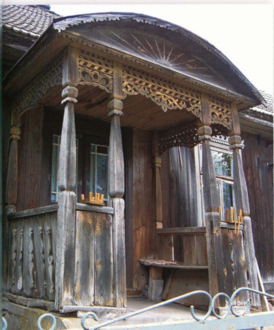
Bobrówka. Ganek w jednym z domów z okresu międzywojennego. Na jego bogate zdobienie składają się: dolny rząd desek z przybitymi listewkami o ozdobnie wyciętych krawędziach, sześć pionowych słupków o profilowanym kształcie, ażurowy pas zdobniczy z motywami roślinno-geometrycznymi przy górnym zakończeniu słupków oraz łukowaty daszek z frontonem z motywem wschodzącego słońca.
