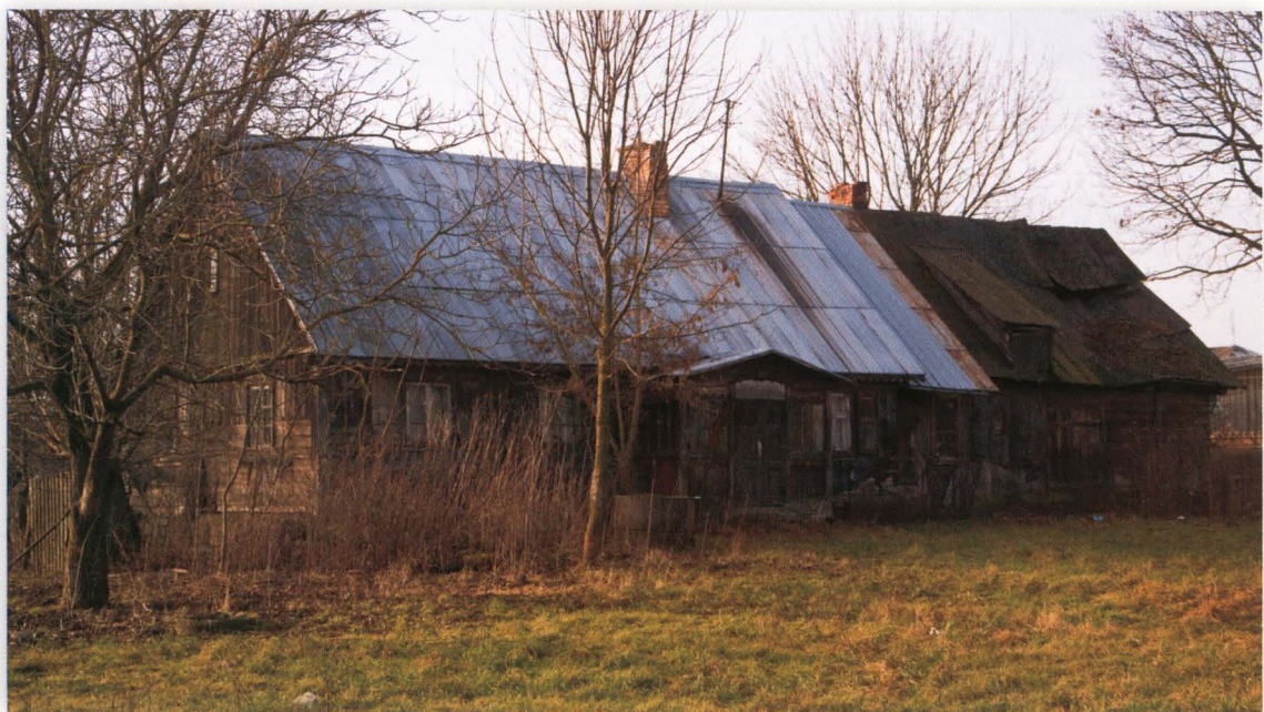
Łabętnik. Budynek z początku XX wieku łączący pod wspólnym dachem część mieszkalną i gospodarczą, obecnie niezamieszkały.
