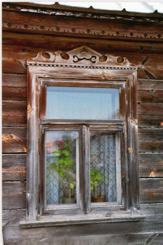
Ciemne 7. Okno domu z lat dwudziestych XX wieku zdobione nadokiennikiem. Powyżej widoczna listwa podokapowa.
