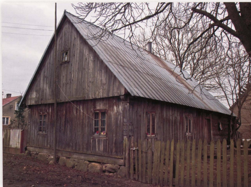
Grabowo. Budynek mieszkalny połączony z gospodarczym, z prostym pionowym szalunkiem ścian i szczytu. Obiekt wybudowany na przełomie XIX i XX wieku.
