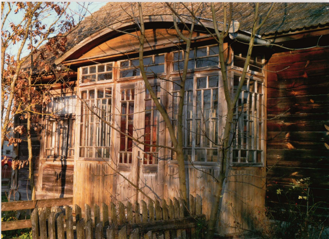
Trofimówka. Weranda domu z okresu międzywojennego. Weranda o typowej konstrukcji, złożonej z dolnego pasa szalunku, przeszklonych ścianek oraz łukowego daszku. W ścianie frontowej – dwuskrzydłowe drzwi.
