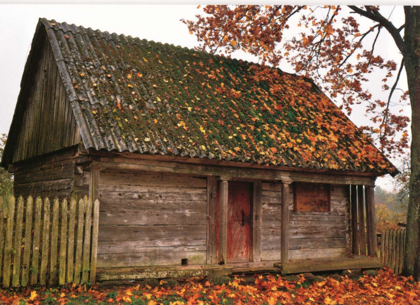
Małowista. Spichlerz z początku XX wieku, szeroko-frontowy, o zrębowej konstrukcji ścian, z podcieniem wspartym na czterech słupkach, posadowiony na fundamencie z polnych kamieni. Dach dwuspadowy, kryty eternitem. Drzwi szalowane, z motywem rombu.
