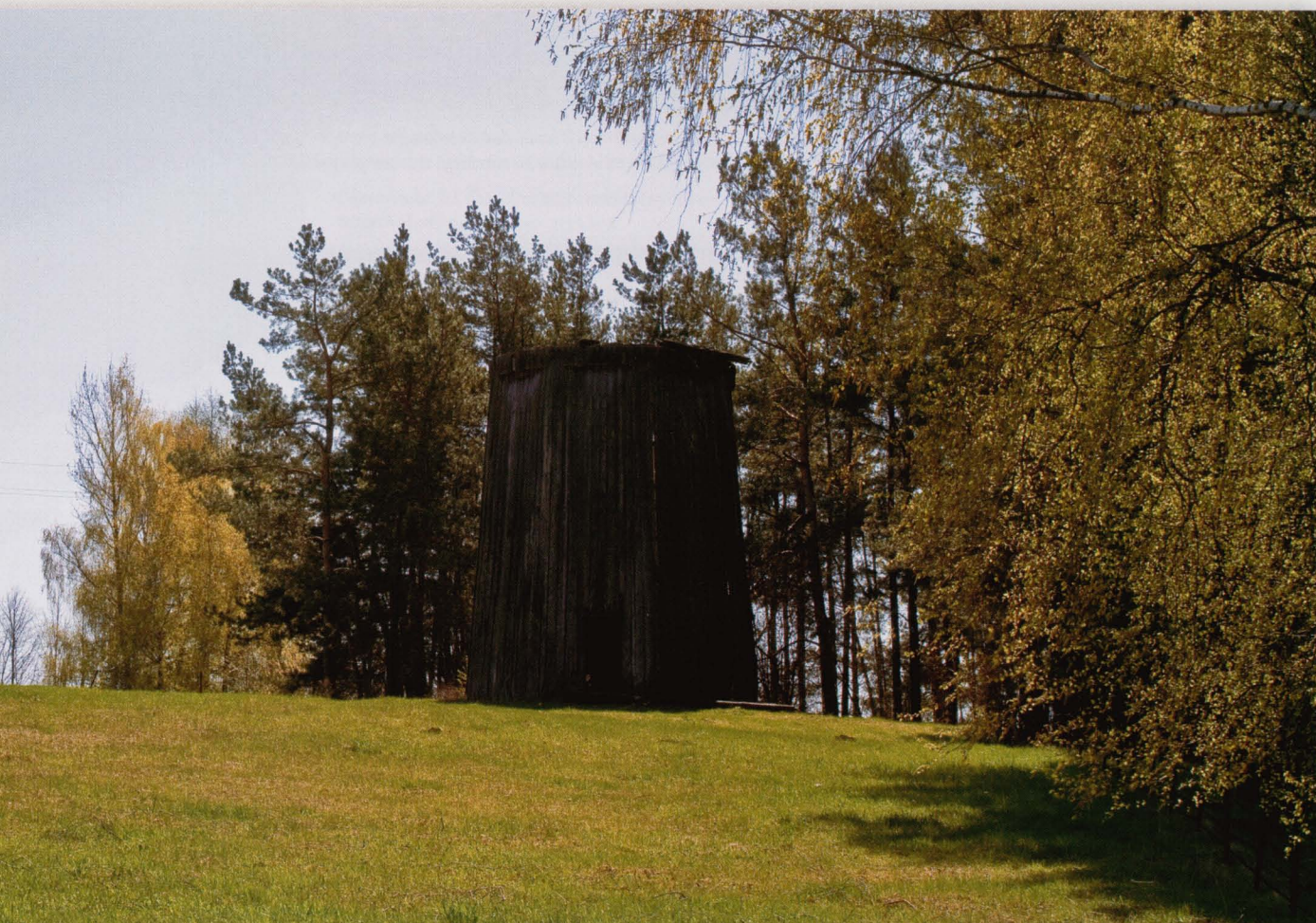
Grodzisk. Wiatrak holenderski z 1923 roku. Z całej konstrukcji budynku pozostał już tylko korpus. Wiatrak pracował do roku 1948, od tego czasu nieużytkowany ulega stopniowemu niszczeniu, mimo iż od 1966 roku jest wpisany do rejestru zabytków.
