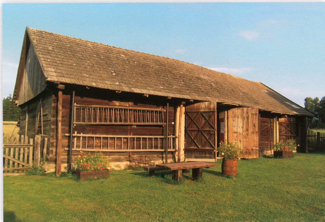
Kamienica. Stodoła z lat czterdziestych XX wieku, dwuklepiskowa, z dwuskrzydłowymi wrotami. Dach dwuspadowy, kryty dachówką cementową.
