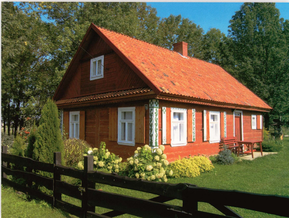
Białousy. Dom z lat dwudziestych XX wieku. Jest to przykład właściwej modernizacji budynku, w wyniku której nie utracił on charakterystycznych cech stylu regionalnego, między innymi dzięki zachowanym detalom zdobniczym.
