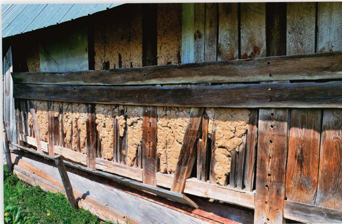
Dubasiewskie Kolonie 8. Fragment konstrukcji ściany stodoły z widocznymi detalami, a więc słupami ze skośnymi ryglami i wypełniającymi przestrzeń listwami oblepionymi gliną.
