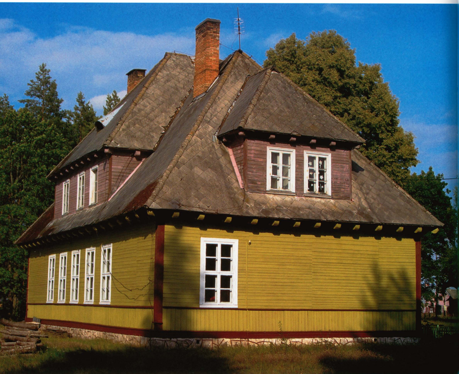
Krasne 3. Szkoła wybudowana w 1936 roku. W każdej połaci dachu znajduje się facjata, nakryta osobnym trójspadowym dachem, oświetlona trzema lub dwoma oknami.
