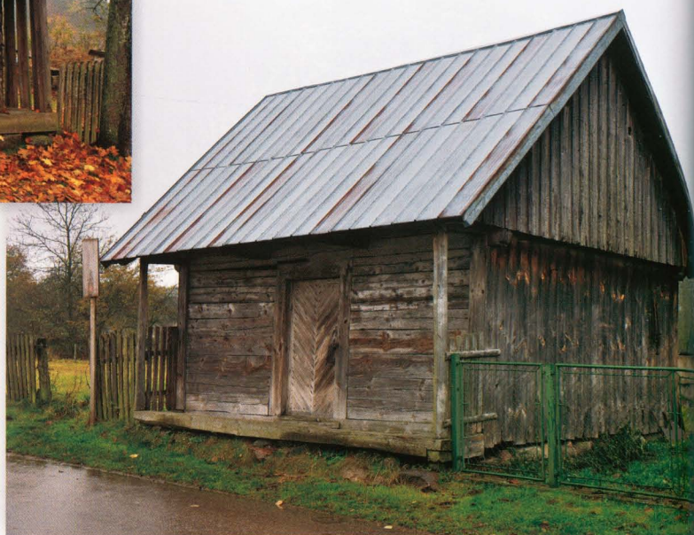
Małowista. Spichlerz z przełomu XIX i XX wieku, szeroko-frontowy, z podcieniem wspartym na dwóch słupkach. Drzwi ozdobnie szalowane. Dach dwuspadowy, kryty blachą.
