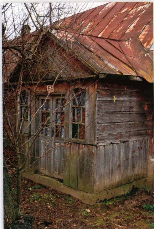
Nowy Dwór, ul. Grodzieńska 64. Ganek z dwuskrzydłowymi drzwiami. Z obu stron drzwi i w samych drzwiach kolorowe szybki.
