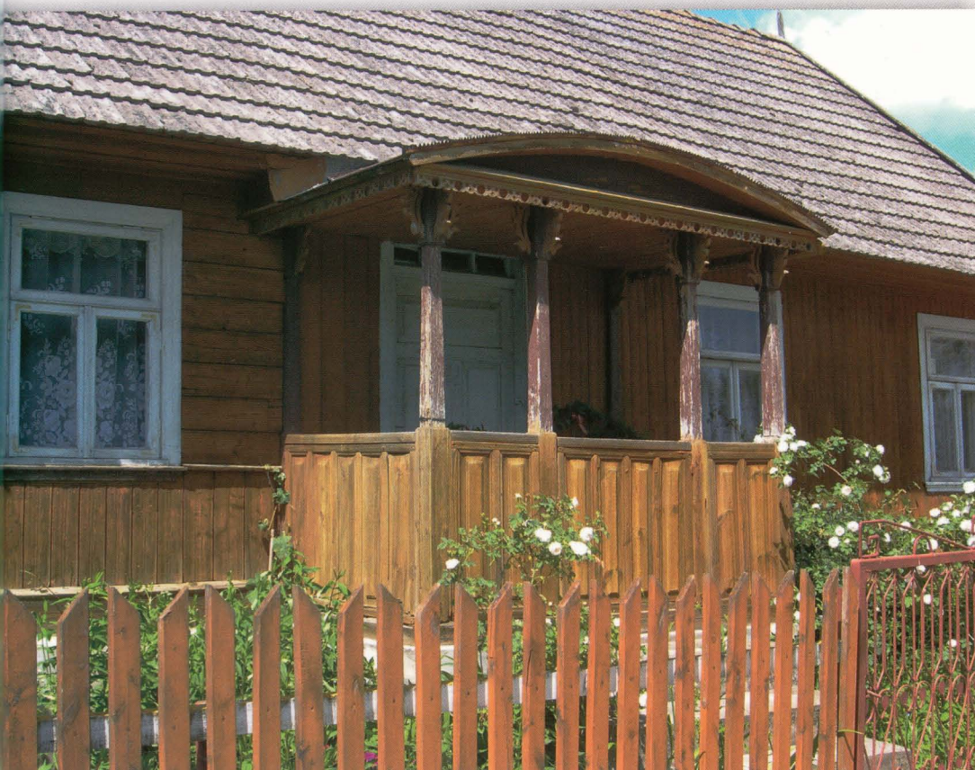
Zabrodzie. Ganek z sześcioma słupkami, zdobionymi przy górnych zakończeniach detalami tworzącymi „kapitele”.
