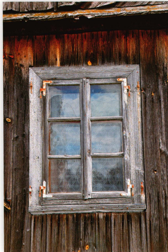
Chmielniki 8. Okno domu z 1910 roku, ościeżnicowe, dwuskrzydłowe, sześciokwaterowe.
