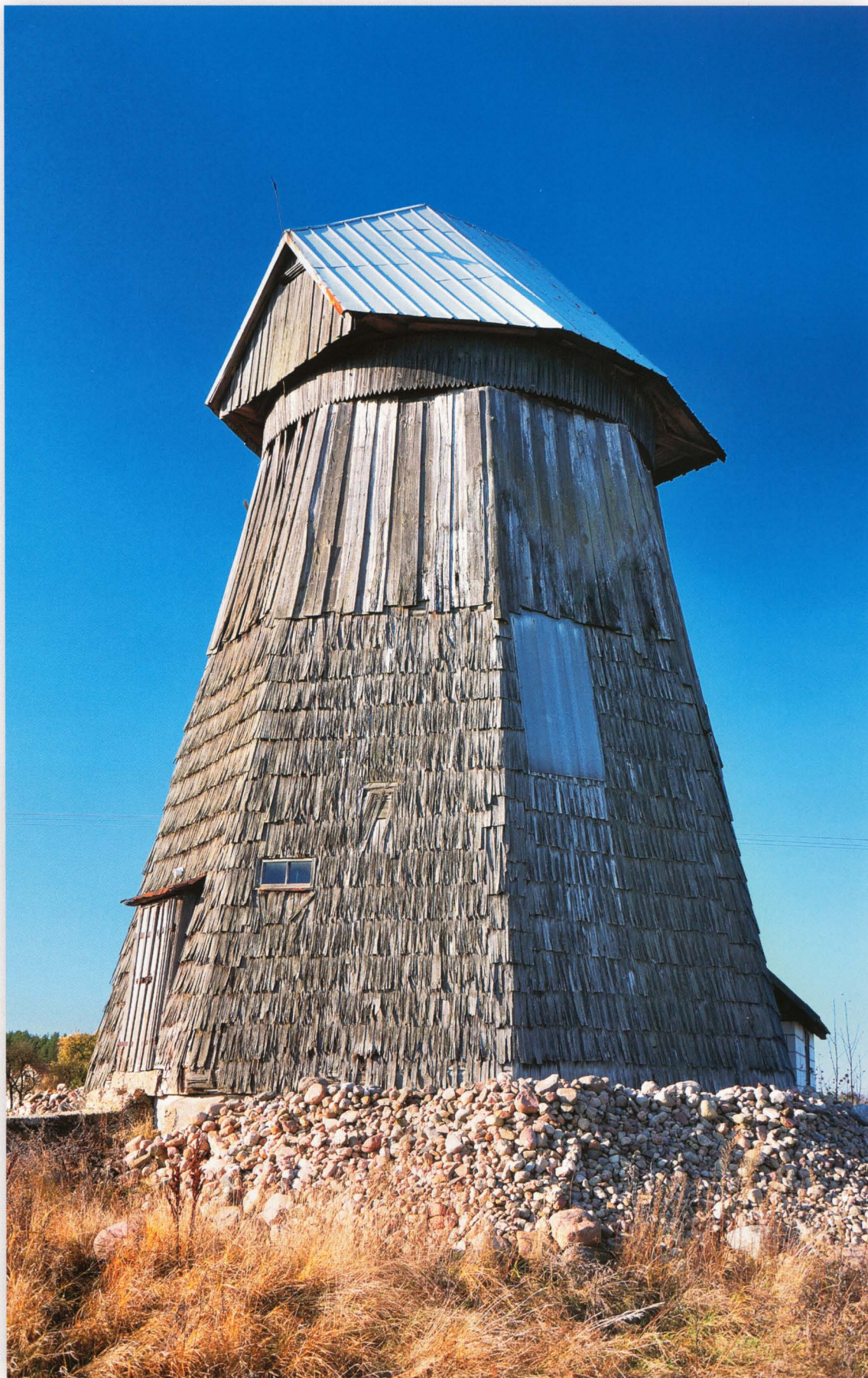
Dzięciółowo. Wiatrak typu holenderskiego z początku XX wieku. Ściany o konstrukcji słupowo-ramowej, w części dolnej obite wiórem, powyżej szalowane deskami. Obiekt był użytkowany do lat pięćdziesiątych ubiegłego wieku.
