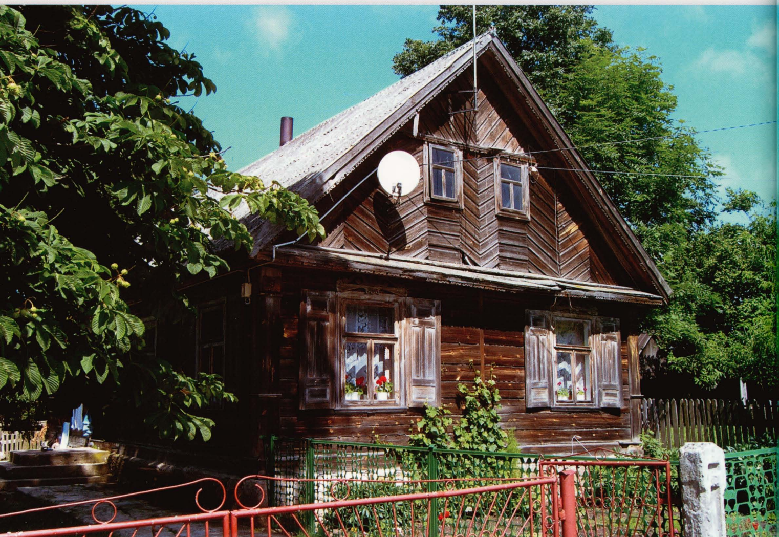
Grodzisk 9. Dom z 1925 roku o konstrukcji ścian sumikowo-łatkowej, posadowiony na fundamencie z kamieni łączonych cementową zaprawą. Okna z okiennicami, zdobione nadokiennikami.
