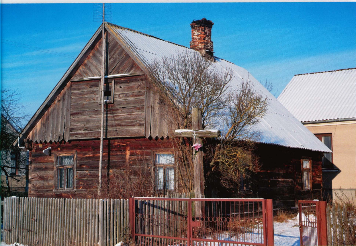
Trzciannie. Budynek mieszkalny z okresu międzywojennego, z dwuspadowym dachem krytym eternitem. Konstrukcja ścian sumikowo-lątkowa.
