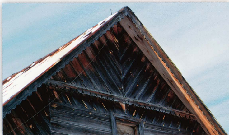
Wilamówka. Zwieńczenie szczytu z dwoma wiatrownicami i zdobioną listwą jętkową. Deski szalunku przybite w układzie jodełkowym.
