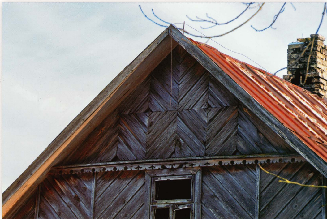
Kulesze. Zwieńczenie szczytu z ozdobnym szalunkiem w kształcie dwóch rombów, poniżej profilowanie wycięta listwa jętkowa.
