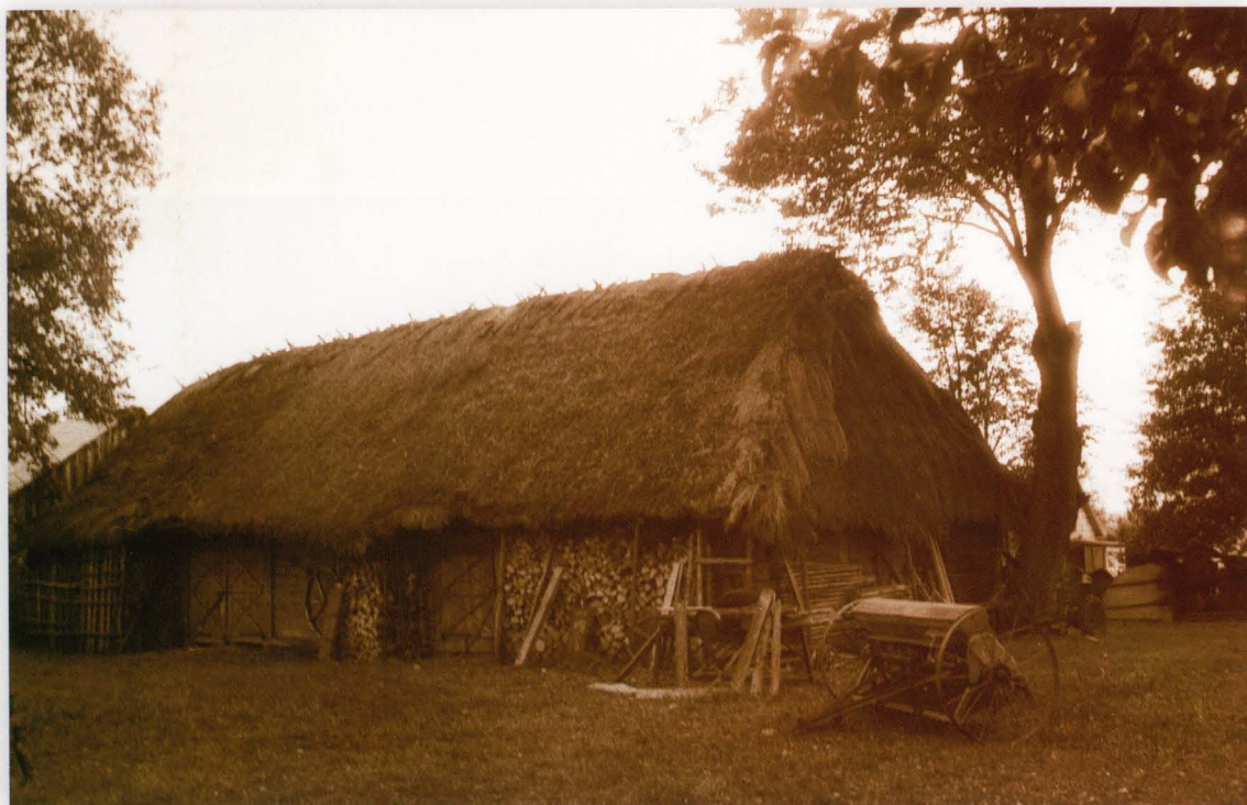
Nowy Dwór. Stodoła o konstrukcji ścian sumikowo-lątkowej, z charakterystycznym czterospadowym dachem krytym strzechą. Fotografia z pierwszej połowy lat dziewięćdziesiątych XX wieku.
