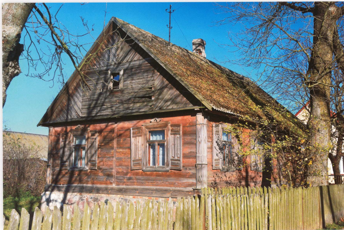
Stare Dolistowo 38. Dom z lat dwudziestych XX wieku posadowiony na murowanym kamienno-ceglanym fundamencie, ze ścianami o konstrukcji sumikowo-lątkowej. Okna ościeżnicowe, z okiennicami o ramowo-płycinowej konstrukcji, zdobione nadokiennikami. Naroża szalowane pionowymi deskami ze skromnym ornamentem geometrycznym.
