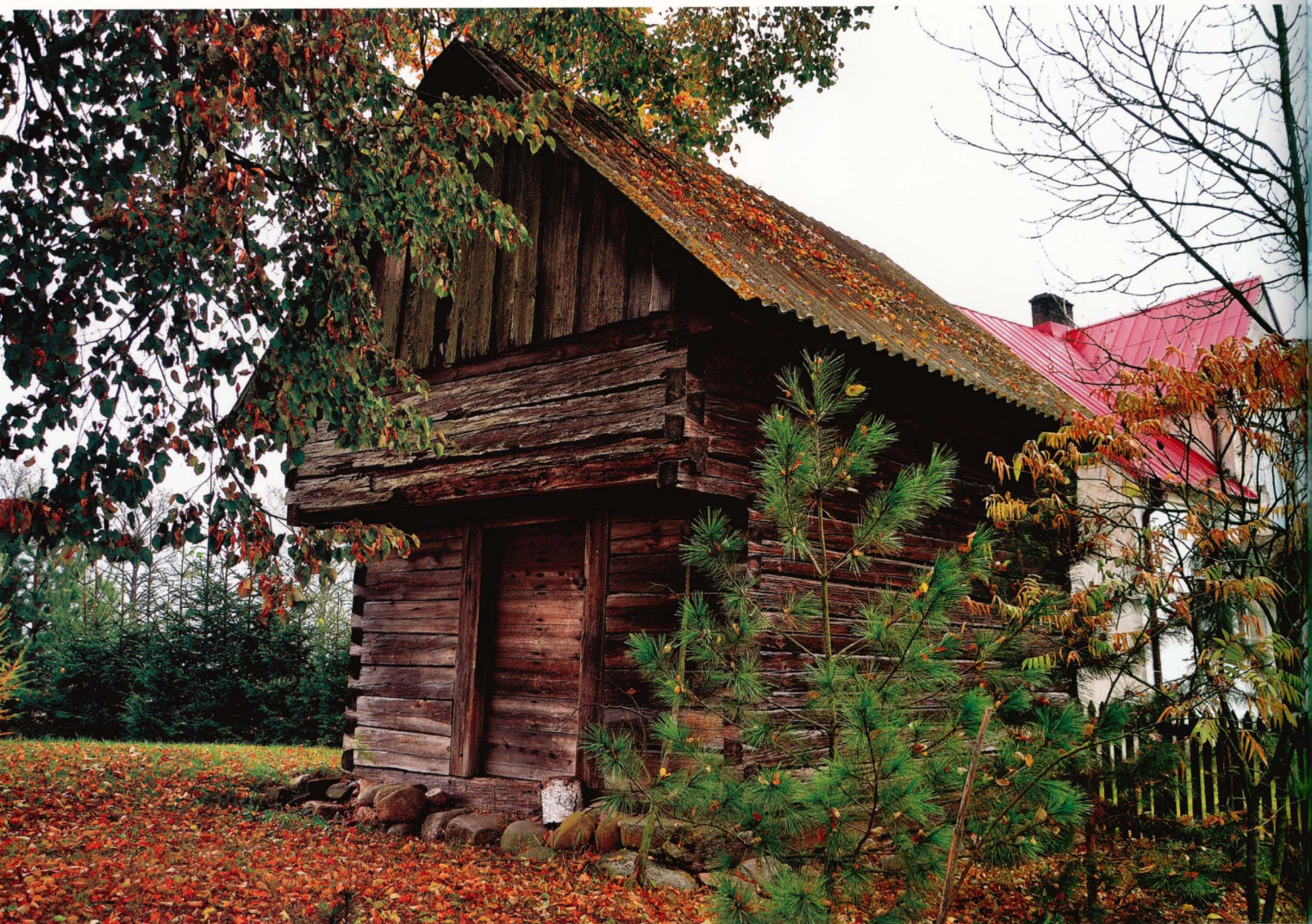
Jaminy. Spichlerz z przełomu XIX i XX wieku o zrębowej konstrukcji ścian, posadowiony na fundamencie z kamieni. Jednowniętrzny, półtorakondygnacyjny, nakryty dwuspadowym dachem.
