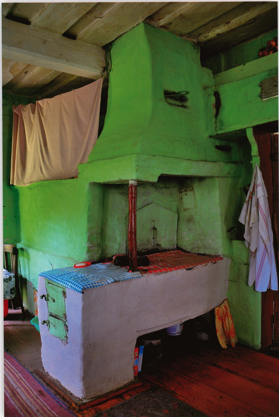
Lipszczany 12. Trzon kuchenny tworzy gliniany piec chlebowy z kapturem nad paleniskiem. Widoczny pułap o bardzo rzadko spotykanym już dziś sposobie ułożenia desek na tzw. nakładkę.
