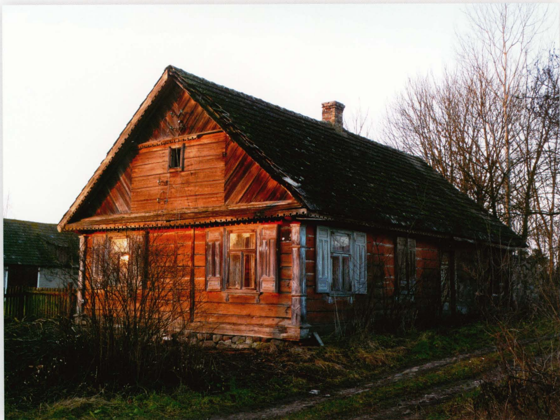
Olszanka. Dom z lat dwudziestych XX wieku o konstrukcji ścian sumikowo-łatkowej, podwalina na fundamencie z kamieni polnych. Dach dwuspadowy, kryty dachówką cementową. W budynku zachowane detale zdobnicze: naroża, listwa podokapowa, wiatrownica, pod- i nadokienniki.
