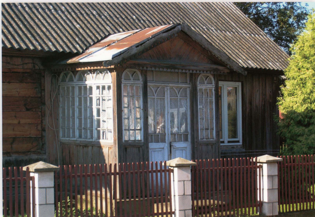
Korycin. Weranda o ciekawym układzie przeszklenia, z łukowatymi górnymi krawędziami. Wzdłuż krawędzi daszku listwa podokapowa, od frontu wiatrownice.
