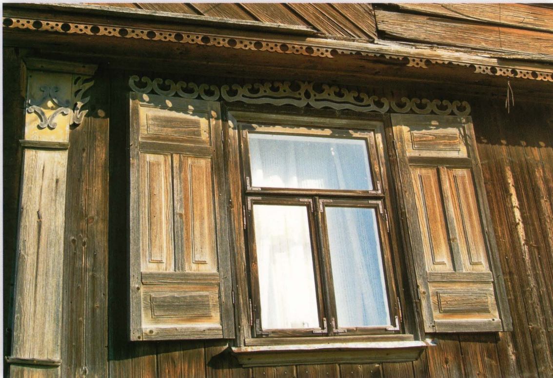
Aulakowszczyzna 5. Okno ościeżnicowe z ramowo-płycinowymi okiennicami, zdobione nadokiennikiem.
