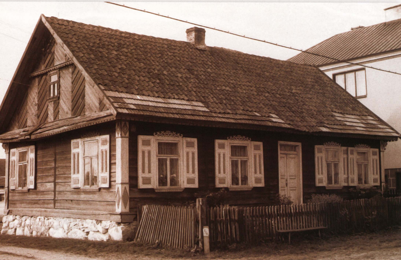
Krukowszczyzna 6. Nieistniejący już dom z bogatym zdobnictwem architektonicznym – nad- i podokiennikami, narożami i listwą podokapową.
