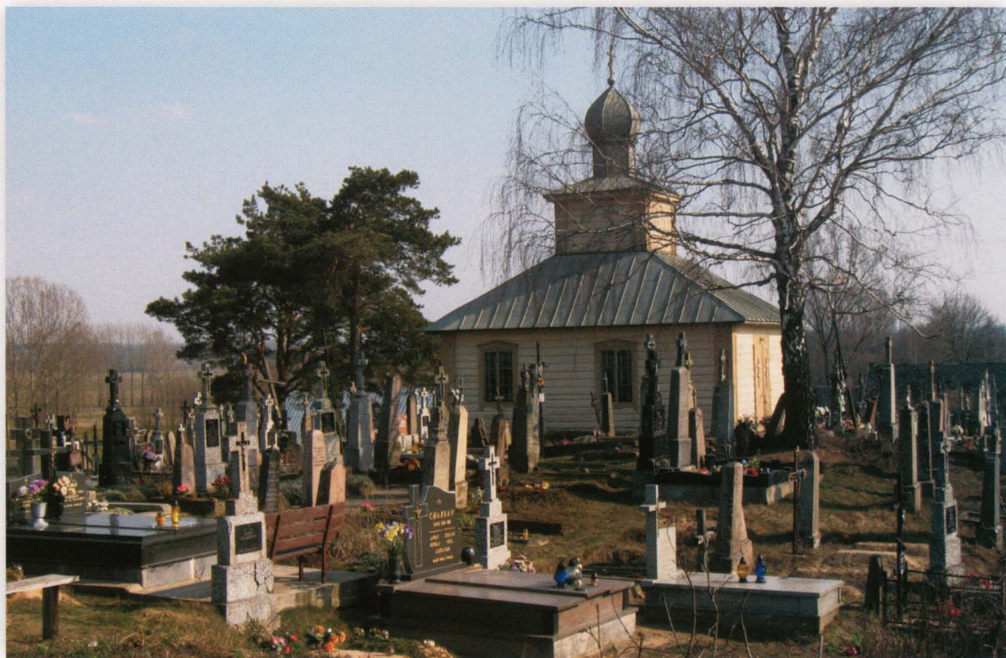
Jacznó. Cerkiew cmentarna p.w. Świętych Niewiast Niosących Wonności z trzeciej ćwierci XIX wieku, wzniesiona na planie prostokąta, o konstrukcji zrębowej, oszalowana.
