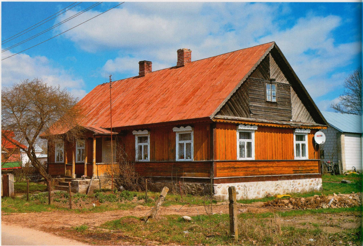
Domuraty 12. Dom z 1925 roku, posadowiony na wysokiej podmurówce z kamieni polnych łączonych cementową zaprawą. Nietypowe deskowanie – do dolnej krawędzi okien poziome, powyżej pionowe. Wysunięte poza płaszczyznę okien nadokienniki typu nalicznik.
