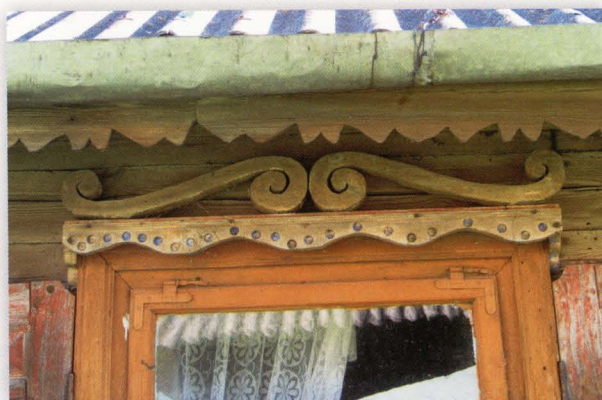
Zajki. Nadokiennik o prostej, symetrycznej formie, z zachowanymi śladami pierwotnego malowania. Widoczna listwa podokapowa.
