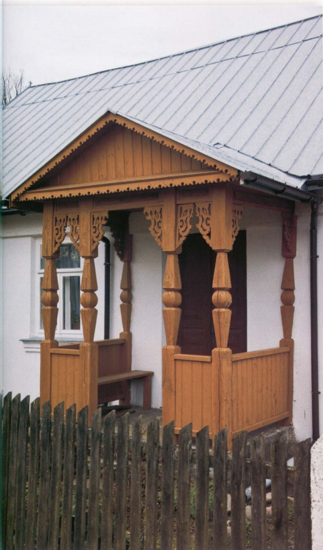
Jaczo. Drewniany ganek z sześcioma profilowanymi słupkami podtrzymującymi dwuspadowy daszek kryty blachą. Przy górnych zakończeniach słupków ażurowo wycięte detale zdobnicze. Całość malowana farbą olejną.
