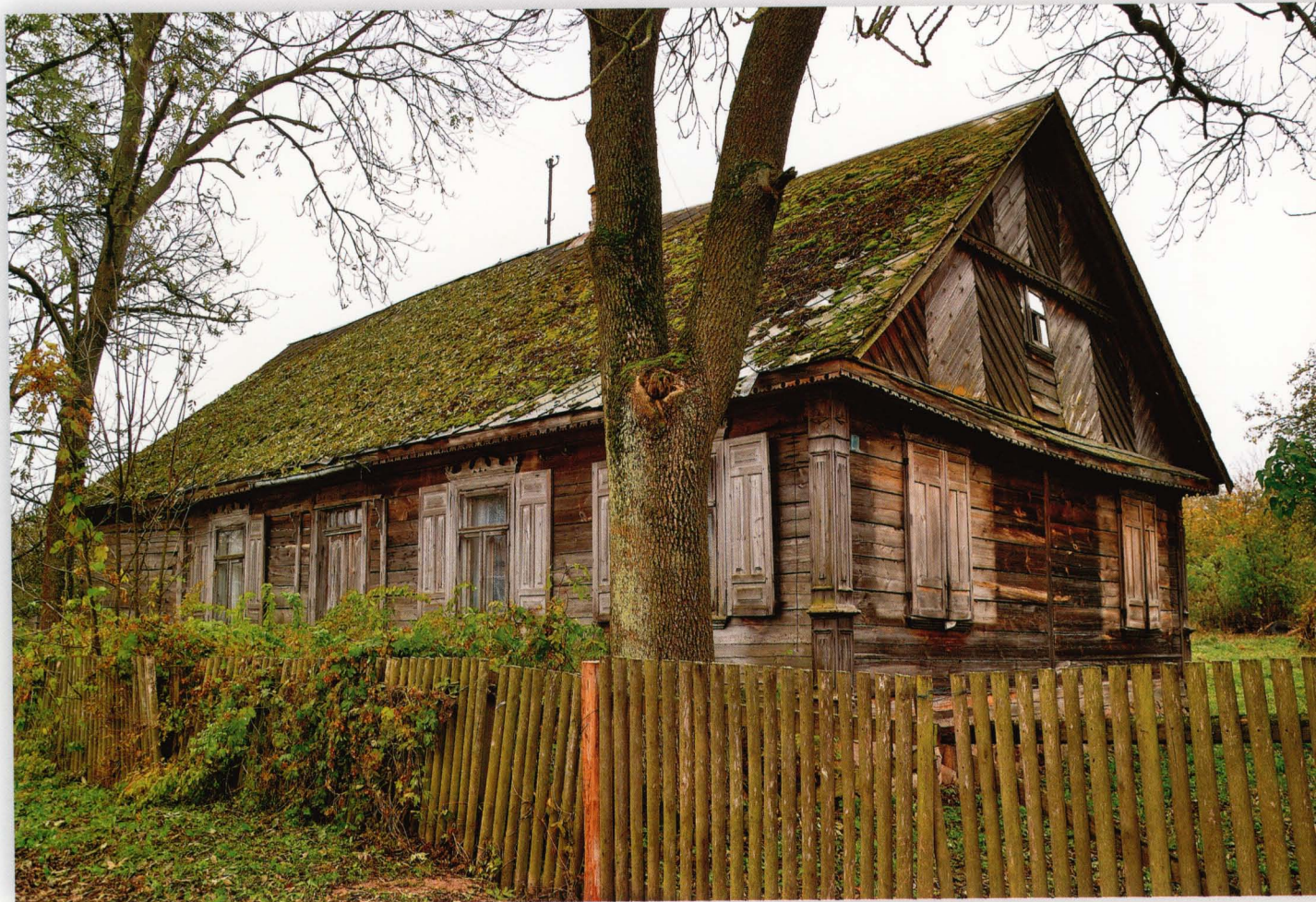
Horodnianka 11. Dom z okresu międzywojennego o konstrukcji ścian sumikowo-łatkowej, posadowiony na kamiennym fundamencie. Okna z okiennicami, zdobione nadokiennikami. Pozostałe detale zdobnicze to listwa podokapowa, naroża oraz taflowanie szczytu.
