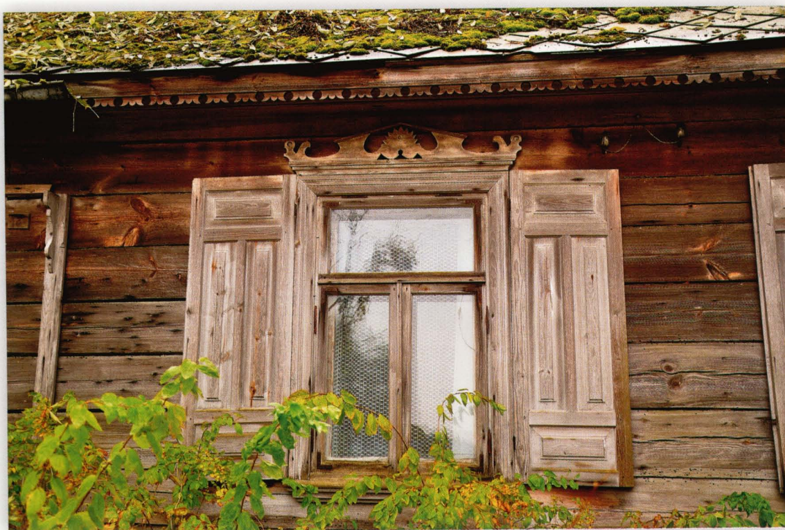
Horodnianka 11. Okno ościeżnicowe z ramowo-płycinowymi okiennicami, zdobione nadokiennikiem.
