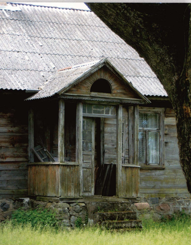
Mroczi. Weranda z dwuspadowym daszkiem, pod którym znajduje się trójkątny fronton zdobiony szalunkiem w formie wschodzącego słońca. Drzwi dwuskrzydłowe, płycinowe. Niezachowane przeszklone boczne ścianki.
