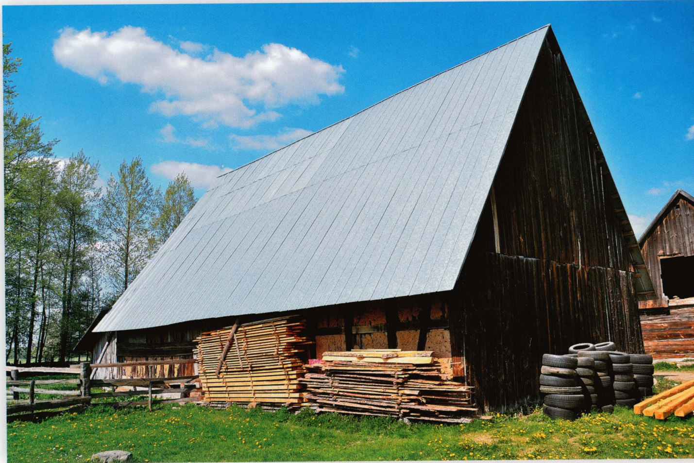
Dubasiewskie Kolonie 8. Stodoła z przełomu XVIII i XIX wieku o szachulcowej konstrukcji ścian. Jest to jedyny na Białostocczyźnie budynek wzniesiony tą techniką. Jej użycie wiąże się najprawdopodobniej z faktem osadnictwa niemieckiego w czasie przynależności tych ziem do Prus Nowowschodnich w latach 1795-1807.
