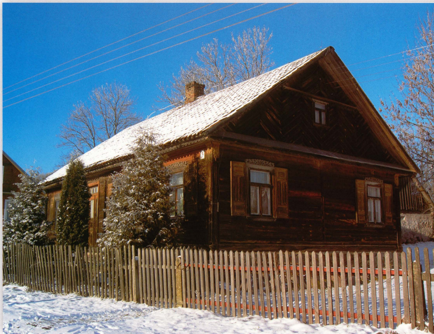
Ostra Góra 3. Dom z początku XX wieku. Uwagę zwracają nad- i podokienniki o rozbudowanej formie zdobniczej.
