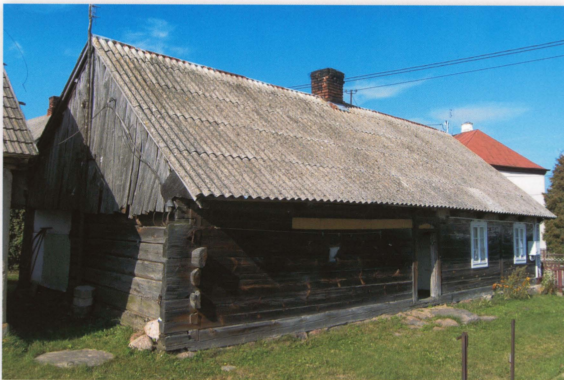
Jaświły 77. Budynek z końca XIX wieku, łączący pod jednym dachem część mieszkalną i gospodarczą (niezachowaną w całości), usytuowany szczytem do drogi. Podwalina spoczywa na fundamentach z kamieni polnych. Dwuspadowy dach kryty eternitem, pierwotnie – strzechą.
