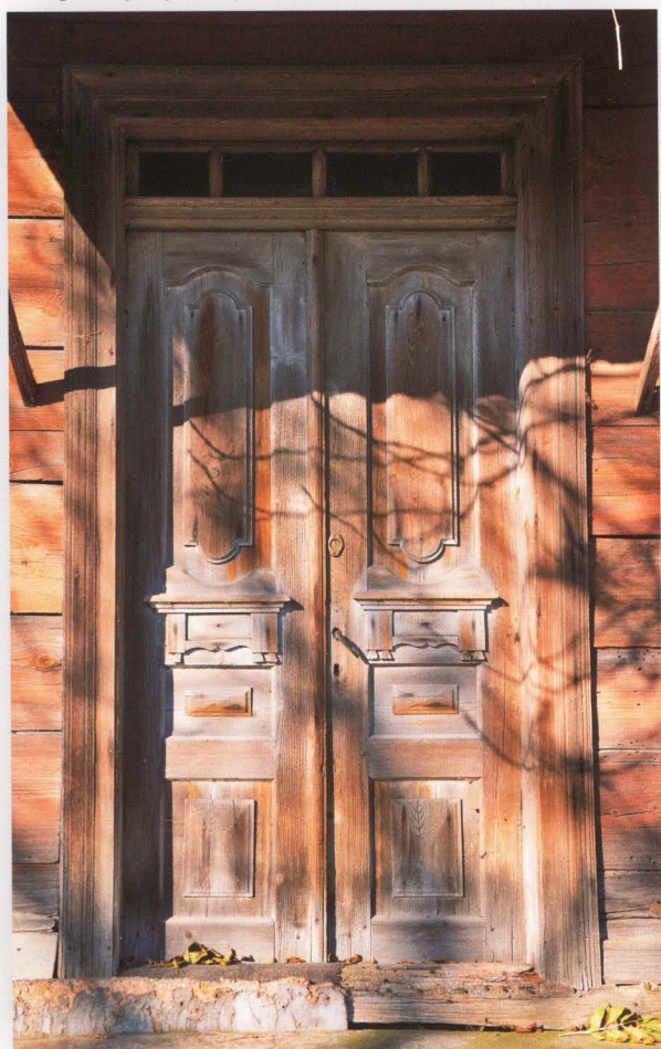
Stare Dolistowo 38. Drzwi zewnętrzne, dwuskrzydłowe, płycinowe, zdobione geometrycznymi motywami. Ponad drzwiami przeszklone nadświetle.
