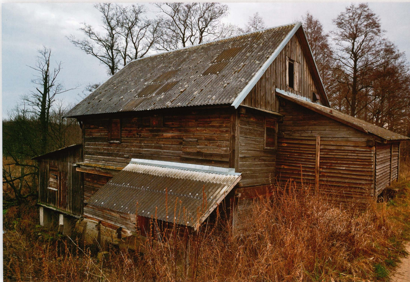
Bobra Wielka. Młyn wodny z przełomu XIX i XX wieku. Budynek dwukondygnacyjny, kilkakrotnie przebudowywany, obecnie nieużytkowany.
