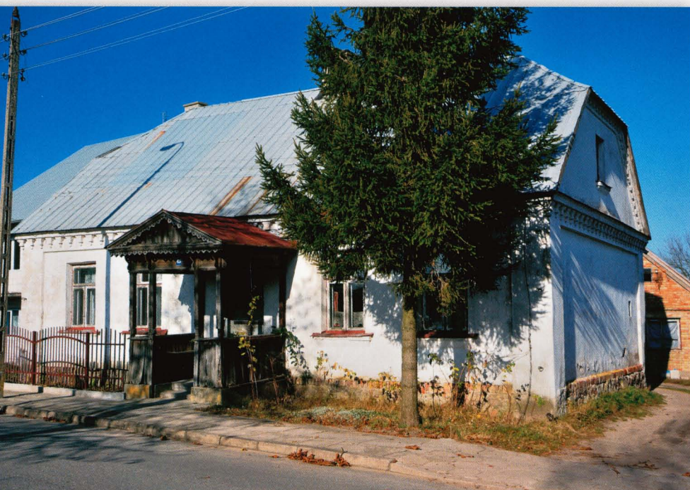
Goniądz, ul. Wojska Polskiego 43. Dom murowany z drewnianym gankiem wybudowany w latach dwudziestych XX wieku. Daszek ganku dwuspadowy, wsparty na sześciu słupkach. Dolna część ganku z prostych, przybitych pionowo desek.
