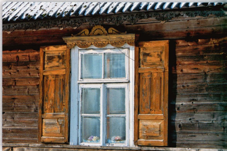
Mroczi. Okno sześciokwaterowe z okiennicami, zdobione nadokiennikiem w formie nalicznika z geometrycznym motywem zdobniczym. Okiennice z trzema płycinami. Widoczna listwa podokapowa.
