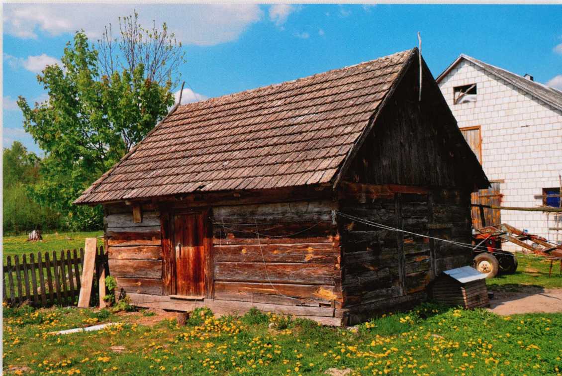
Dubasiewszczyzna. Spichlerz szerokofrontowy, zrębowy, o konstrukcji dachu krokwiowej z elementami wieżby slegowej.
