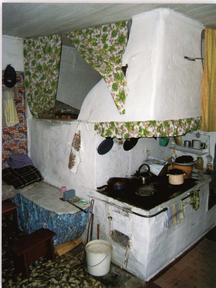
Krasne 6. Wnętrze budynku, w którym zachował się ceglany piec z wnęką do wypieku chleba i kapturem.
