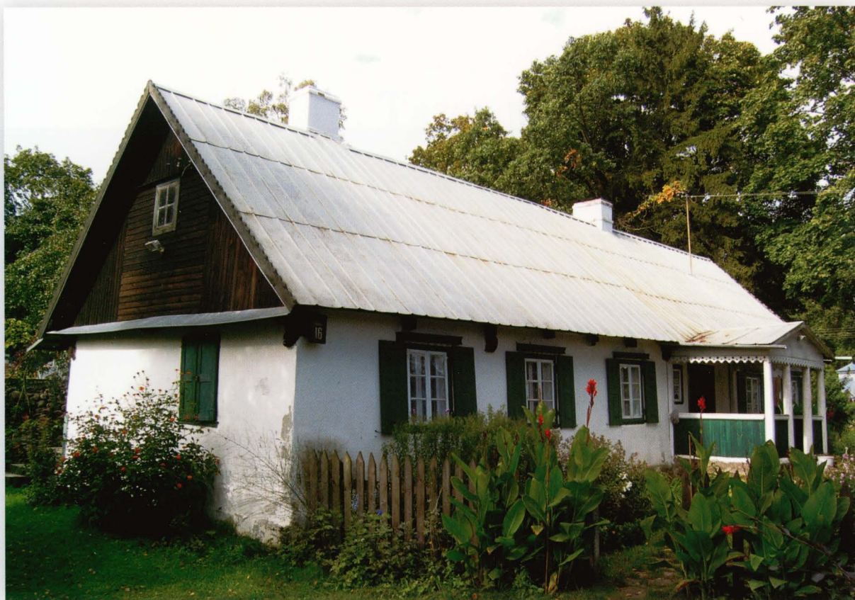
Jaminy 16. Plebania z pierwszej połowy XIX wieku. Ściany otynkowane, bielone. Obiekt pełnił funkcję plebanii, szkoły, posterunku milicji, współcześnie zaś budynku mieszkalnego.
