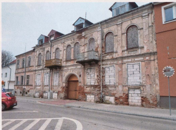
Smutny widok dawnej reprezentacyjnej kamienicy rejenta Wiktora Bielickiego przy ul. 3 Maja 5.
