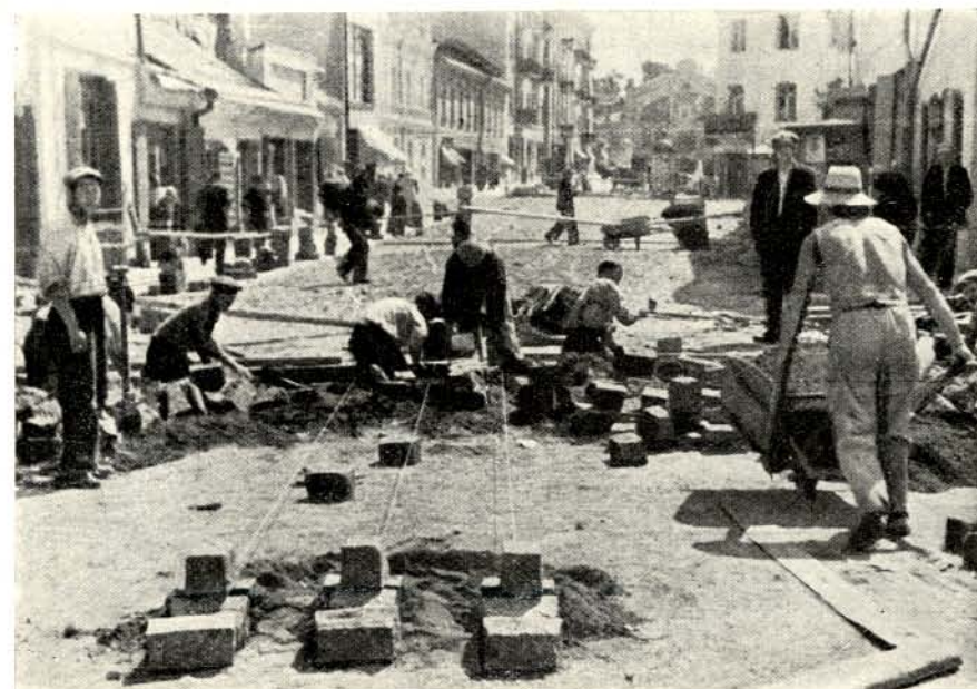
UKŁADANIE GŁADKIEJ NAWIERZCHNI NA UL. ZAWALNEJ.
