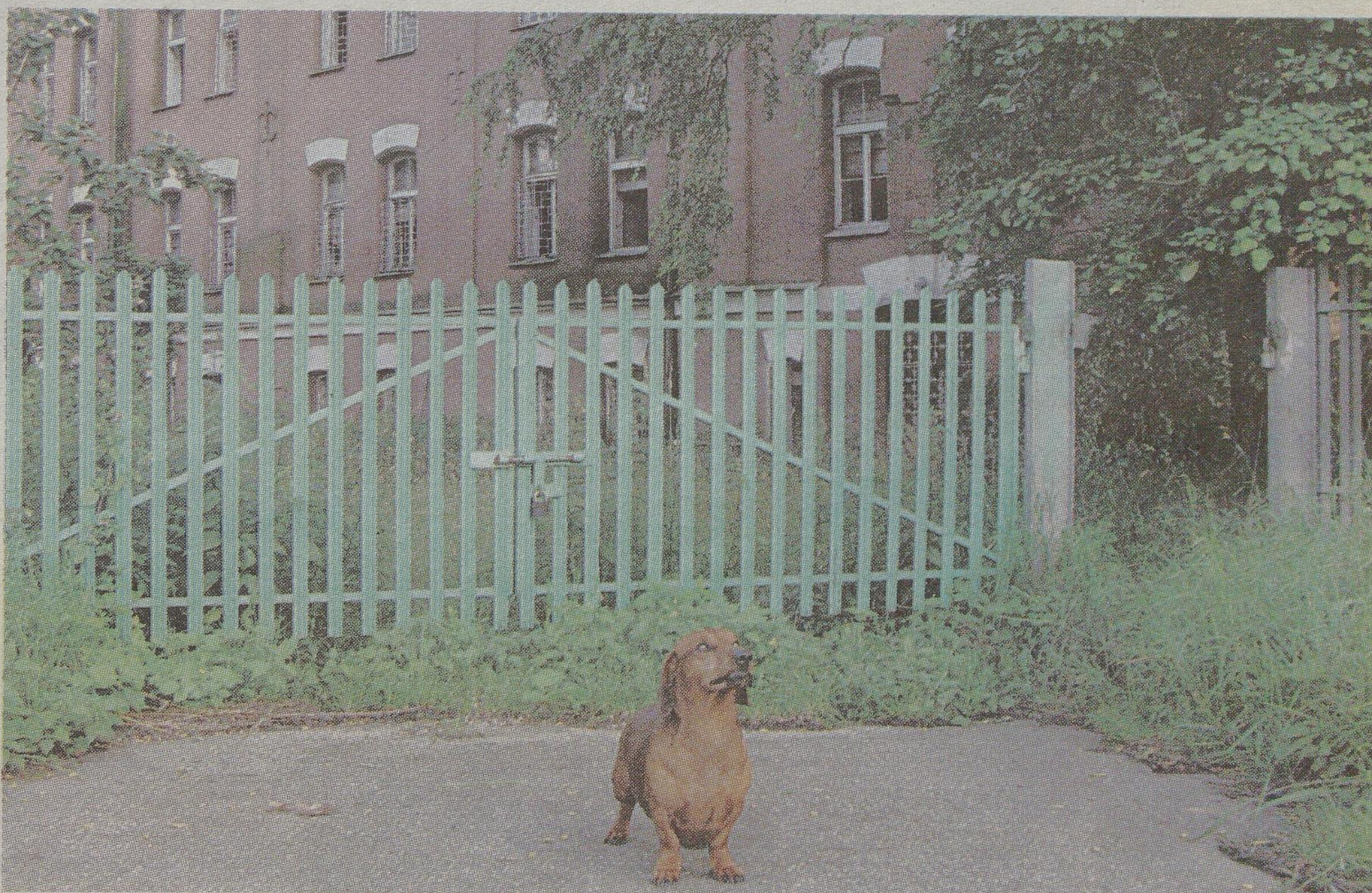
Za płotem niszczeje XIX-wieczny budynek. Urzędnicy sprzedali go szczęśliwi i nie postawili nabywcy żadnych warunków.
