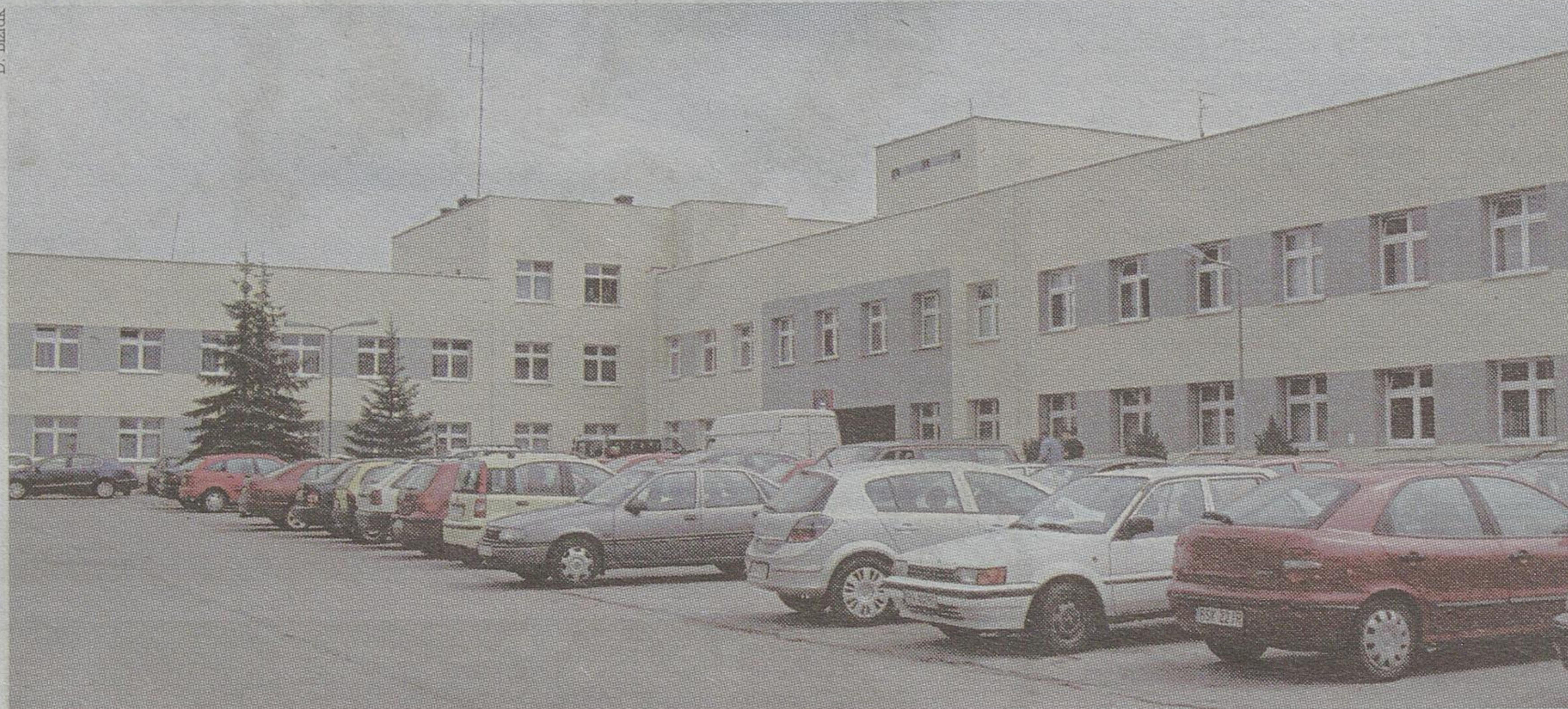
Nowa elewacja to tylko jeden z elementów wykonanych w ramach remontu szpitala
