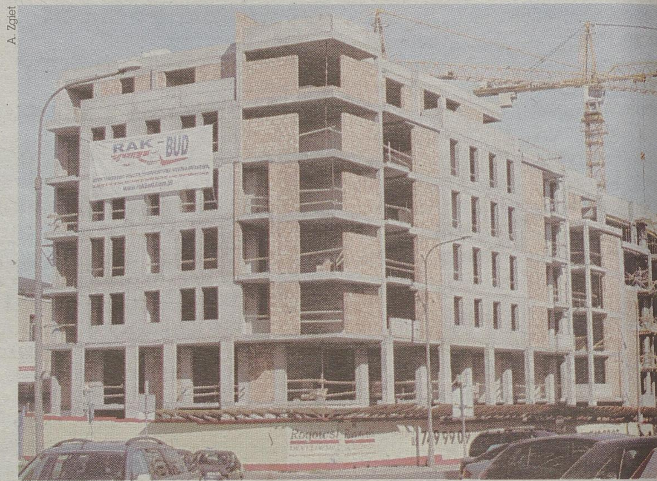
Na najniższej kondygnacji budynku na Nowym Świecie będzie dominował granit i szkło, na wyższych – ceramika i piaskowiec
