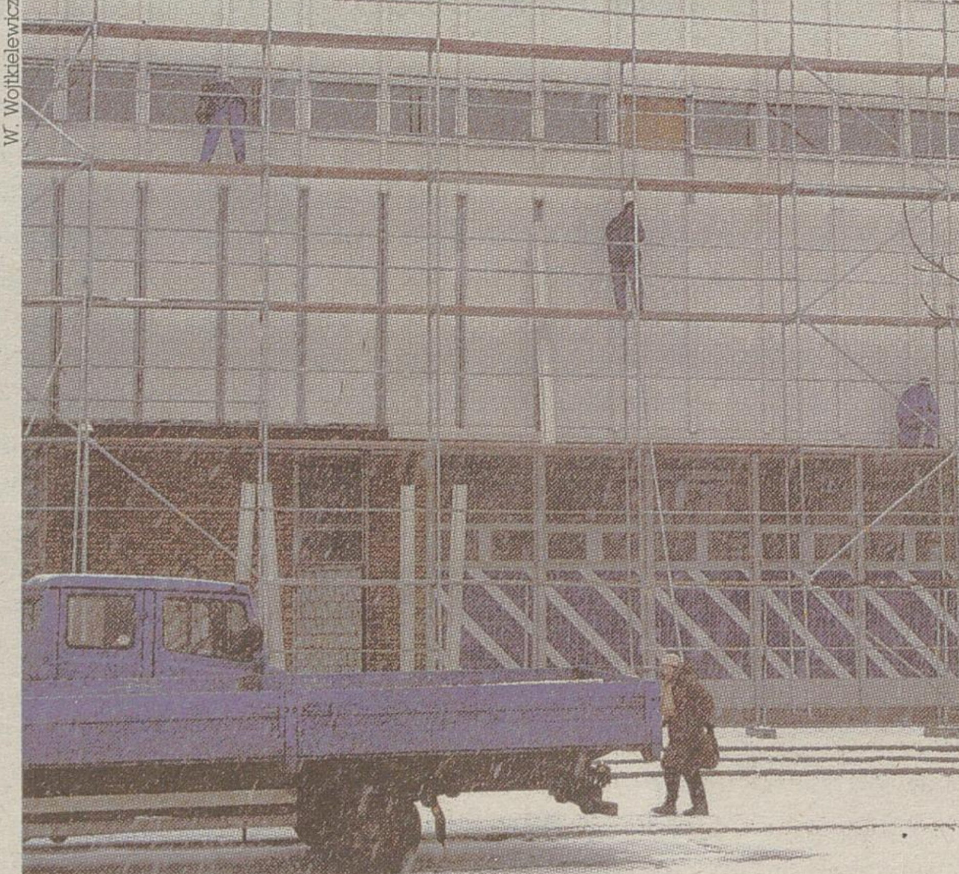
Prace przy rozbiórce pawilonu przy ul. Mazowieckiej idą pełną parą
