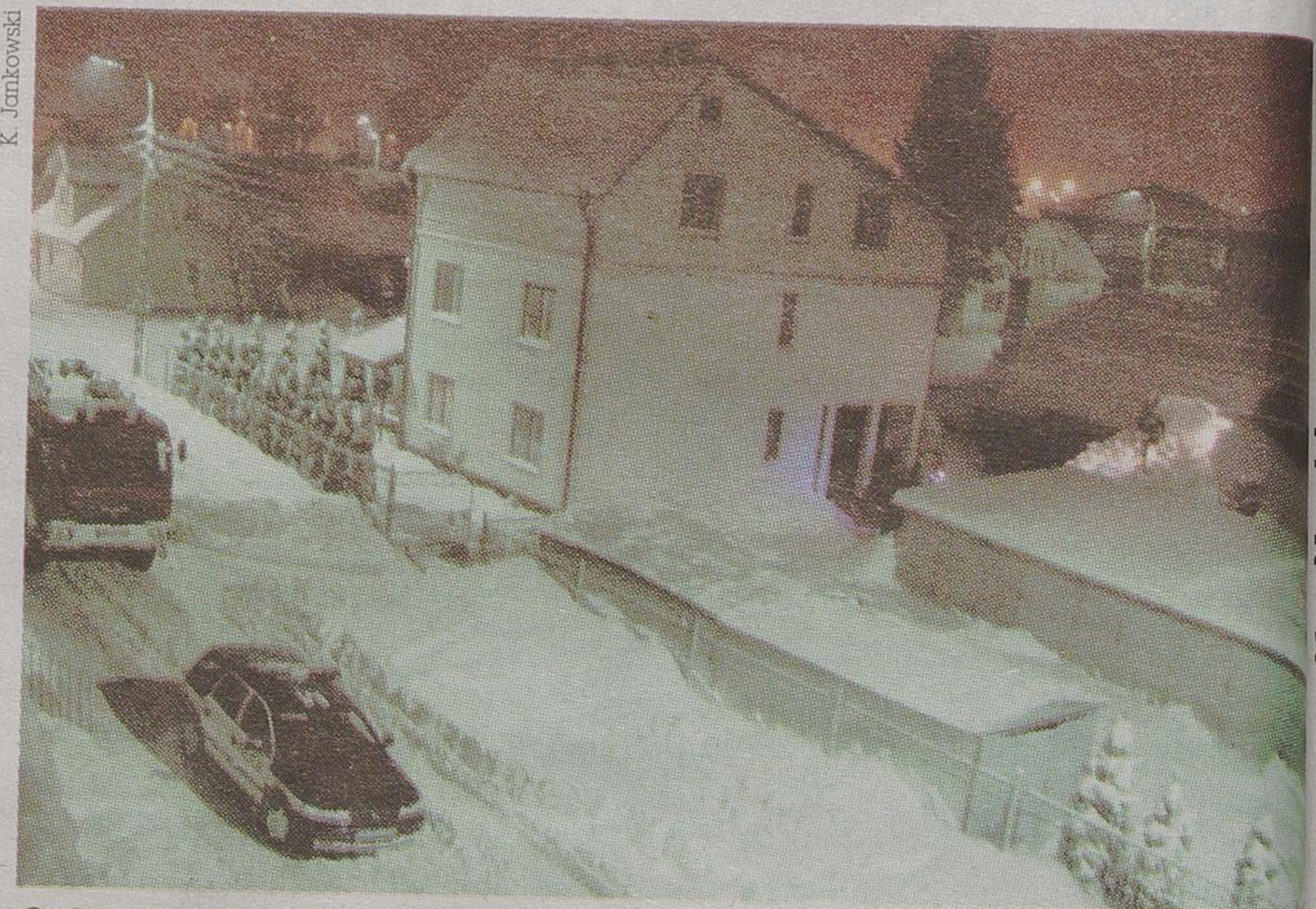
Ostatnio zawalił się dach garażu w Bielsku Podlaskim
