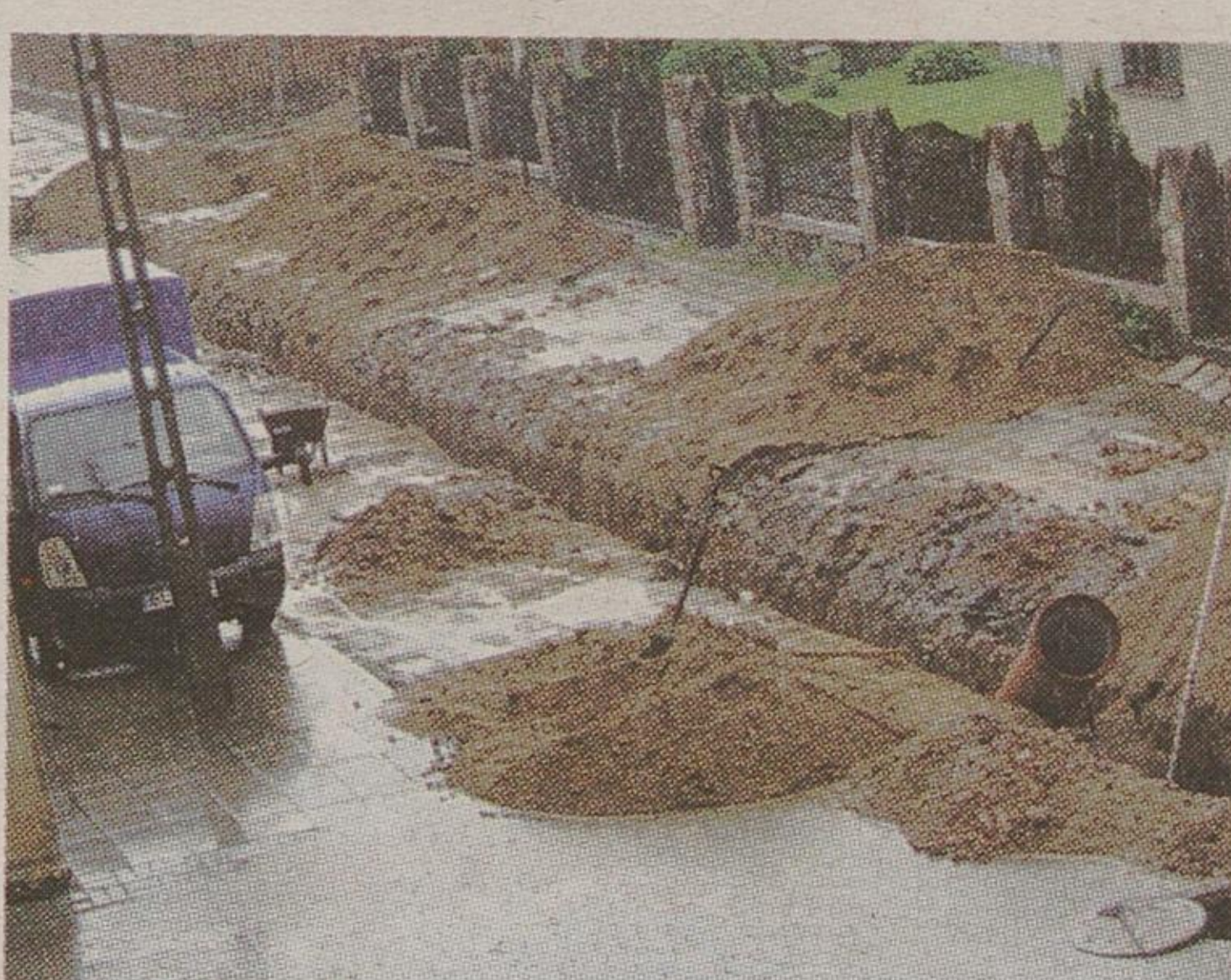
Drogi w Jedwabnem uchodzą za jedne z najlepszych w regionie. Dzięki władzom gminy systematycznie modernizowane są kolejne odcinki
