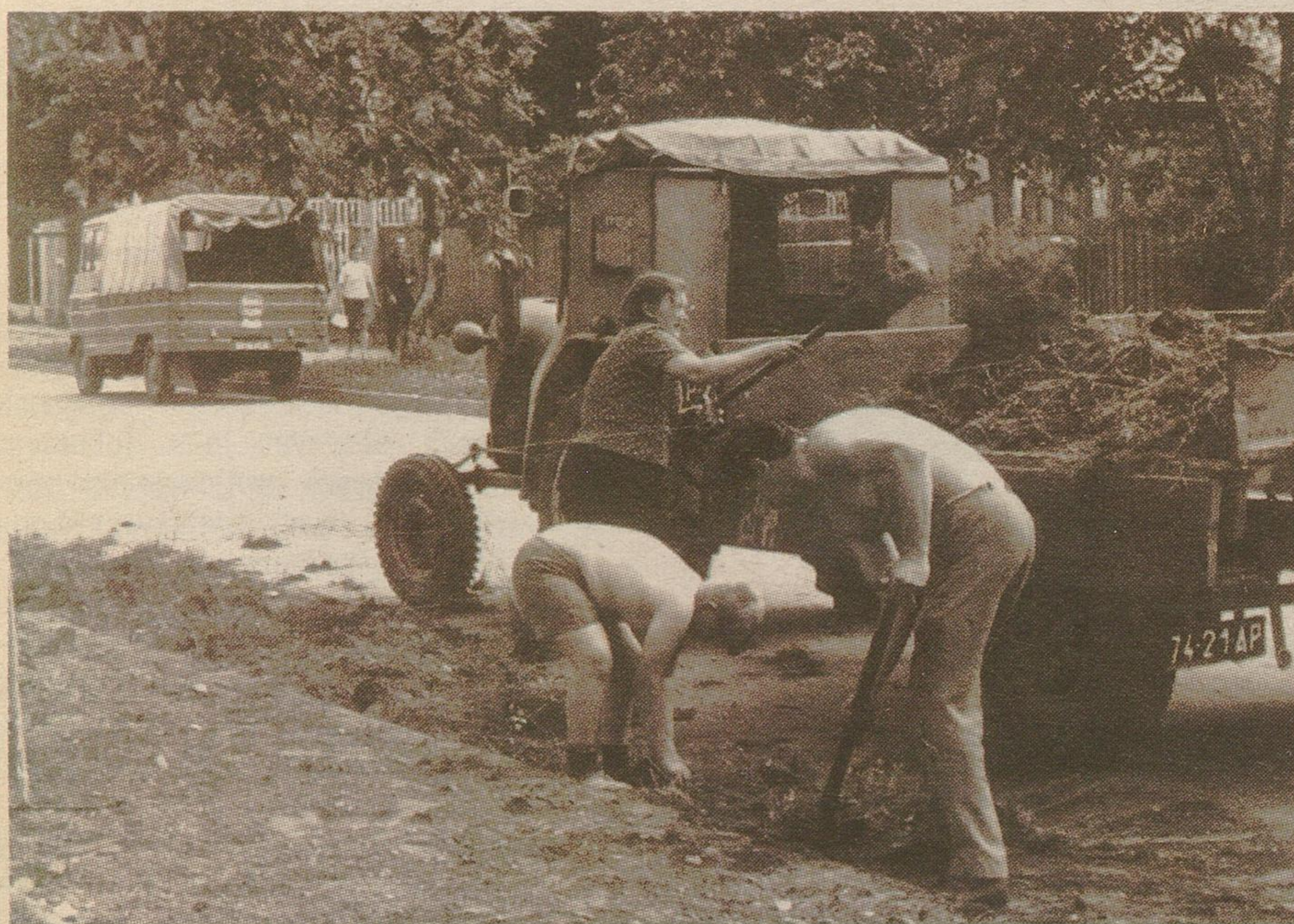
Suwałki, lata 70-te(?). Prace w ramach czynu społecznego na ulicy Nowotki. Śmieci na przyczepę ładuje Jadwiga Kowalewska. Fotografację nadesłał Andrzej Krejczman z Elku.
