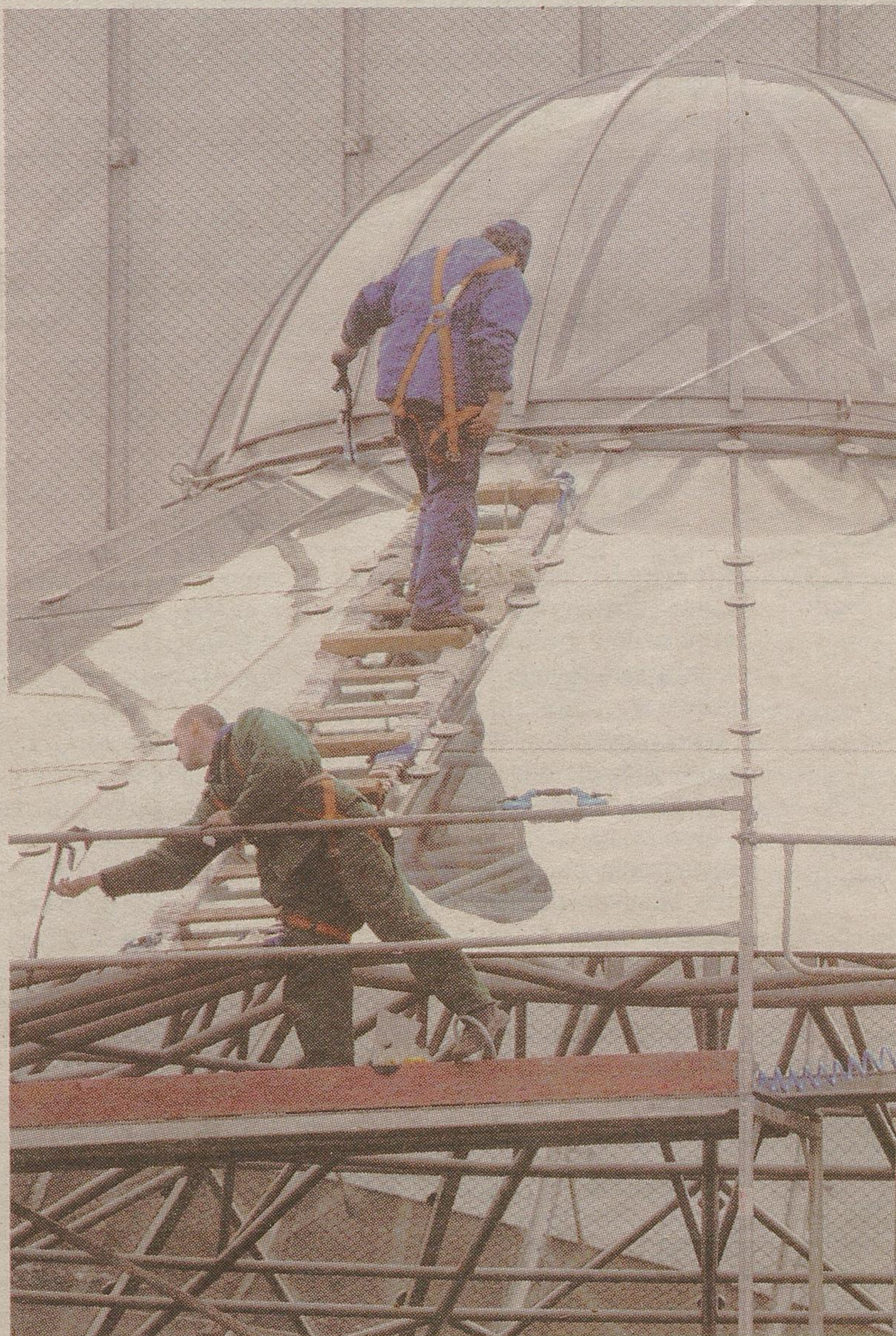
Prace przy budowie Opery i Filharmonii Podlaskiej idą pełną parą. Inwestycja do końca roku pochłonie około 70 mln zł.
