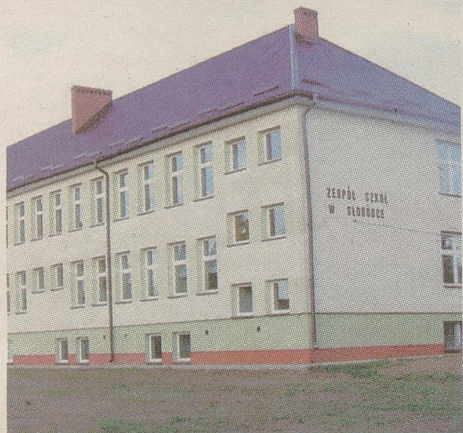
Zmodernizowany w latach 2008/2009 budynek Zespołu Szkół w Słobódce. Remont udało się przeprowadzić dzięki funduszom unijnym i krajowym.
