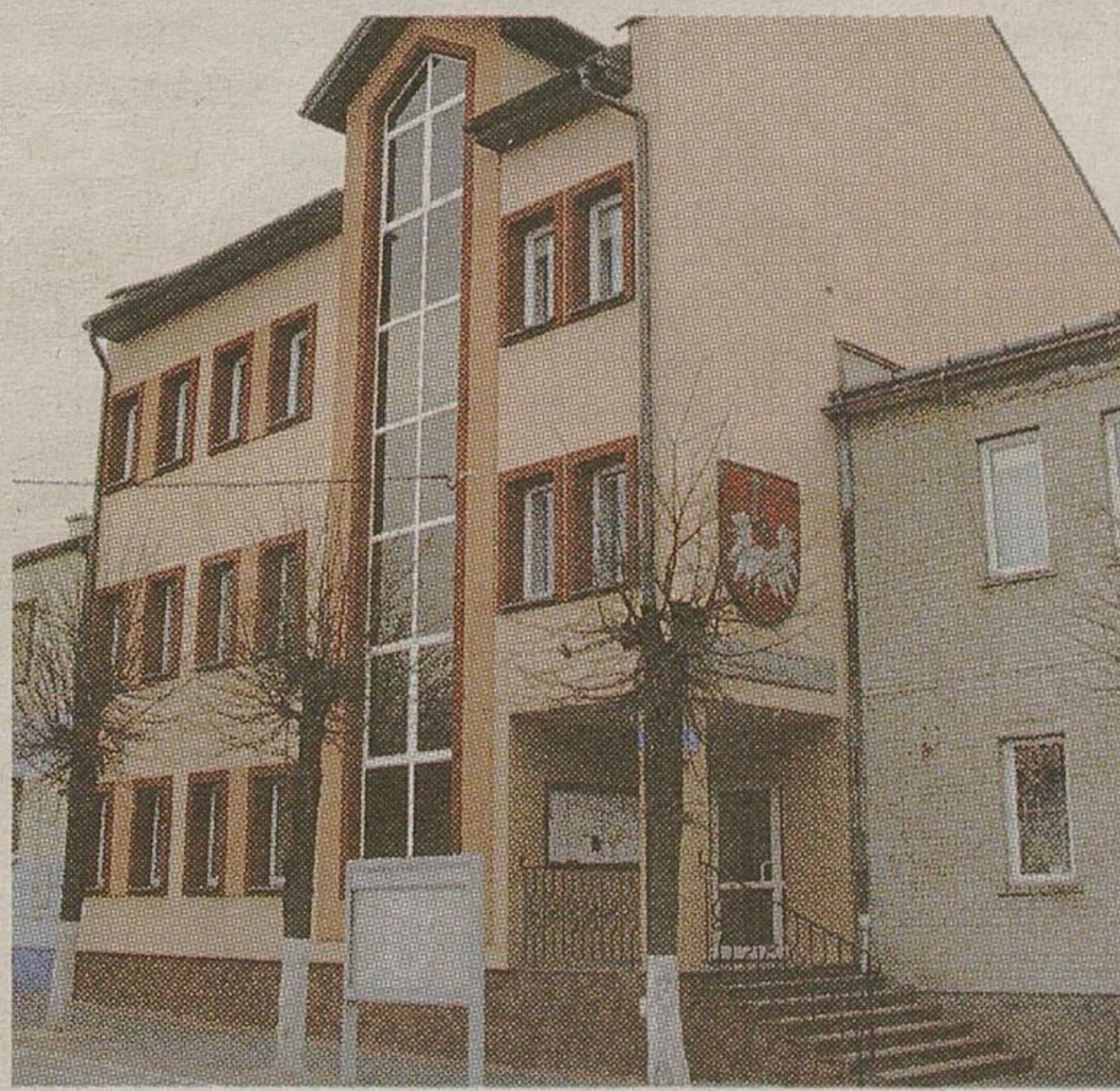
Urząd Gminy mieści się w odremontowanym budynku. Jest jednym z najnowocześniejszych tego typu obiektów w regionie.
