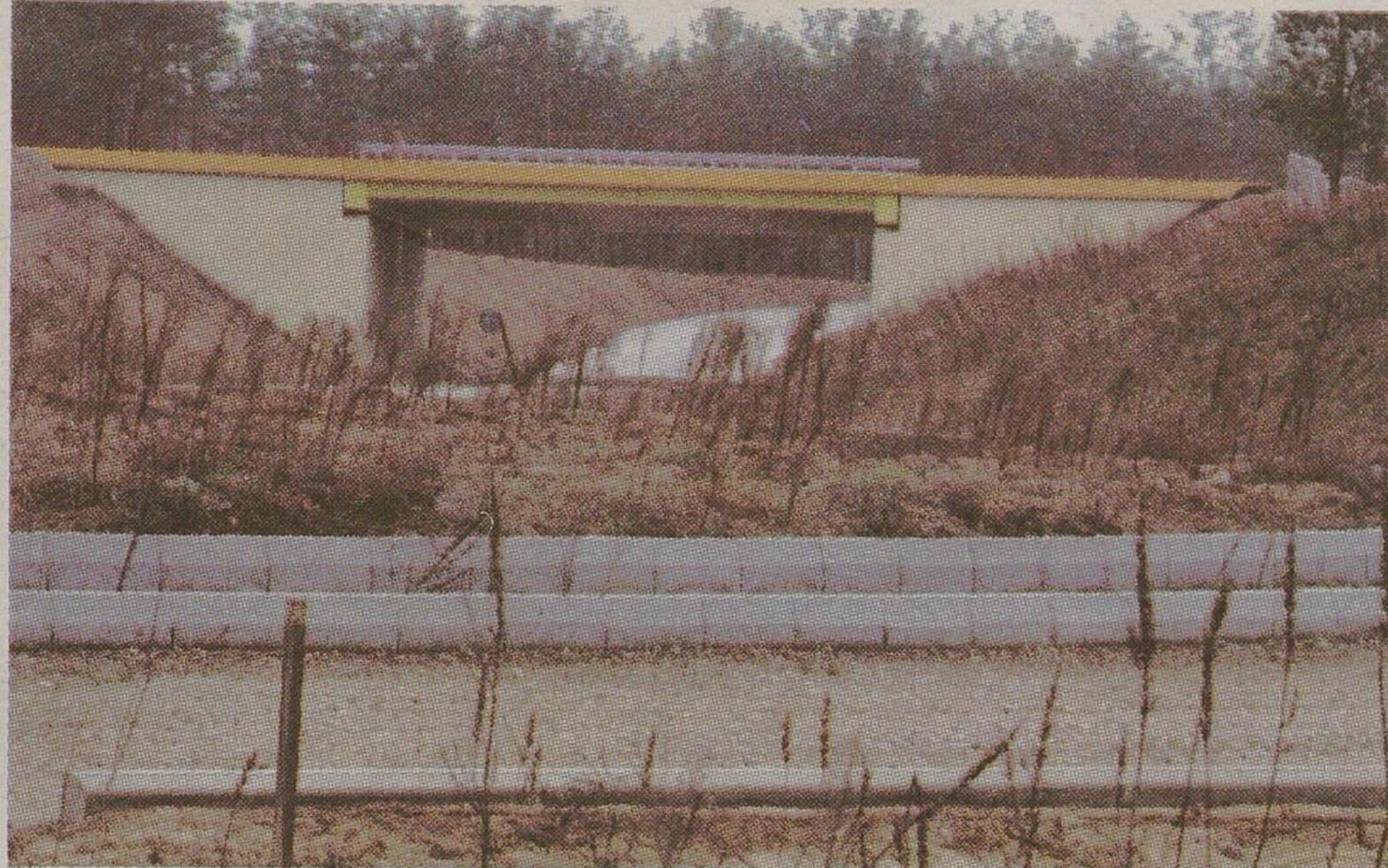
Część robót przy budowie obwodnicy została już wykonana
