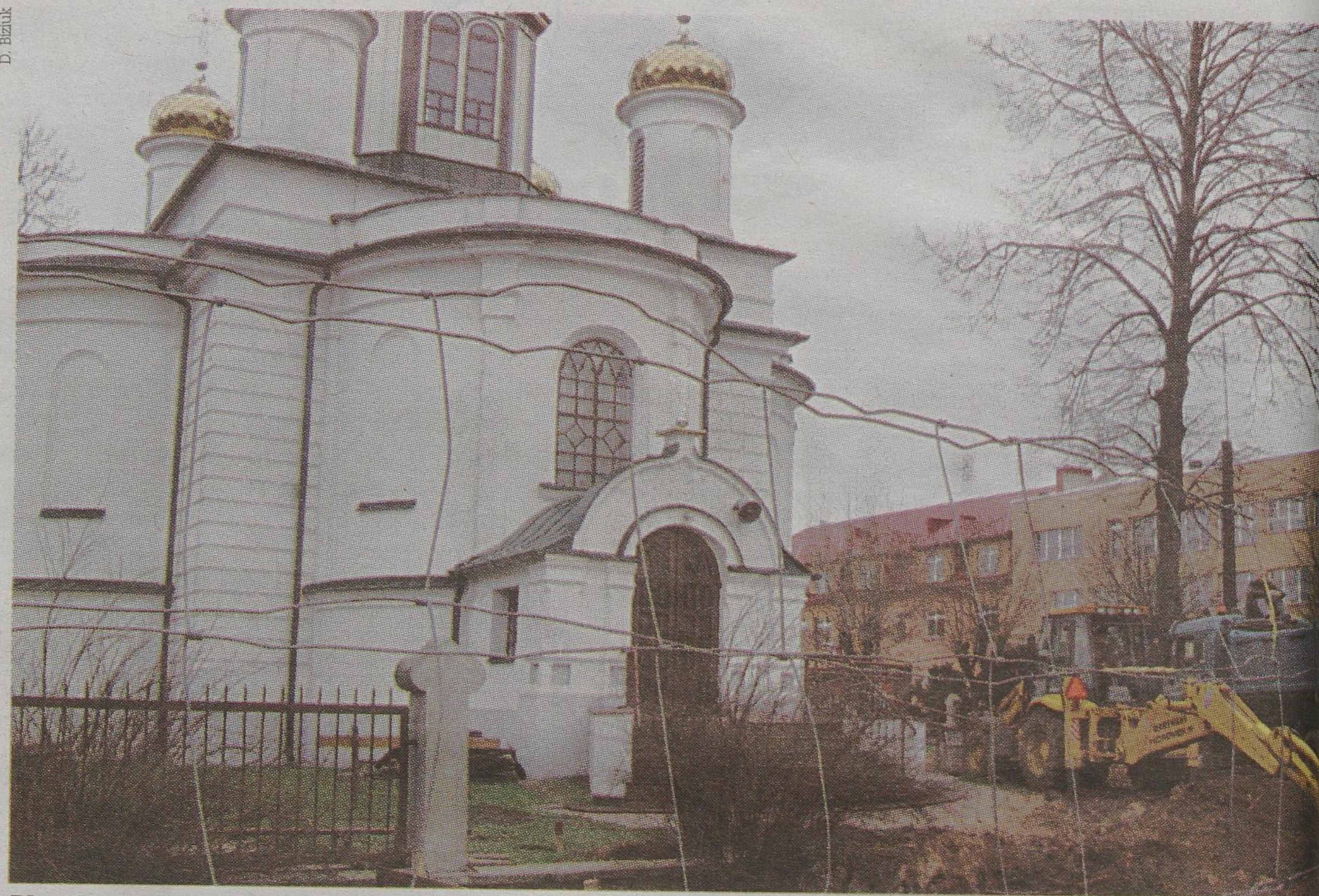
Plac budowy – dzwonnica zostanie zlokalizowana przed głównym wejściem do cerkwi
