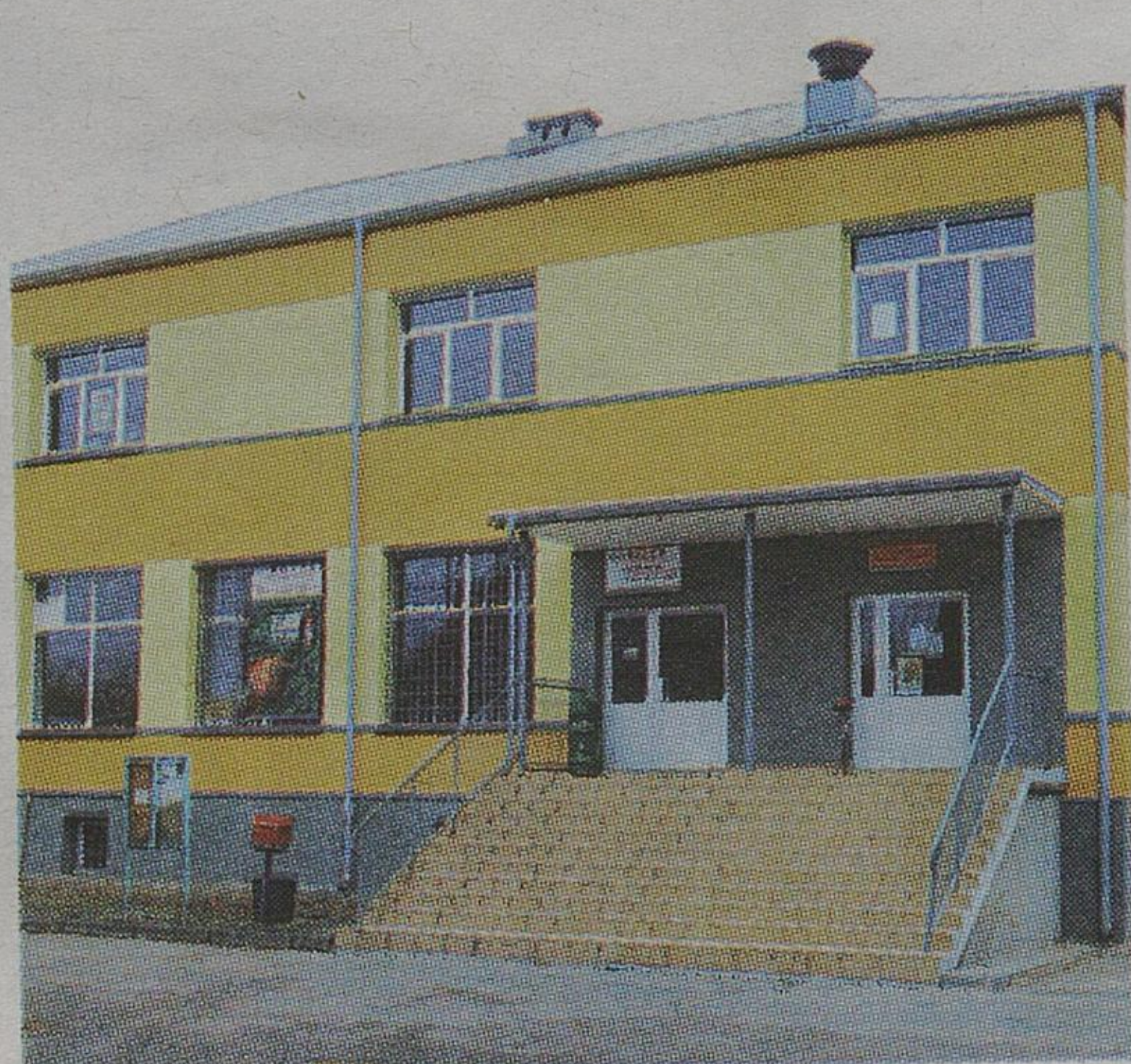
Jedną z ważniejszych inwestycji: docieplenie, remont i zakup wyposażenia Wiejskiego Domu Kultury w Kalinówce Królewskiej
