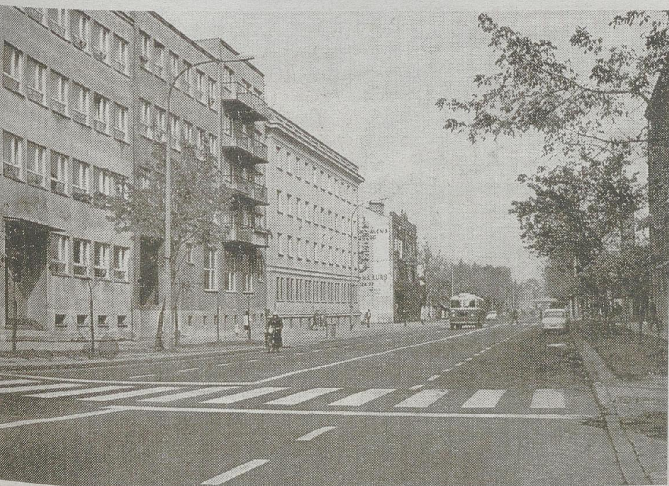
Białystok, 1977 rok. Ulica Sienkiewicza pod wiaduktem kolejowym zmienia swoją nazwę na Wasilkowską. W dawnych czasach był to trakt chochokiewiczowski. Przez ponad 30 lat niewiele się tutaj zmieniło. Nie ma jednak sklepu milicyjnego, który znajdował się w budynku po lewej stronie. No i pojazdów jakby nieco na ulicy było mniej – napisał Marian Olechnowicz z Łap.
