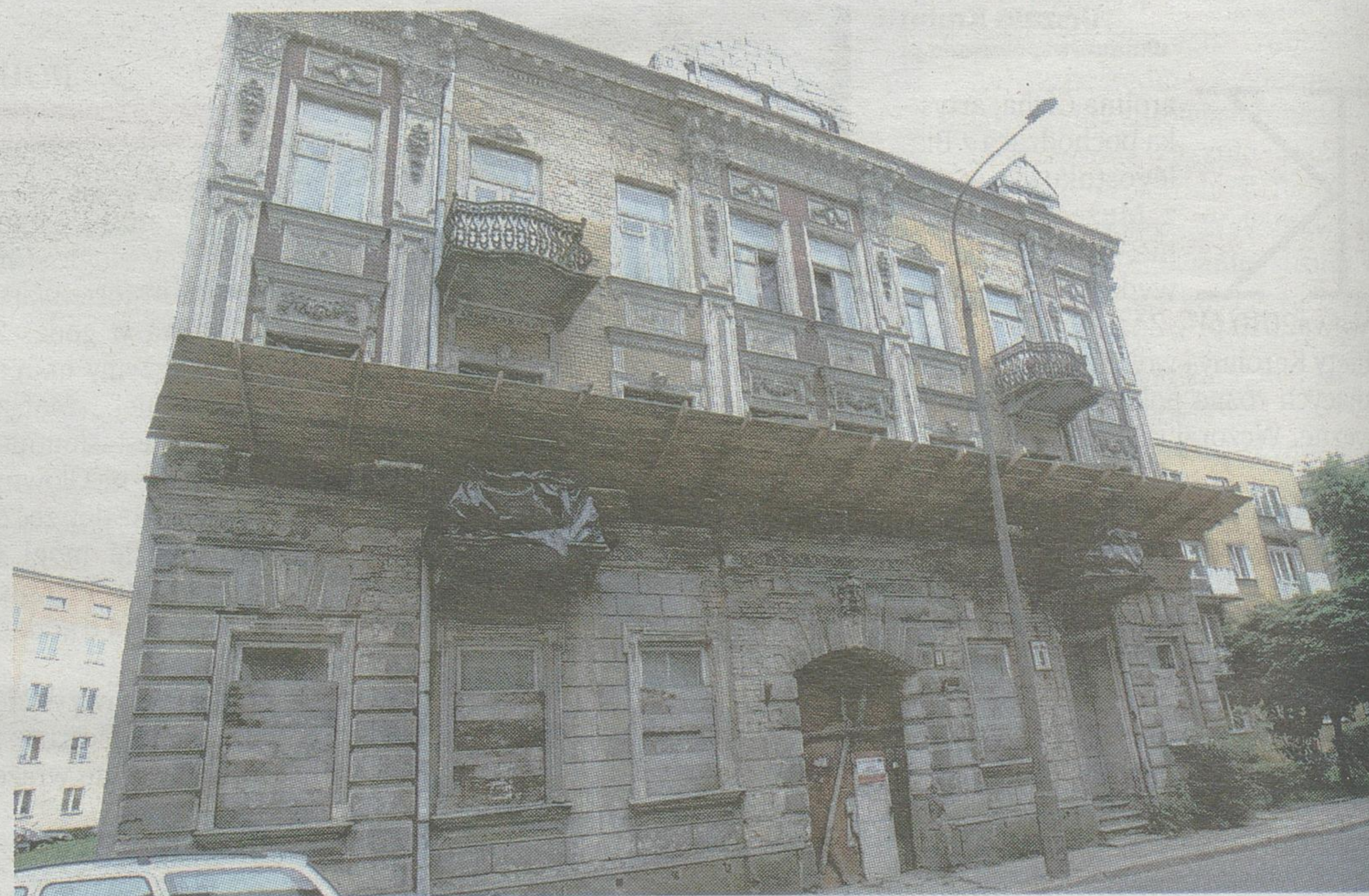
Ta kamienica jest dziś bardzo zaniedbana. Właściciel zapewnił, że robotnicy pojawią się tutaj już na początku jesieni.
