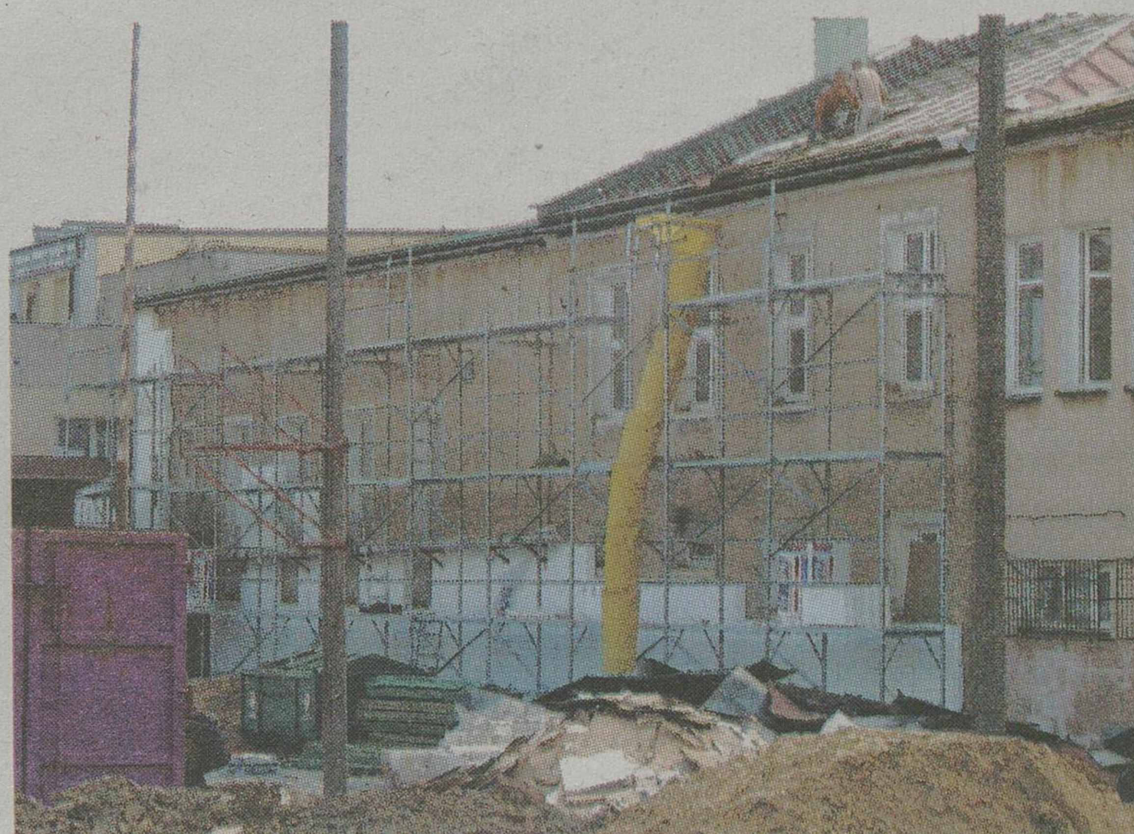
W pierwszym etapie modernizacji I LO uzyska nowy dach, zabudowę wewnętrznego dziedzińca i elewację
