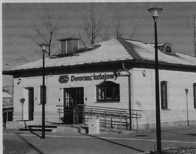
Tak wygląda dworzec kolejowy w Szepietowie po remoncie za prawie 5,5 mln zł (z unijną dotacją). „Wcześniej to była ruina”, mówił w czasie otwarcia burmistrz Szepietowa Robert Wyszynski.
